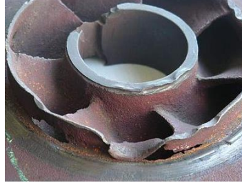
Şekil 4.6 Bir santrifüj pompada kavitasyon sonucu oluşan aşınma. (Wikiwand)
