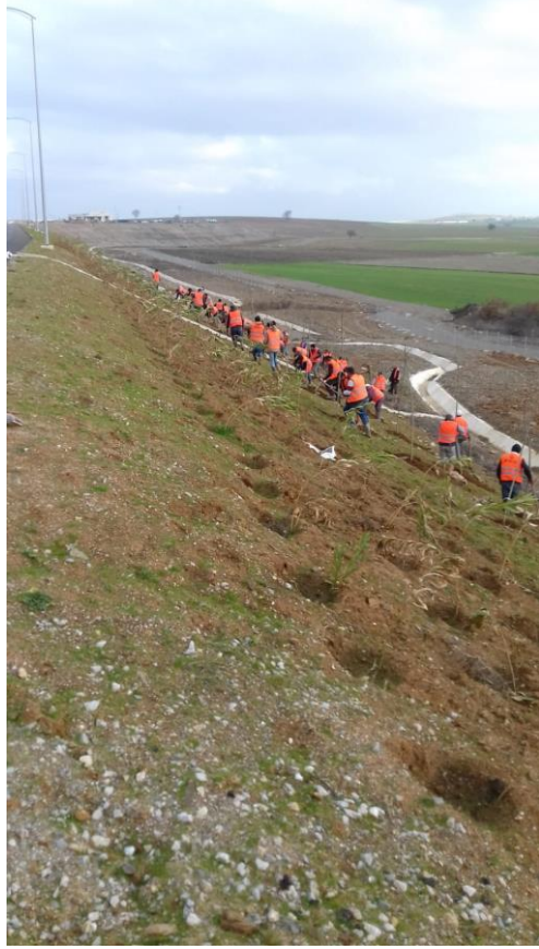
5. Şevlerde çalı fidanlarının çukur açılması ve dikimi
