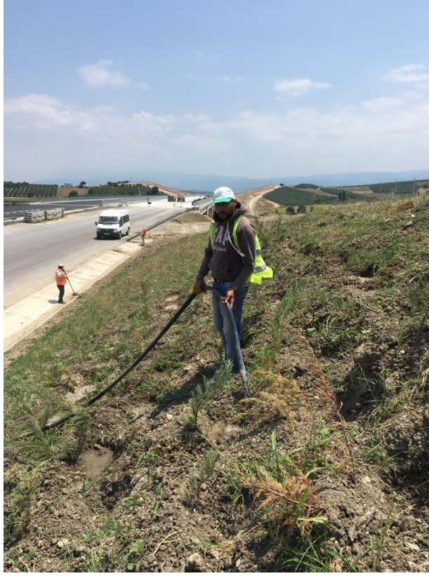
13. Dikimi yapılan fidanlara can suyu verilmesi
