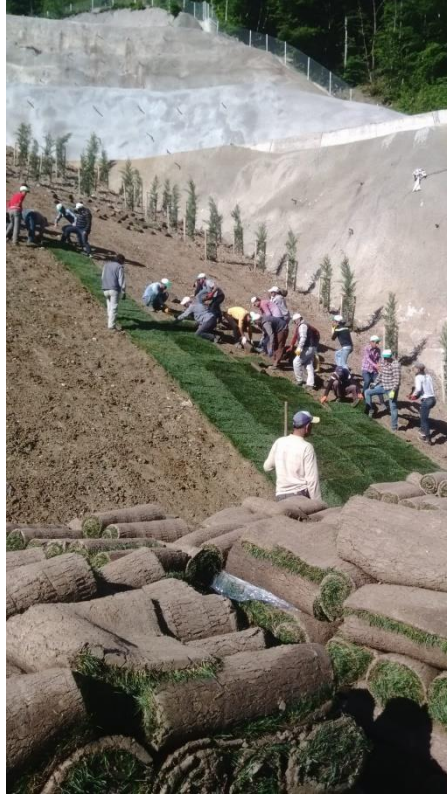
12. Tünel giriş-çıkışı şevlerde rulo çim uygulaması
