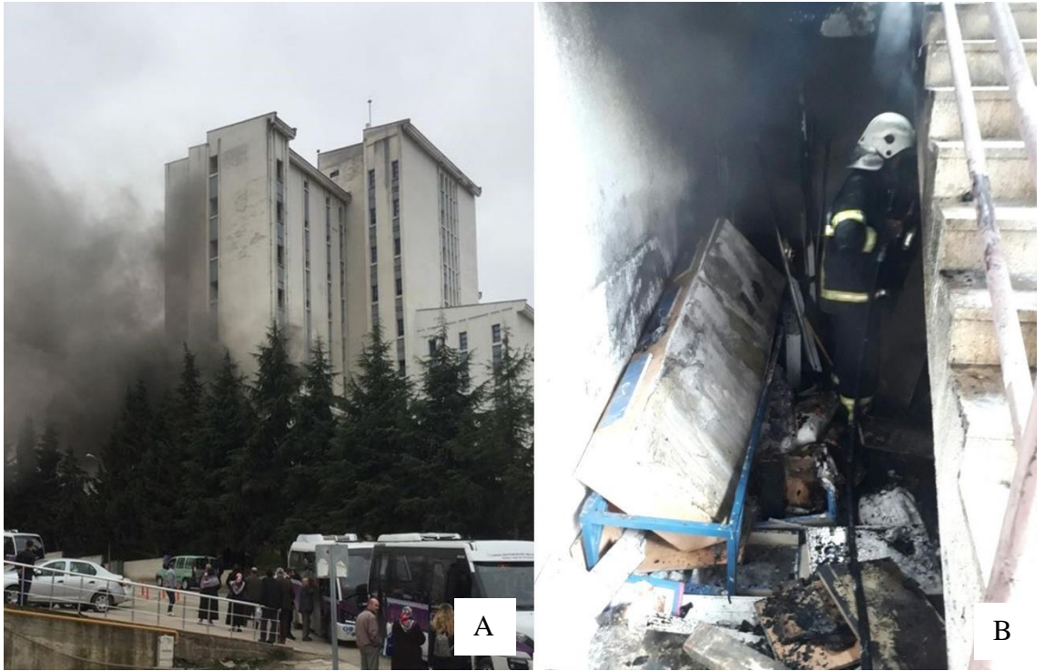
Şekil 2.6. Ordu Devlet Hastanesi'nde çıkan yangının görüntüleri (Akyürek 2018) A) Yangın anı B) Yangının çıktığı noktanın söndürülme sonrası görüntüsü
