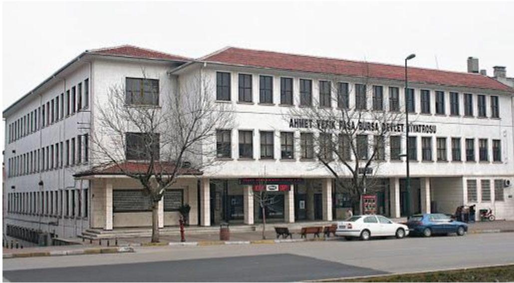
Şekil 4.2. AVP Bursa Devlet Tiyatrosu giriş bölümü
