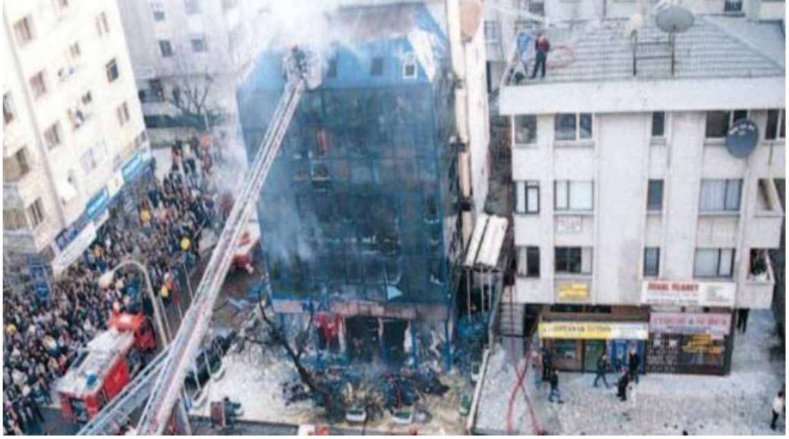
Şekil 2.17. Mavi Çarşı binası yangın söndürme çalışmaları (Anonim 2019e)
