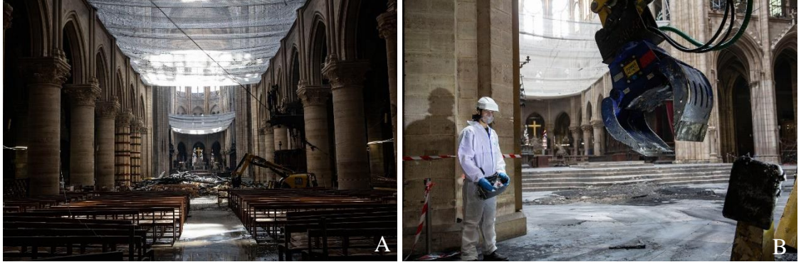
Şekil 2.27. Katedralde yürütülen stabilizasyon ve kurtarma çalışmaları (Zachmann 2019) A) Koro alanı B) Orta çapraz
