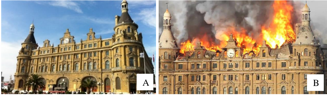
Şekil 2.16. Haydarpaşa Gar'ı yangın görüntüleri (Anonim 2016c) A) Yangın öncesi B) Yangın anı
