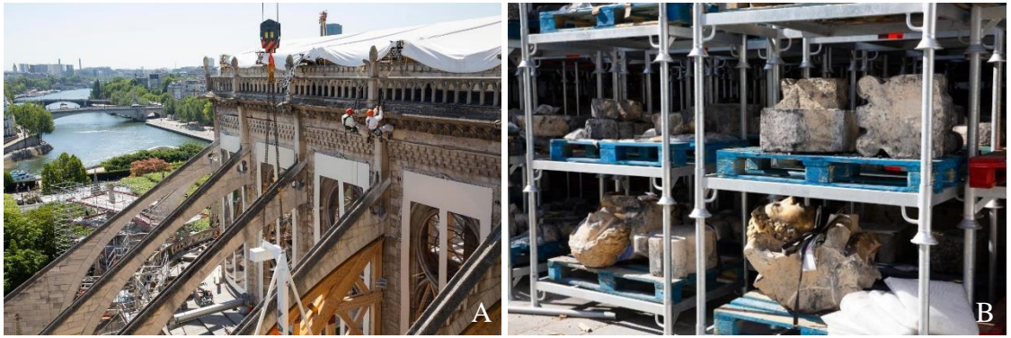
Şekil 2.28. Katedralde yürütülen stabilizasyon ve kurtarma çalışmaları (Zachmann 2019) A) Uçan payandalar B) Değerli eşyalar
