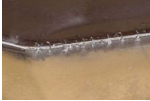
Şekil 2.25. Termal çatlaklar (Anonim 1990b)
