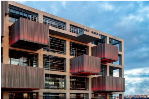
Şekil 2.33. İstanbul Resim ve Heykel Müzesi, cephe (Emre Arolat Architects)
