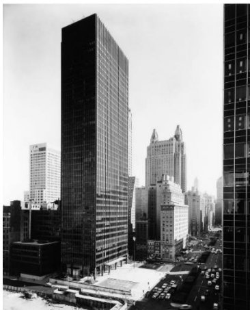
Şekil 2.22. Seagram Binası, Mies van der Rohe, ABD, 1958 (Stoller 1958)
