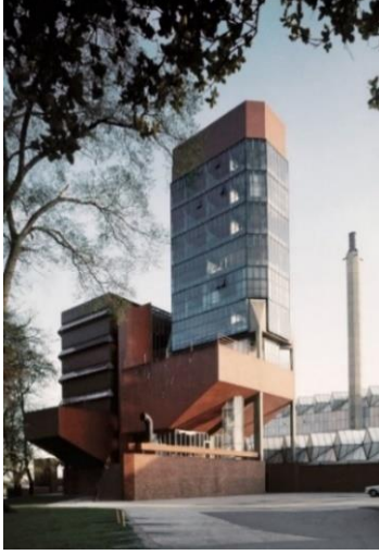
Şekil 2.35. Mühendislik Binası, Leicester (Anonim 2020b)
