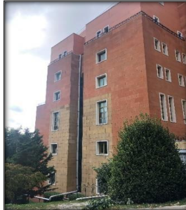
Şekil 2.36 Yeditepe Üniversitesi'nde bulunan yağmur suyu toplama sistemi (Anonim 2019t).
