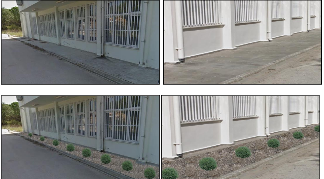
Şekil 4.8 Sağlık Sosyal Eğitim Enstitüsü binası mevcut durumu ve infiltrasyon bitki kutusu uygulaması
