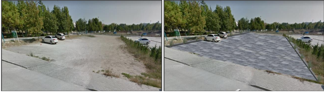
Şekil 4.10 Otoparkların mevcut durumu ve geçirimli yüzey kaplama uygulaması
