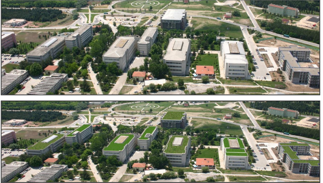
Şekil 4.5 BUÜ Görükle Kampüsü Eğitim Binaları mevcut çatıları ve yeşil çatı uygulaması (Anonim 2020d)
