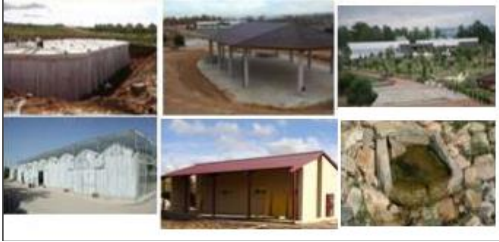
Şekil 2.25 Çatısından su toplama sistemi bulunan Oditoryum, Soyunma Kabini Binaları ve Seralar (Anonim 2019i)
