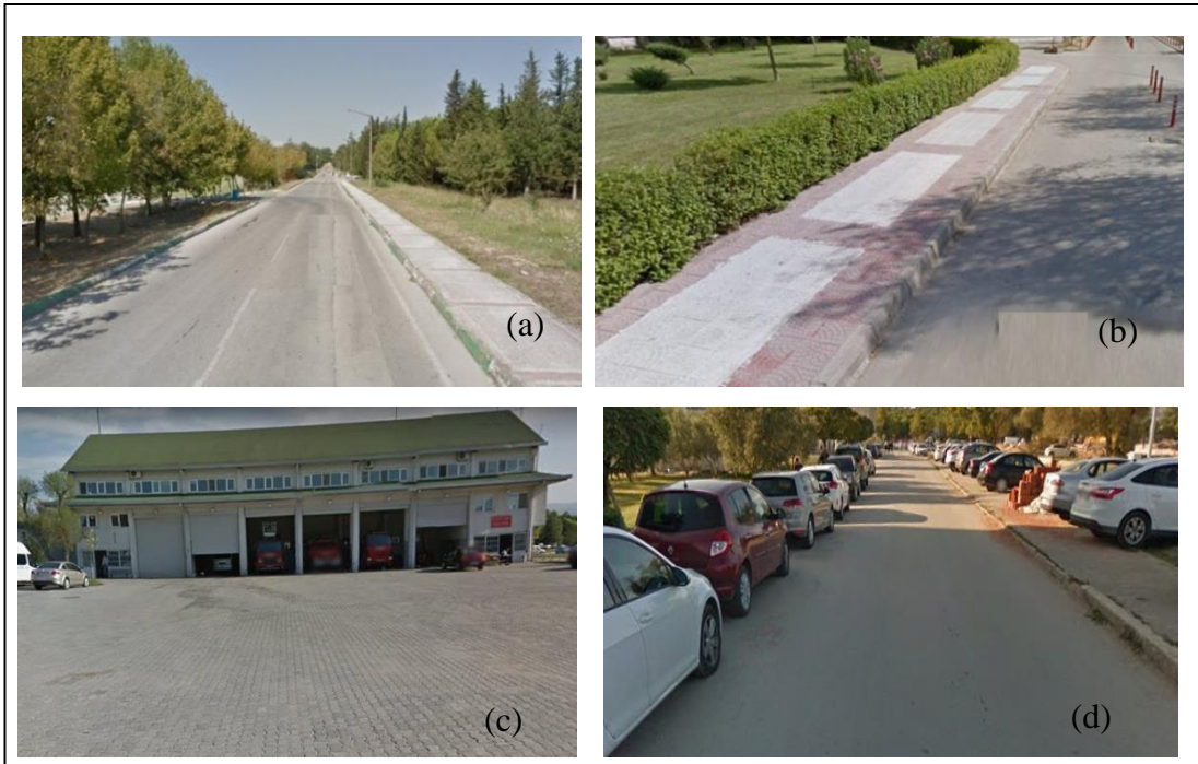
Şekil 3.10 BUÜ Görükle Kampüsünde bulunan (a)Asfalt yollar ve Beton kaldırımlar (b)Küp taş kaldırımlar (c)Küp taş bölgeler (d) Beton alanlar
