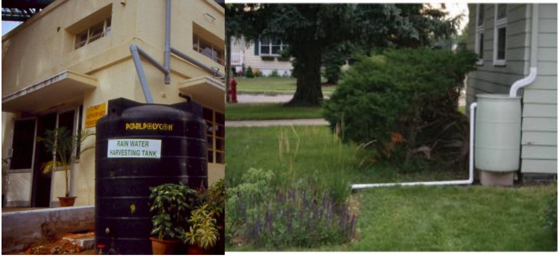
Şekil 2.5 Yağmur suyunun hasadının yüzeyde depolama tankı ve varil ile depolama sistemi (Anonim 2020e, Feehan ve ark., 2014)
