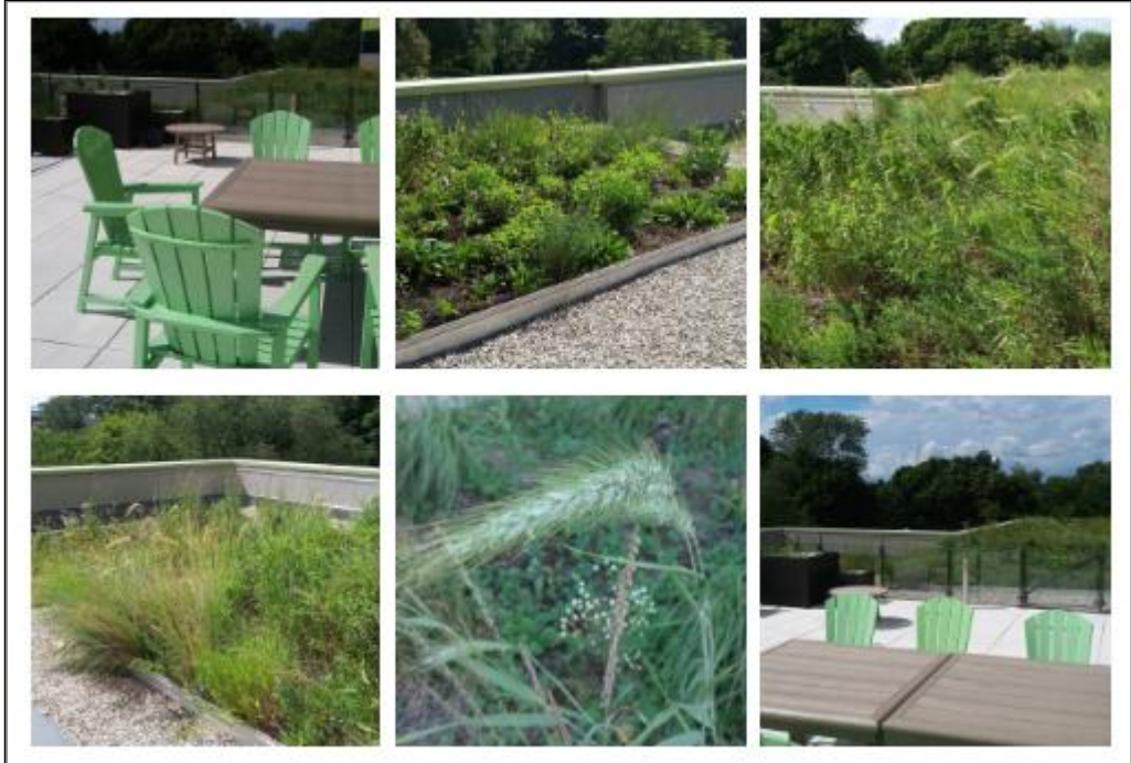
Şekil 2.33 Waterloo Üniversitesi Çevre Bölümü binasının yeşil çatı bölümü (EDUW 2019)
