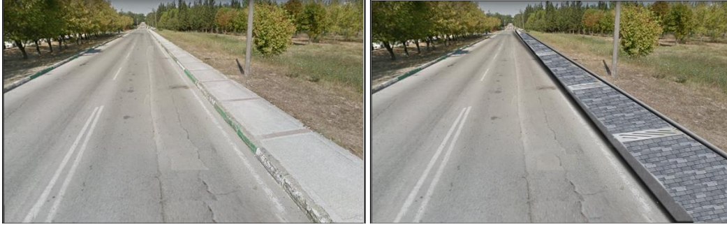
Şekil 4.9 Yol ve kaldırımın mevcut durumu ve geçirimli yüzey kaplama uygulaması (Google Earth 2019)
