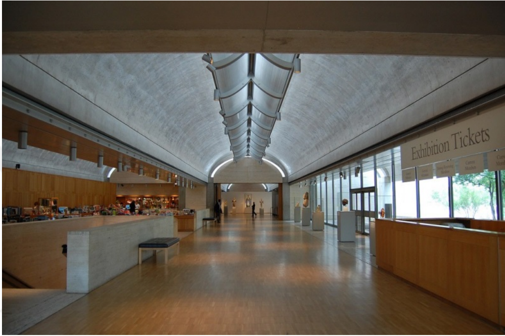
Şekil 6.2. Kimbell Sanat Müzesi, beton tonozların birleşimi ve ışığın içeri süzülmesi. (www.mimoo.eu)
