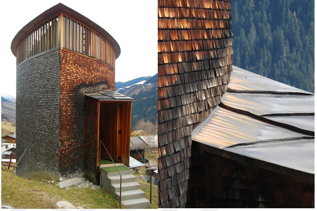
Şekil 6.12. Zumthor malzeme ile yerin zaman içindeki değişimini görünür kılmaktadır. Saint Benedict Şapeli, İsviçre, 1989 ( http://locusiste.org/buildings/488/st-benedict-chapel/ )
