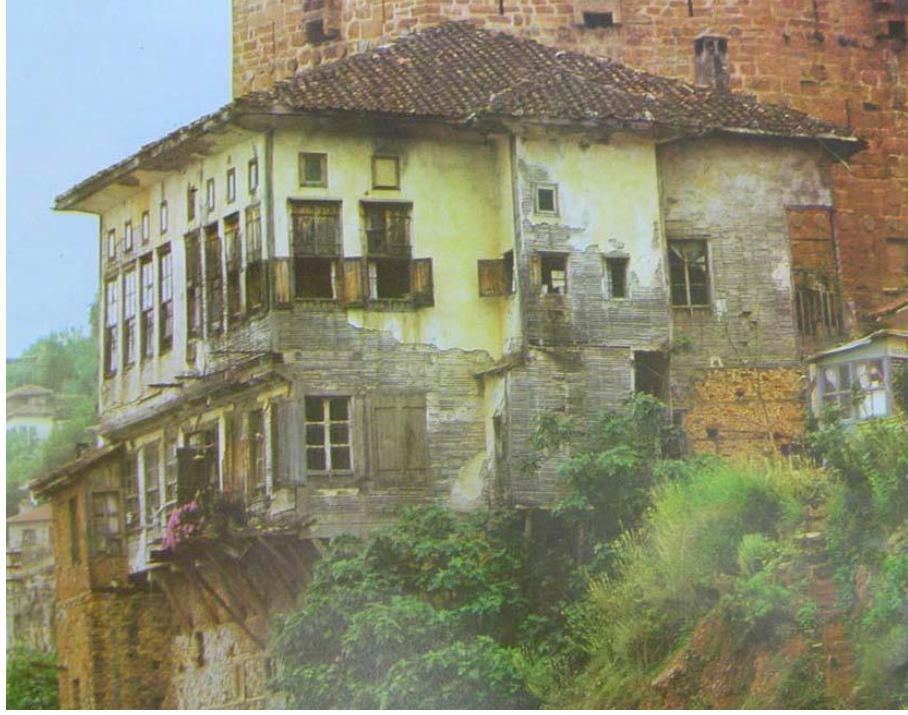
Şekil 6.12. Alanya, karkasın üzerine bağdadi çıtaları çakılmış (Özhan 2006)
