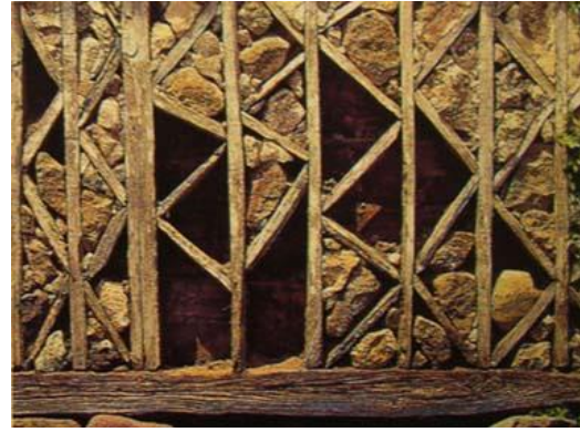
Şekil 6.5. Muskalı dolma tekniği (Günay 1998)
