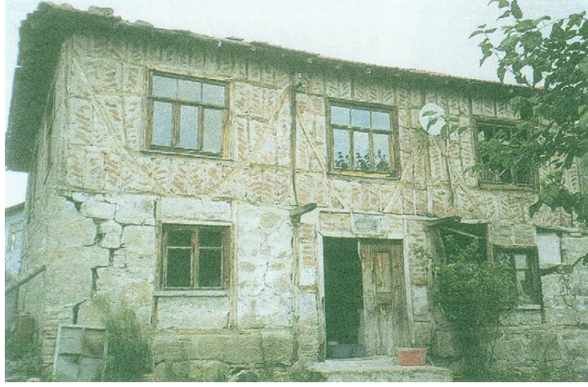
Şekil 7.2. 1999 Düzce depremi (Parsa 2001)
