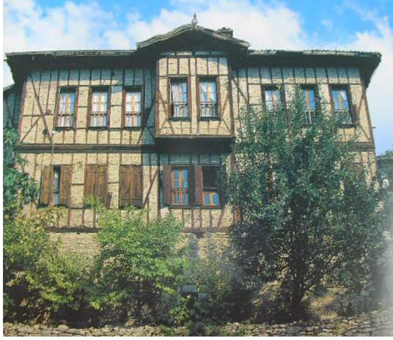
Şekil 6.2. Safranbolu, ahşap karkas duvar yüzeyine dönüştürülmüş (Küçükerman ve Güner 1995).
