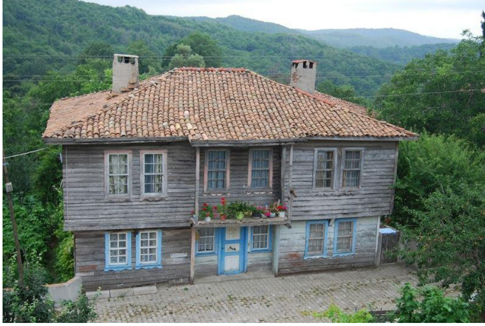
Şekil 6.10. İstanbul, Şile bağdadi çıtalı ahşap yapı
