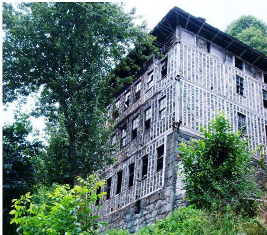
Şekil 6.3. Hemşin, Veziroğlu Konağı, göz dolma uygulaması
