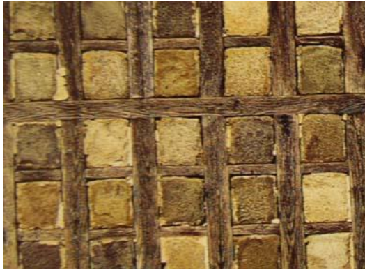
Şekil 6.4. Göz dolma tekniği (Günay 1998)
