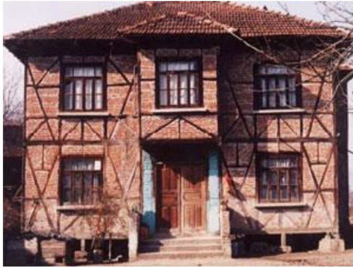
Şekil 6.7. Tuğla dolgulu ahşap karkas ( http://www.restorasyonforum.com , 2009)
