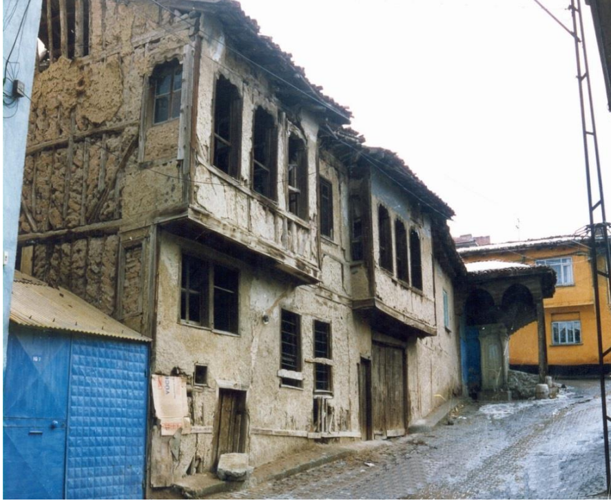
Şekil 6.6. Eskişehir Paşa Mahallesi, Ayvazlar Konağı (kerpiç dolgu) ( http://odunpazarihouses.com , 2011)
