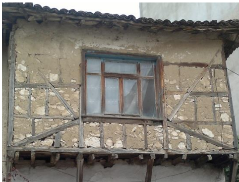
Şekil 6.30. Görükle ahşap konutlar
