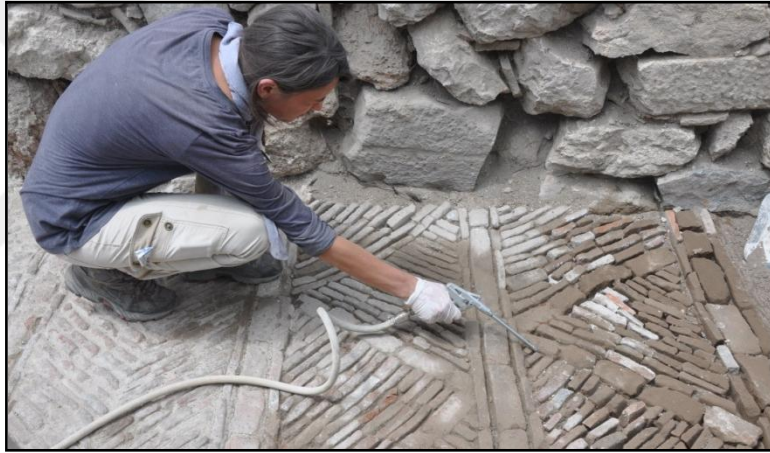
Resim 41: Konservasyon Uygulamaları, Pişmiş Toprak Parçaların Derz Temizliği (Kibyra Kazıları Arşivi)
