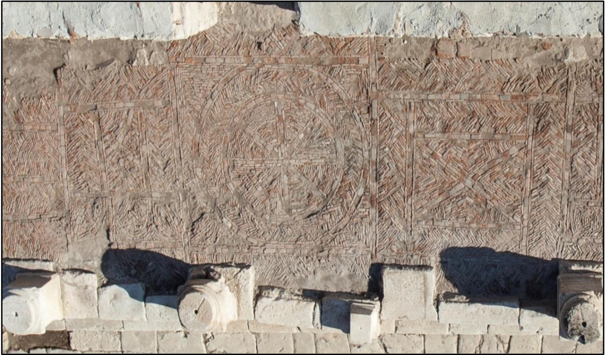
Resim 35: I. Teras Caddesi Doğu Stoa Pişmiş Toprak Zemin Döşemesi (Kibyra Kazıları Arşivi)
