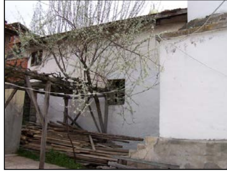
Fotoğraf 4: Dedeler Köyü Câmîi Batı Cephe Duvarı ve Giriş Kapısı.
