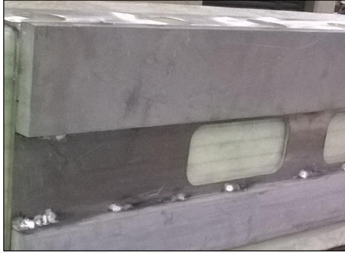
Şekil 3.55. Alüminyum destek parçalarının kaynatılması
