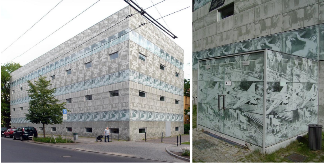
Şekil 5.23. Serigrafik baskı tekniği kullanılarak üretilen panellerden oluşan yüzey bir bütün olarak algılanmakta ve cam - beton arasındaki farklılık hissedilememektedir. Eberswalde Teknik Okul Kütüphanesi, Herzog & de Meuron, Almanya, 1993-1999 ( http://www.herzogdemeuron.com )
