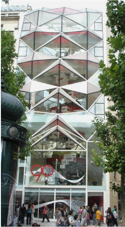
Şekil 5.31. Citroën'in logosunu oluşturacak şekilde katlama yönteminin kullanıldığı bir cephe. Citroën Showroom, M. Gautrand, Paris, 2002-2007 (kişisel arşiv)
