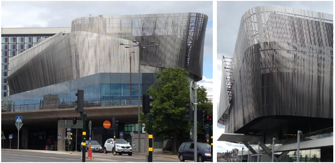
Şekil 5.33. Konturlama yöntemi ile oluşturulan yüzeyler binayı çevreleyen köprülere, yollara ve iskeleye uyum sağlayacak şekilde dalgalanmaktadır. Stockholm Waterfront Kongre Merkezi, White Arkitekter, Stockholm, 2005-2010 (kişisel arşiv)
