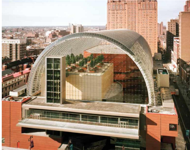
Şekil 5.28. Cam bir kase içinde iki mücevher olarak tanımlanan salon ve tiyatro mekanları 50 m. yüksekliğindeki silindirik şeklindeki kemer ile kapatılmıştır.
