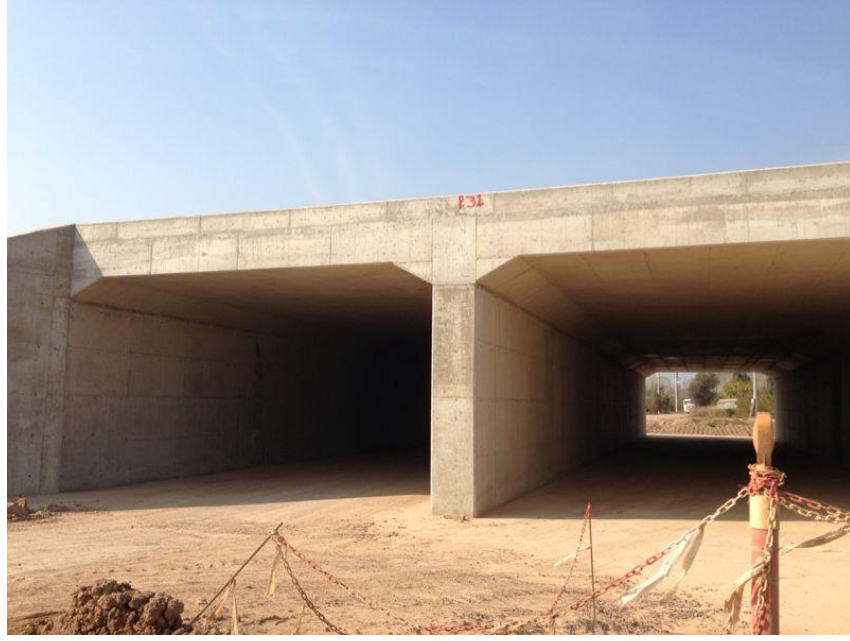
Şekil 3.6. Otoyol 4. istasyon yol yapılması sonrası görünümü
