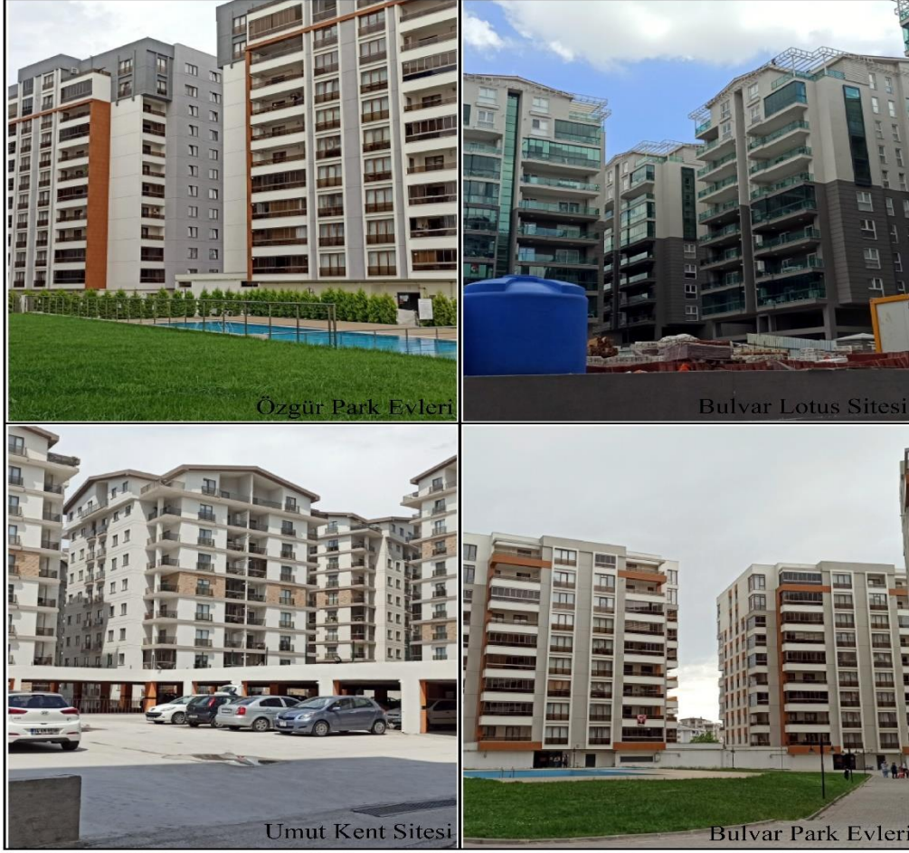
Fotoğraf 13. Çalışma Alanındaki Güvenlikli Yerleşmelere Örnekler
