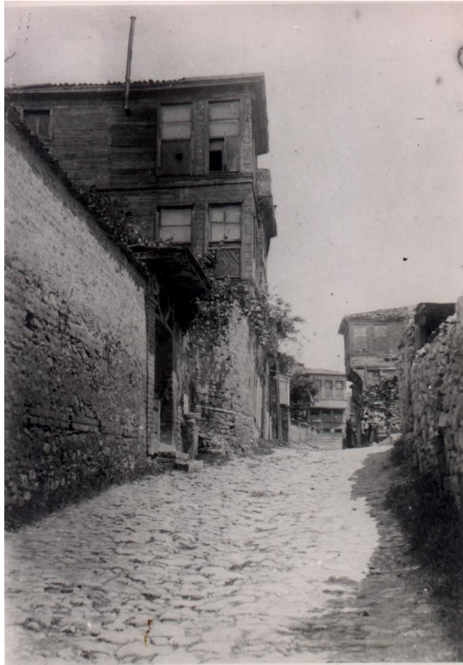
Dergâhın Konak binası.
