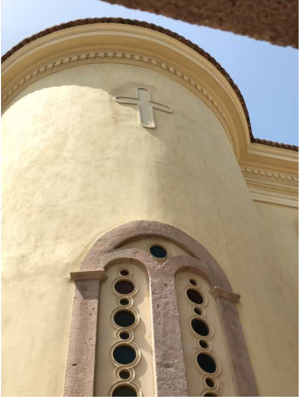
Resim 16: Taksiyarhis Kilisesi'nin apsinin ıkıntısında bulunan pencere ve üstündeki Latin haı.
