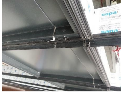
Şekil 2.2. Sızdırmazlık fitil uygulaması (Kişisel arşiv 2016).
