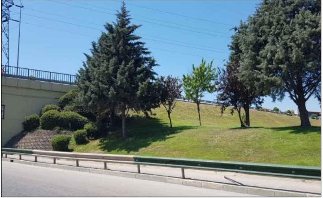
Şekil 4.31. 3. Bölge yol güzergâhında köprü girişini kapatan Cupressus arizonica kullanımı (Sevgi YILMAZ, 2019 Orijinal)
