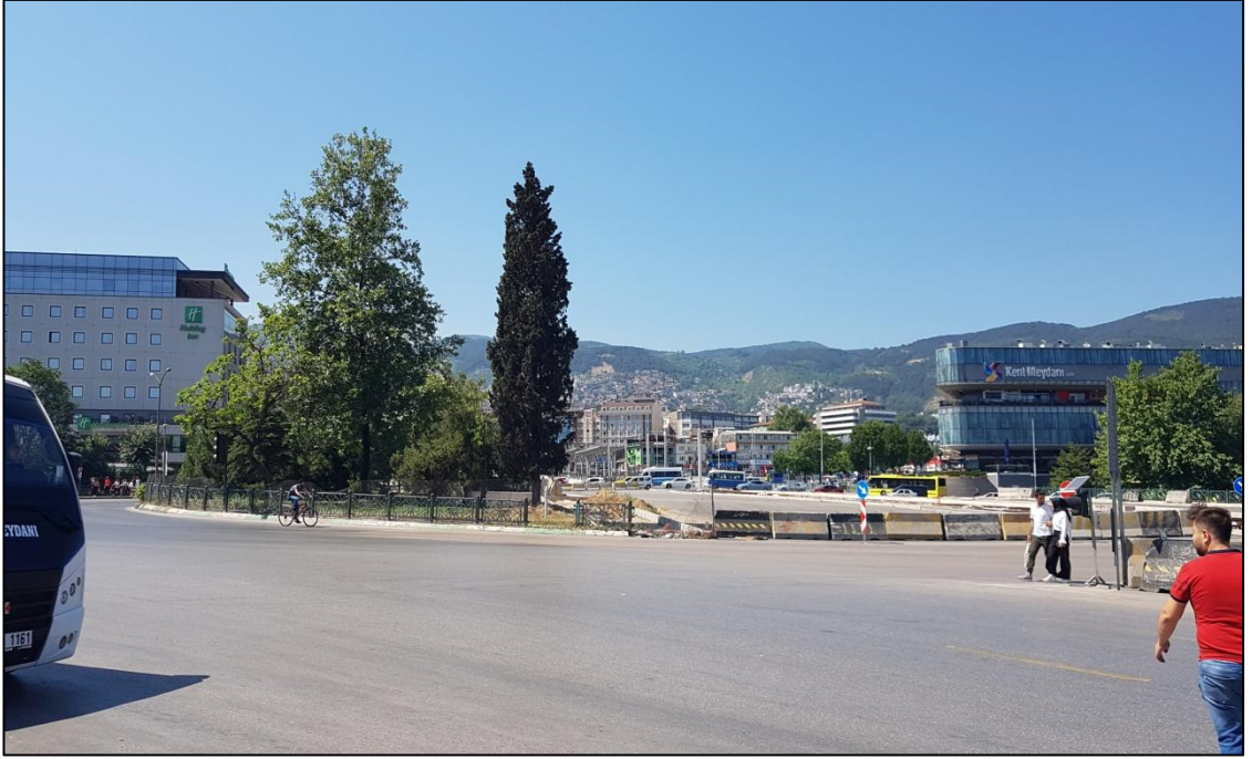
Şekil 4.45. 4. Bölge yol güzergâhındaki metro inşaatı ve bitkilerin tahribi (Sevgi YILMAZ, 2019-Orijinal)
