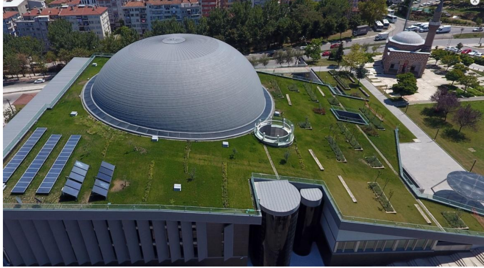
Şekil 3.21. Yeşil çatı güneş enerji panelleri görseli
