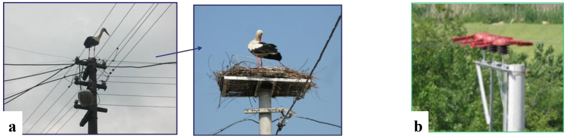
Şekil 4.16. Leylek ölümlerini önlemek amaçlı yapılan çalışmalar, (a. 12 köyde izole edilen alçak gerilim hatları, b. Direk üstüne örtülen izolatörler (Arıcı 2015))
