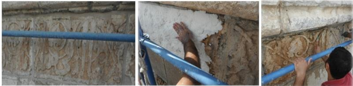
Şekil 3.122. Malabadi köprüsünde kireç taşı yazıtlarda temizlik (Sert ve ark. 2016)
