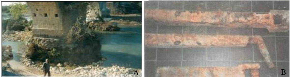
Şekil 3.11. Aspendos köprü temelindeki özgün demir kenet kullanımı a) Köprü temeli (Sert ve ark. 2009) b) Özgün demir kenetler (Kessener ve Piras 1998)
