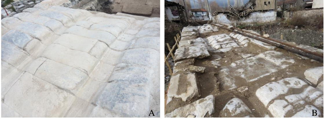
Şekil 3.146. Özgün döşemeler a) Aizonai köprüsü b) Yukarı (Koca) köprüsü
