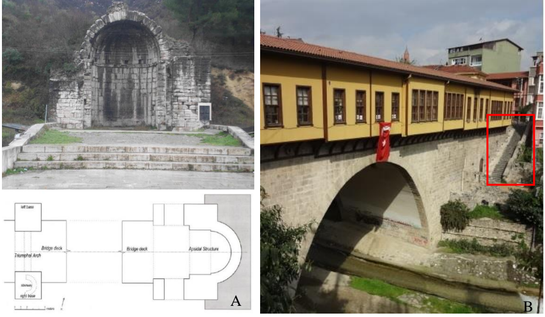
Şekil 3.99. Köprülerde merdivenli çözümler a) Sangarios Köprüsü zafer takı ve apsisli bölüme geçiş (Özcan 2015) b) Irgandı Köprüsünde hafifletme odacığına geçiş
