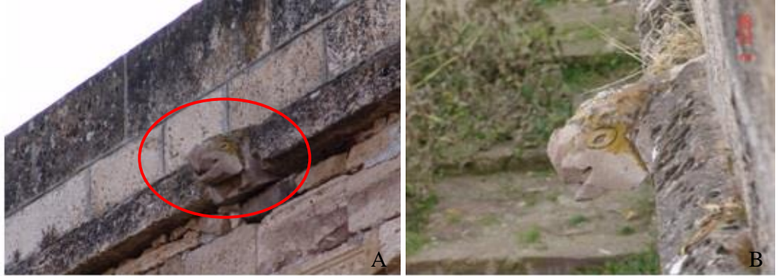
Şekil 3.96. Şahruh Köprüsü a) Köprünün memba yüzünde köprü bitimine doğru, kornişler arasında duran aslan başı olarak tarif edilen taş çörtlen b) Yandan görünüşü (Anonim 2011)
