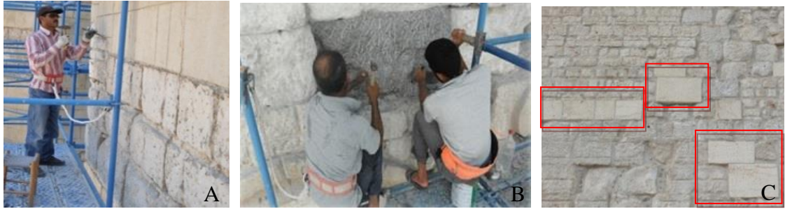
Şekil 3.121. Malabadi köprüsü a) Çimento sıvanın mekanik temizliği b) Zarar görmüş taşların iyice temizlenmesi c) Yeniden yonu taşı ile tamamlanması (Sert ve ark. 2016)
