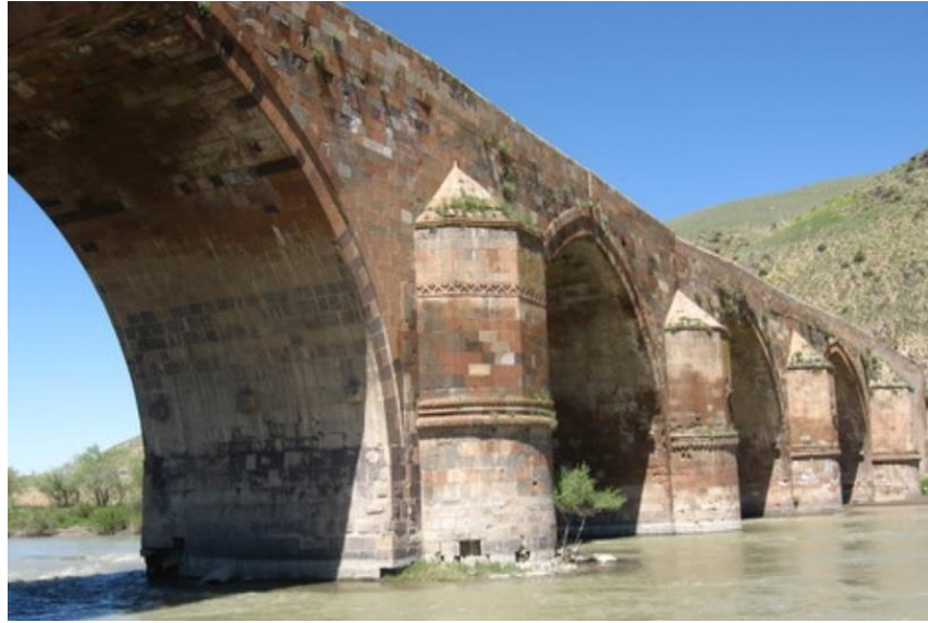
Şekil 3.105. Çobandede Köprüsü (Anonim 2007)
