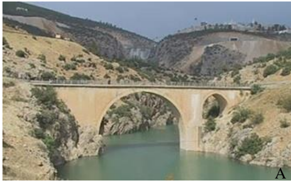
Şekil 3.36. Dairesel kemer kullanımı. a) Alaköprü (Görmeli Köprüsü), Karaman (Sert ve ark. 2009) b) Mihraplı Köprüsü, Bursa
