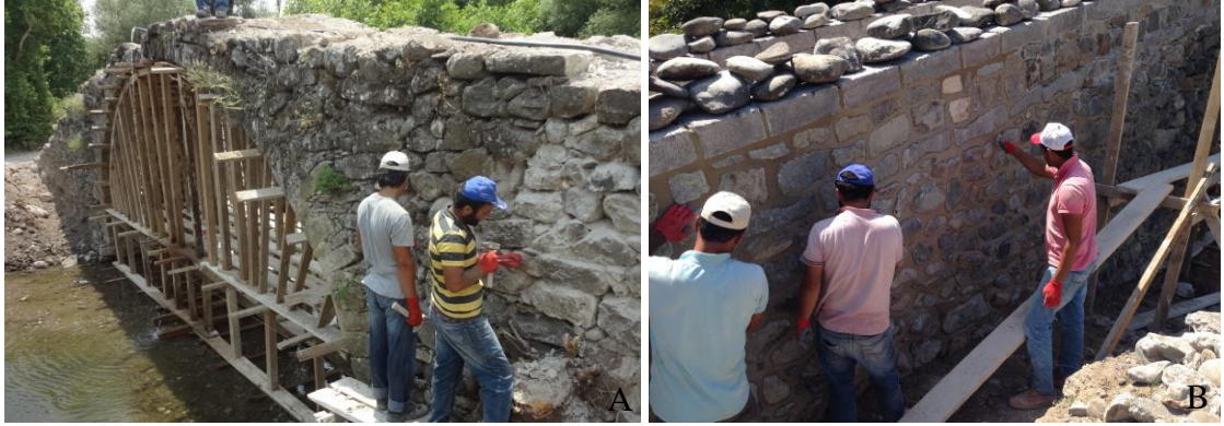
Şekil 3.119. Balıkesir İlindeki tarihi Kuşkaya Köprüsü (Osmanlı) a) Derz temizliği b) Derz yenilemesi
