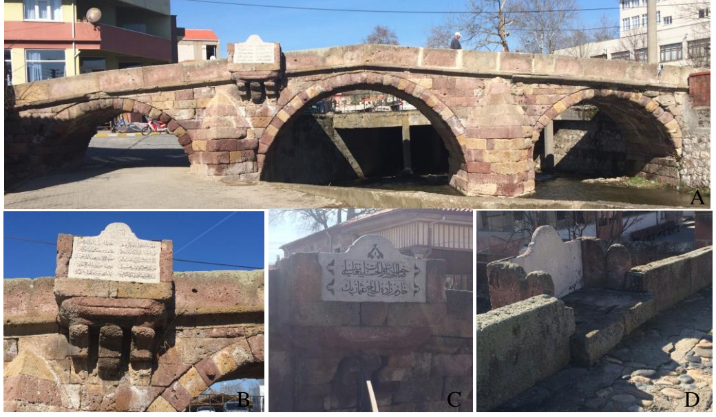
Şekil 3.68. Karşıyaka (Bayramiç) Köprüsü, Çanakkale a) Köprü görseli b) Kitabenin memba yönünden görünüşü c) Mansap yönünden görünüşü d) Döşemedden görünüşü
