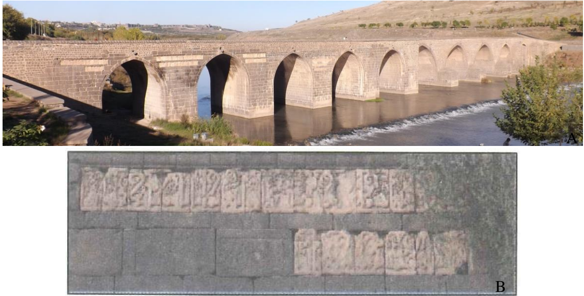
Şekil 3.67. Dicle On Gözlü Köprü a) Köprü görseli (Halifeoğlu 2018) b) Köprü'nün tempın duvarı üzerindeki sülüs türünde yazı kuşağı (Sert ve ark. 2009)
