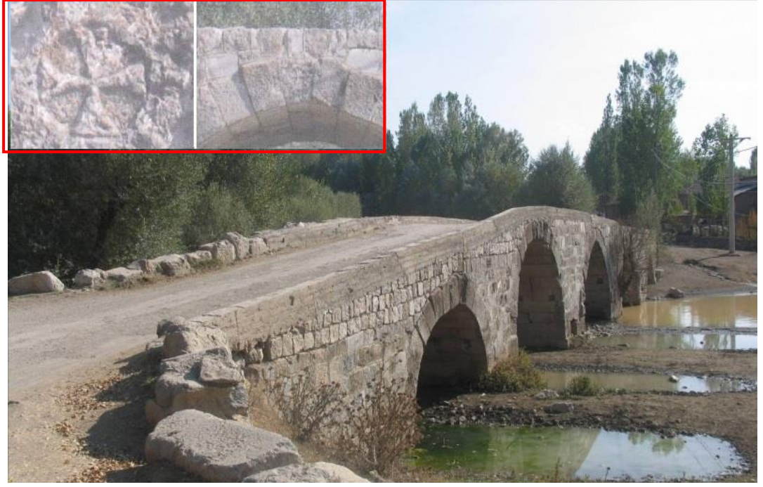
Şekil 3.100. Sulusaray Köprüsü, Tokat ( http://www.aproje.com.tr/?page=restorasyon_ projeleri&projeID=138# , 2018 / Sert ve ark. 2009)
