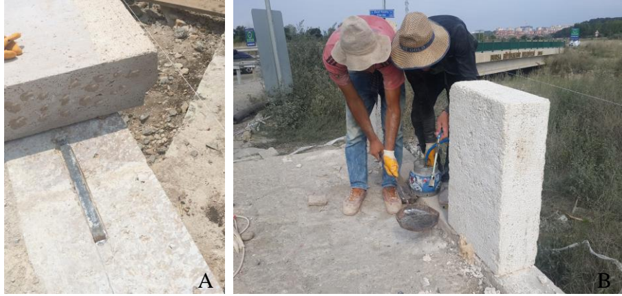
Şekil 3.128. Tarihi Nilüfer Hatun Köprüsü a) Korniş ve korkuluklarda kenet ve zıvana uygulaması b) Üzerlerine kurşun dökülmesi
