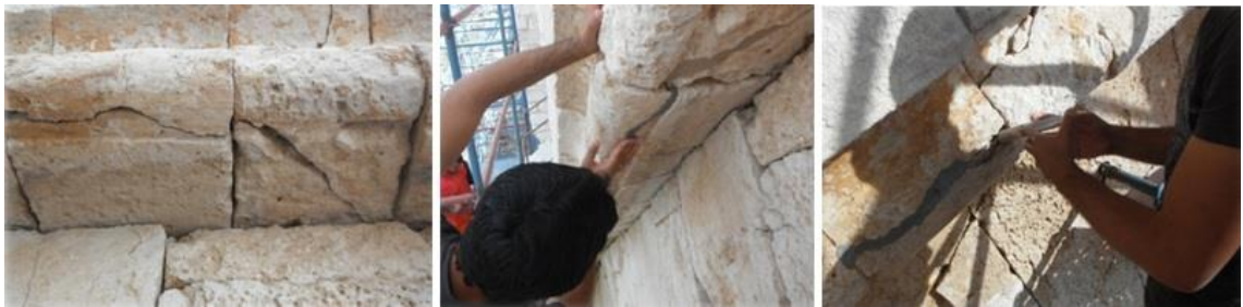
Şekil 3.124. Malabadi köprüsündeki mikroenjeksiyon uygulaması (Sert ve ark. 2016)
