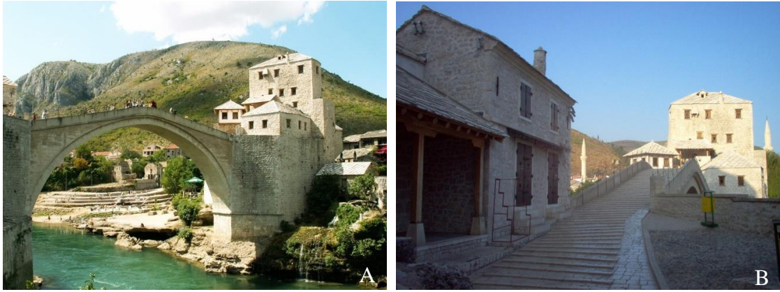
Şekil 3.57. Mostar Köprüsü (1557-1566), Bosna Hersek a) Köprü görseli b) Köprü'nün döşeme detayı ( https:// www.atlasobscura.com/places/stari-most , 2019)
