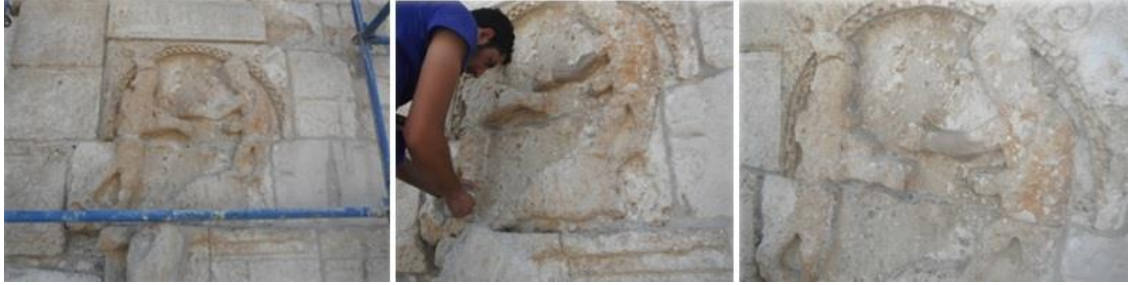
Şekil 3.127. Malabadi köprüsündeki heykel konservasyonu (Sert ve ark. 2016)
