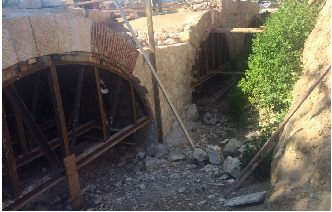
Şekil 3.42. Tarihi Nilüfer Hatun Köprüsü taşıyıcı iskeleler
