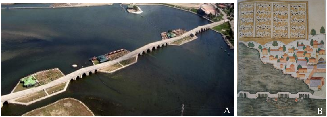
Şekil 3.16. Büyükçekmece (Mimar Sinan) Köprüsü (16. yy.), İstanbul a) Köprü görseli ( http://www.bcekmece.bel.tr/tr-tr/Buyukcekmece/Ilcemizde-Yasam/TarihiYerler/Sayfalar/Buyukcekmece-Koprusu.aspx , 2018) b) Nakkaş Osman'ın Büyük Çekmece Köprüsü tasviri (Develi 2002)
