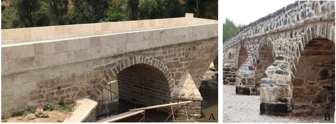
Şekil 3.63. Osmanlı Dönemi korniş ve korkuluk örnekleri a) Nilüfer Hatun Köprüsü, Bursa b) Dokuzgöz Köprüsü, Kütahya
