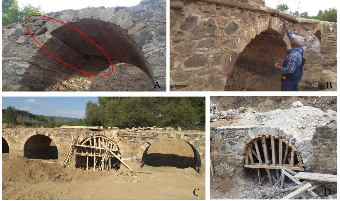
Şekil 3.136. Tarihi Dokuzgöz Köprüsü a) Zarar görmüş kemer b) Taşların numaralandırılması c) Taşıyıcı iskele kurulması ve taşların sökülmesi d) Kemerin yeniden yapılması
