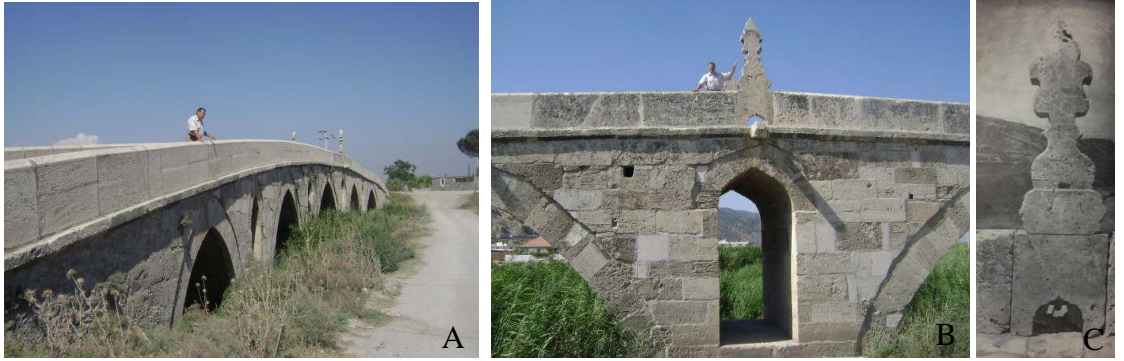
Şekil 3.95. Sazlı Ramazan Paşa Köprüsü, Aydın a) Köprü görseli b) Cepheden çörtenin görünüşü ( http://www.sto.org.tr/S%C3%96KE/Tarih%C3%A7e/tabid/13282/Default.aspx , 2018) c) Çörten görseli (Tunç 1978)
