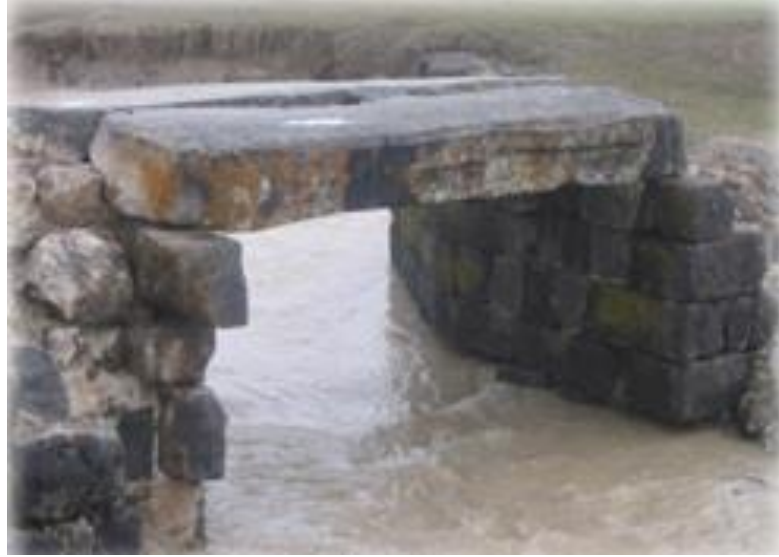
Şekil 3.46. Kız Köprüsü, Malazgirt/Muş (Apaydın 2018)
