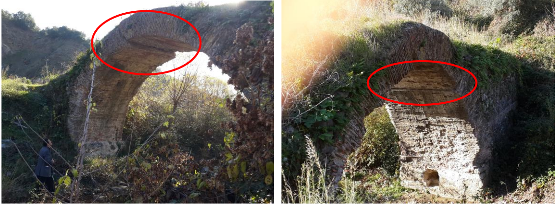
Şekil 3.137. Büyükkuşla Köprüsünde iki ayrı kırılmanın gerçekleşmiş olduğu kemer
