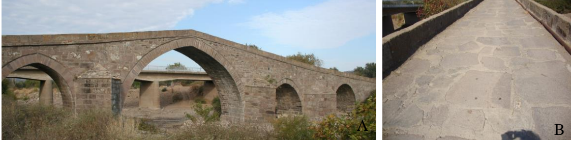
Şekil 3.56. Tarihi Behramkale Köprüsü, Çanakkale a) Köprü görseli b) Köprü'nün özgün döşemesi
