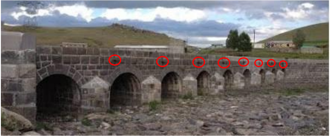
Şekil 3.97. Nebi Çayı (Hanı) Köprüsü çörtlenleri, Erzurum ( http://iq.geoview.info/nebi_cay%C4%B1_koepruesue,92239478p , 2018)
