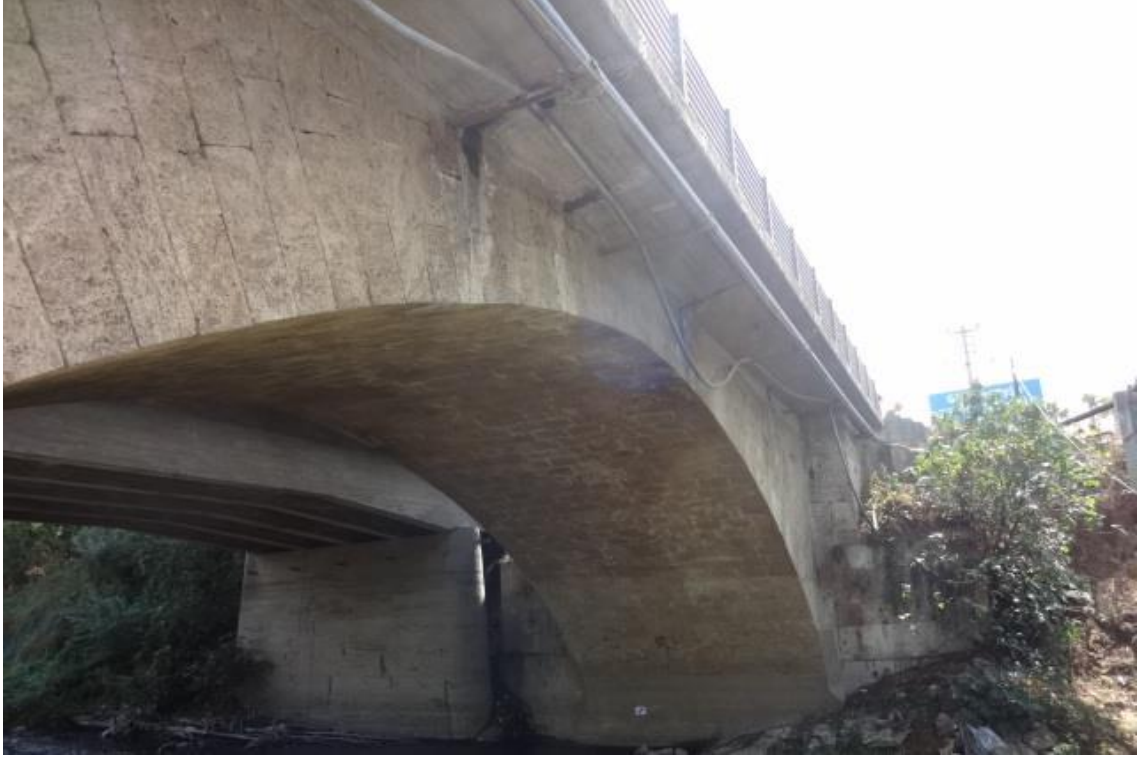
Şekil 3.108. Tarihi Geçit Köprüsünün betonarme eklentilerle tabliyesi genişletilmiş, üzeri asfaltlanmış; ayrıca çeşitli hatlar monte edilmiş ve yakınına bir betonarme köprü yapılmıştır (Meriç C. 2016)
