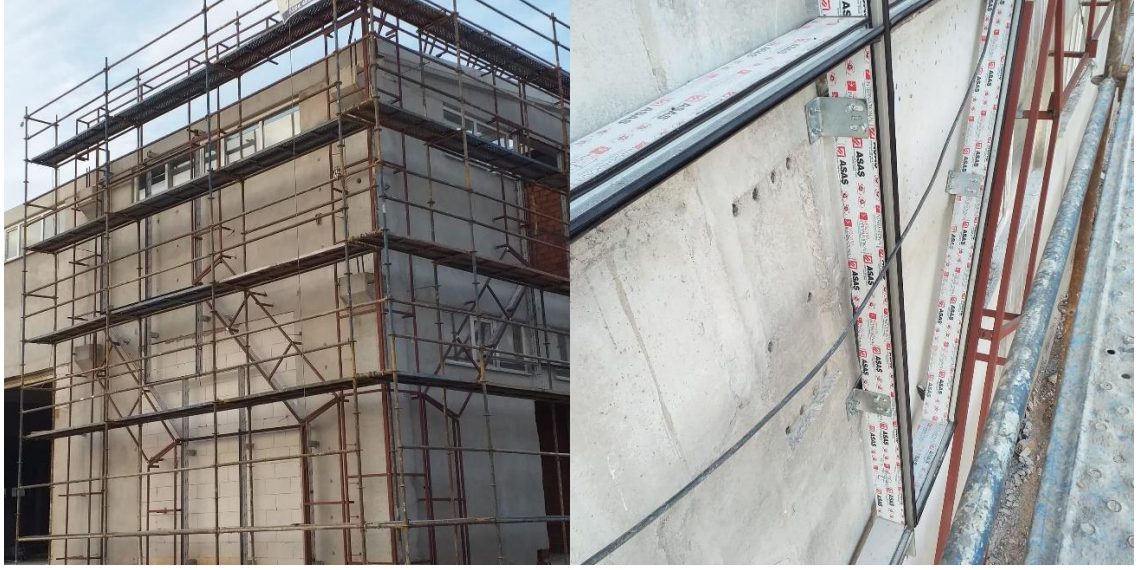
Şekil 2.13. Hafif asma sistem montaj örneği (Anonim2019)
