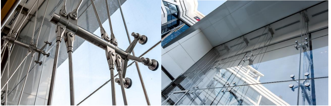
Şekil 2.41. Kablo taşıyıcılı örnekler (Anonim 2019p)
