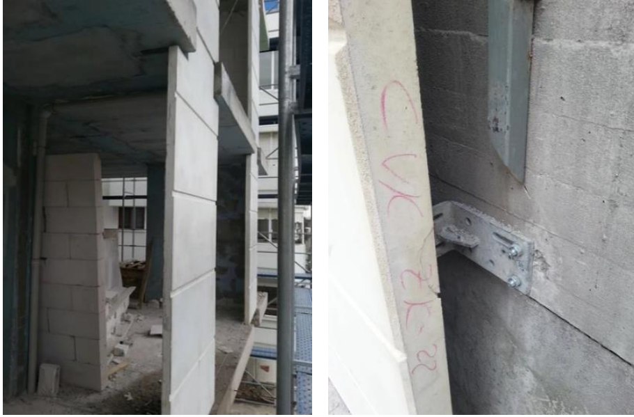
Şekil 2.12. Prekast beton uygulaması (Anonim 2019g)
