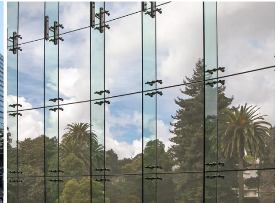
Şekil 2.44. Taşıyıcı cam destekli transparan cephe örneği (Anonim 2019za)
