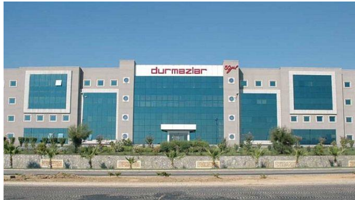
Şekil 2.24. Çubuk sistem uygulama örneği Durmazlar Holding -Bursa
