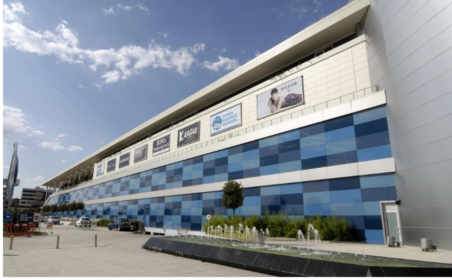
Şekil 2.32. Mastik taşıyıcılı sistem örneği Korupark Avm- Bursa (Anonim 2019r)
