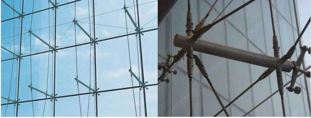
Şekil 2.40. Kablo taşıyıcılı sistem örneği (Anonim 2019u)
