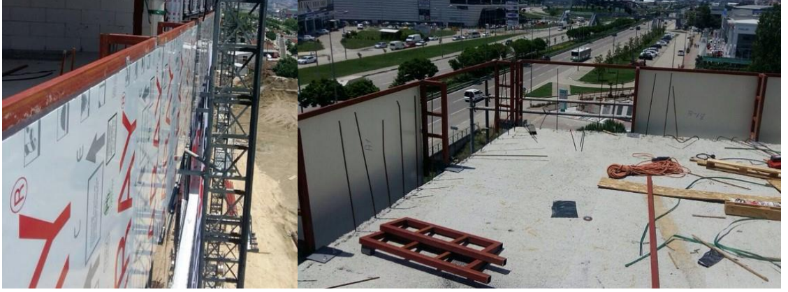
Şekil 2.73. Alüminyum kompozit panel montaj örneği (Anonim 2017).
