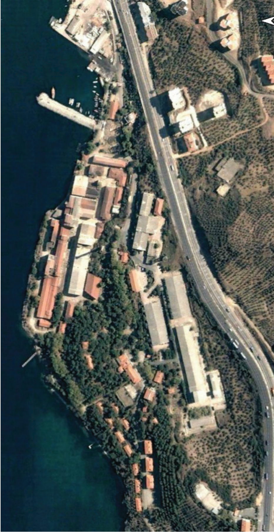
Şekil 2.34. Gemiilik Sungiipek Fabrikası hava fotoğrafı, 01 Ekim 2004 (Anonim 2018e)
