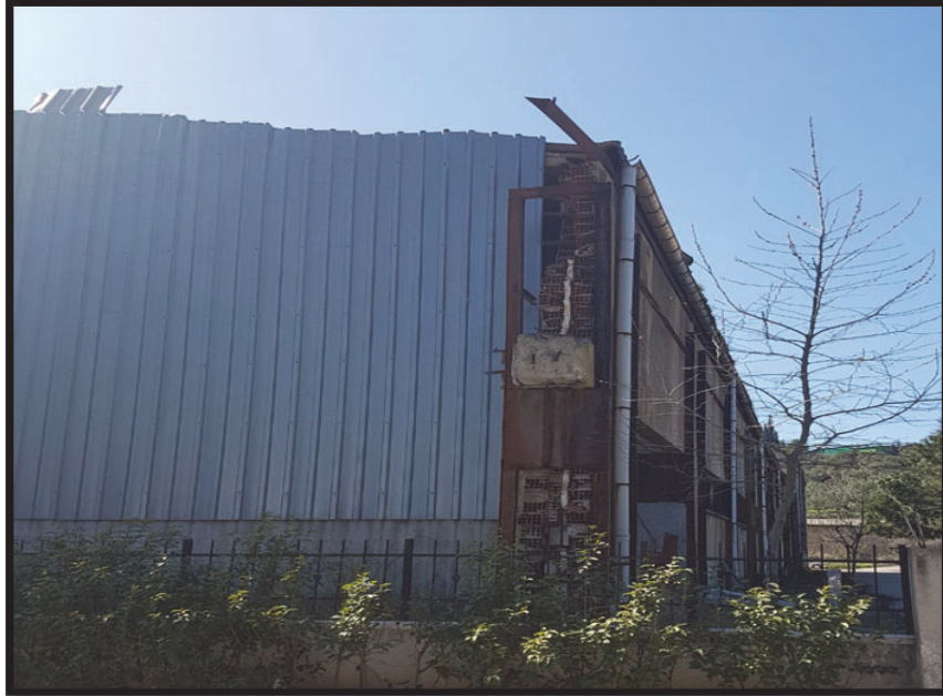
Şekil 3.16. Laklama-Konfeksiyon Binası doğu cephesi
