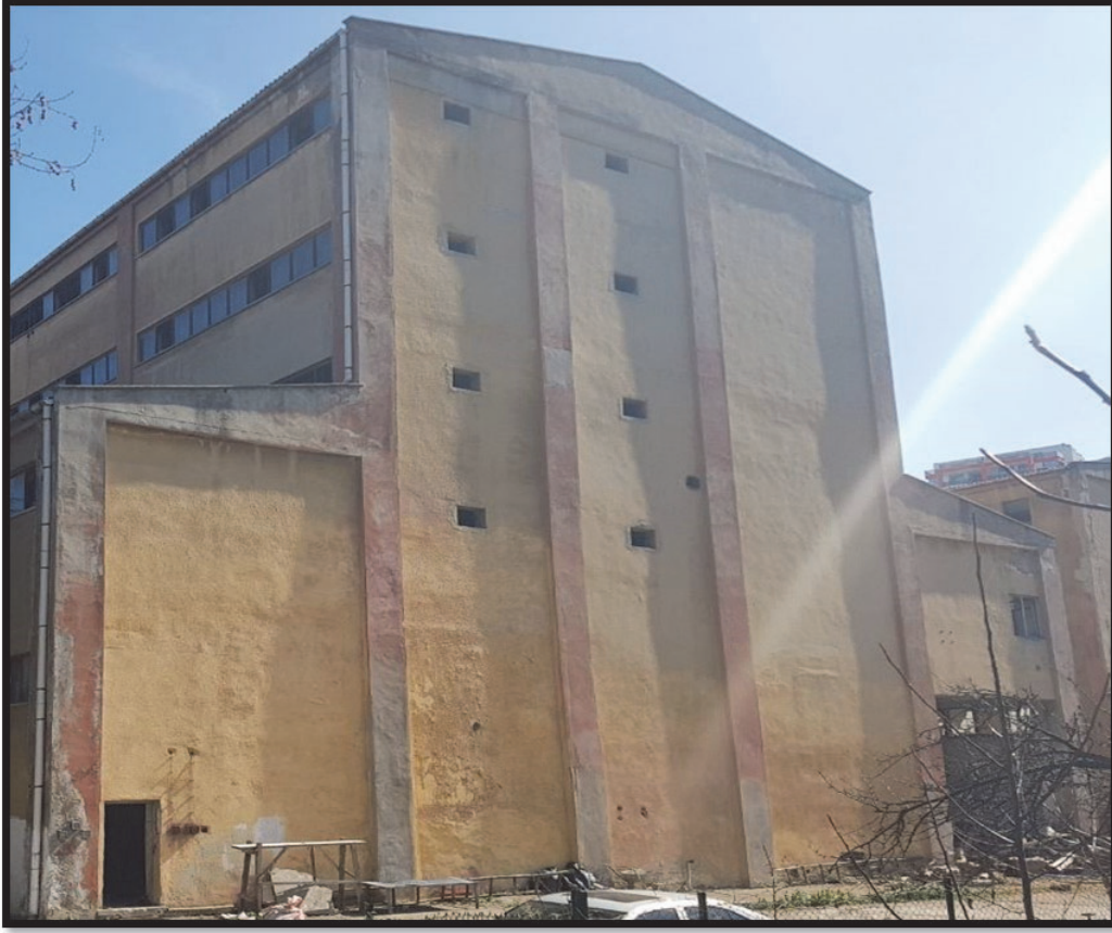
Şekil 3.12. Laklama-Konfeksiyon Binası batı cephesi
