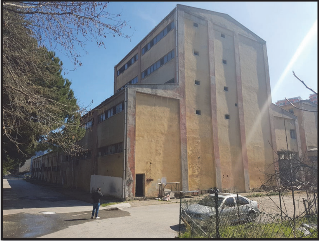
Şekil 3.10. Laklama-Konfeksiyon Binası kuzey cephesi
