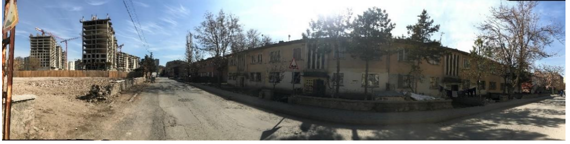
Şekil 4.19. Yapımı devam eden 1. Etap ve Bölgenin İlk Konut Yapılarından olan Belediye Lojmanları'nın bir kısmı
