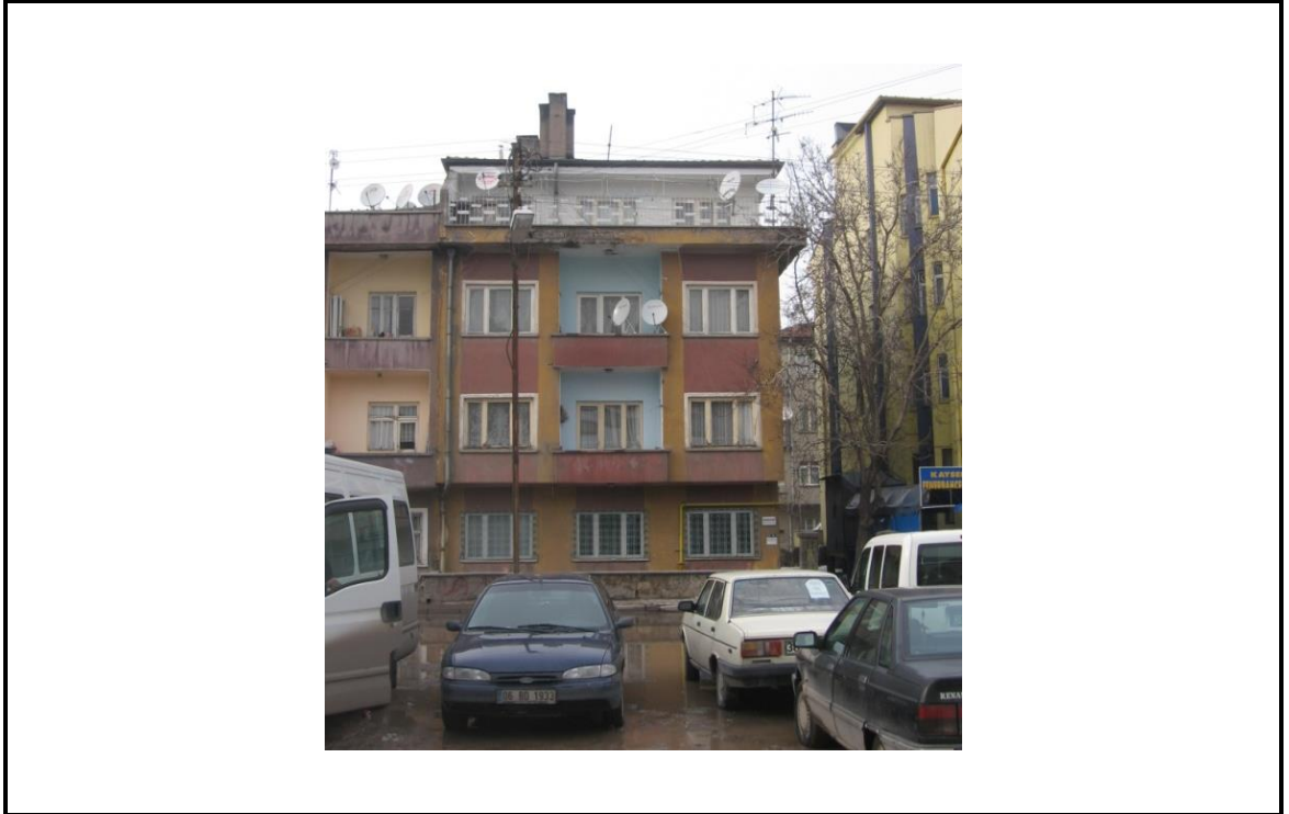
Çizelge 4.161. Nalbantoğlu Apartmanı
