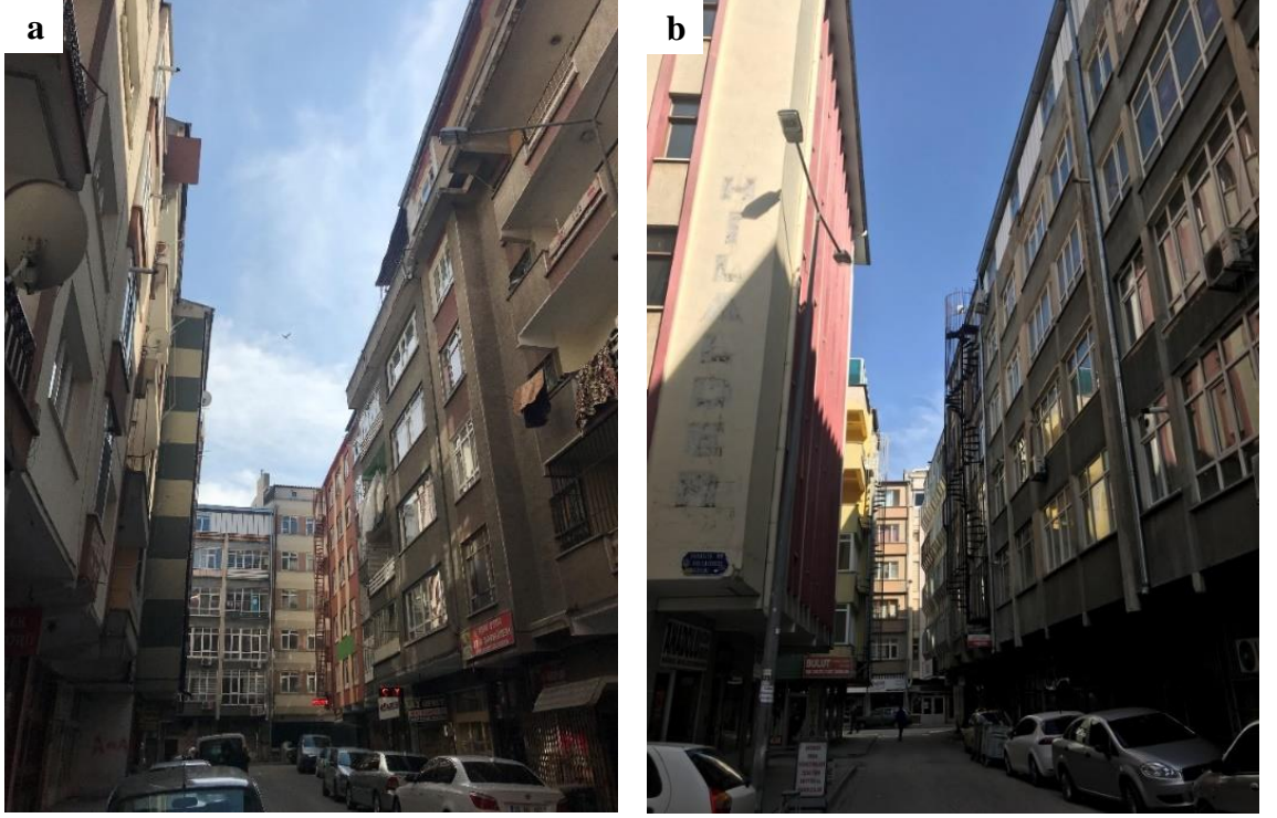
Şekil 4.12. Değişen kat yükseklikleri ve yapı yaklaşım mesafeleri a) Helvacıdede Geçidi Sokak b) Safran Sokak
