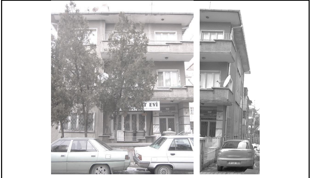
Çizelge 4.23. Özkalan Apartmanı
