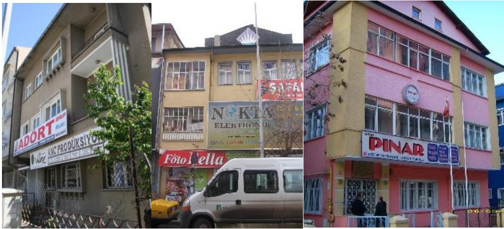
Şekil 4.14. Müdahalelerle cephe karakteri zarar gören yapılar
