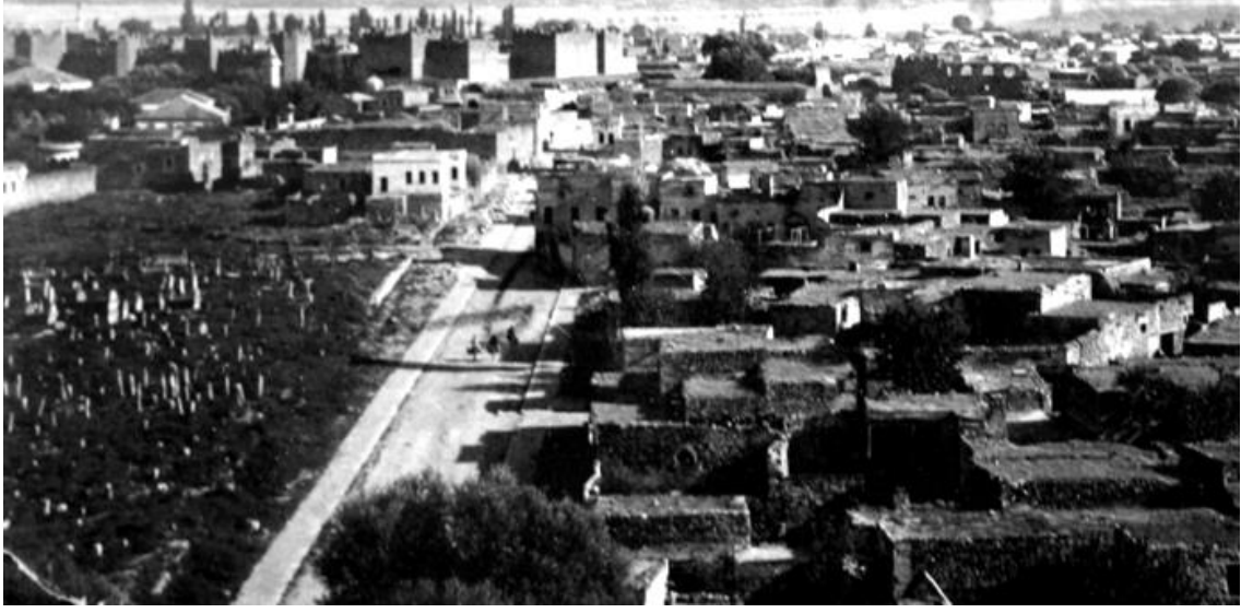
Şekil 3.7. İstasyon Caddesi (1930 başları) yapım aşamasında -Sol taraftaki (mezarlık) alan düzenlenerek üzerine Vali Konutu, Halkevi, Kız Enstitüsü inşa edilmiştir (Asiliskender 2008)
