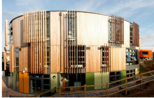
Şekil 2.12. Rednock School, güneş ışığı kontrolü sağlayan panjur sistemi ( https://www.levolux.com/tag/rednock-school/ , 2019)
