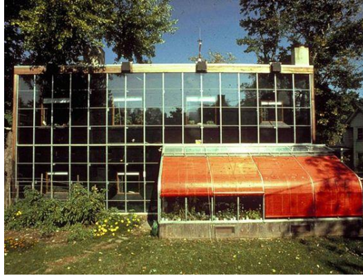
Şekil 2.3. Kelbaugh Solar House: Pasif enerji uygulamasına sahip konut tasarımı ( https://tr.pinterest.com/pin/138978338470873415/?lp=true , 2019)
