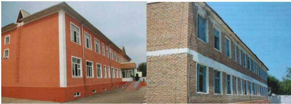
Şekil 3.28. 2 No.lu Ortaokul'un restorasyon öncesi ve sonrası, Fergana (Anonim 2012)
