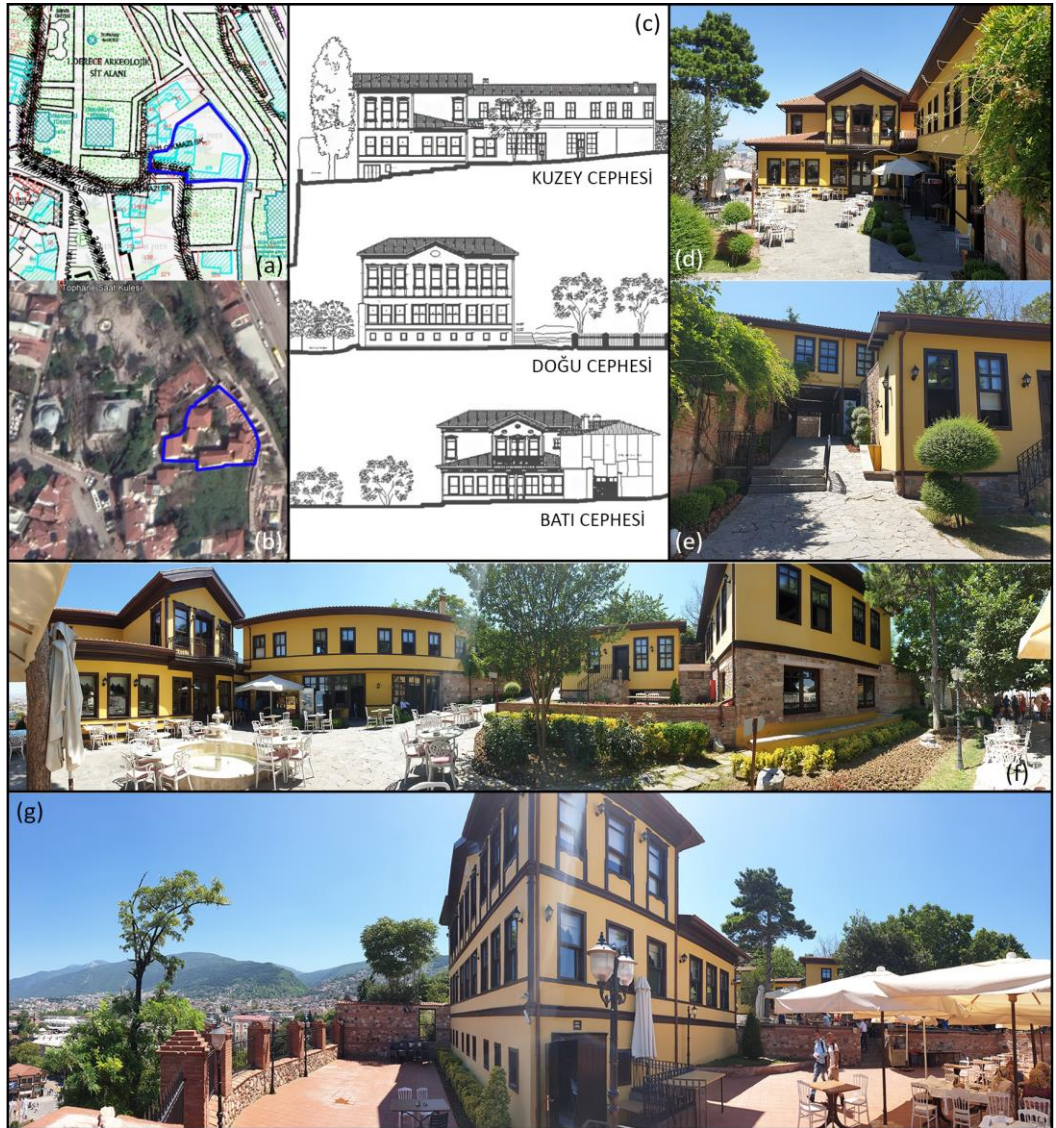
Şekil 4.47. 4268 ada 167 parsel no’lu konutun (a) halihazır haritası (BBB), (b) hava fotoğrafı (Googleearth 2019), (c) cephe çizimleri (Kapar 2008), (d) batı cephesi, (e) bahçeye giriş, (f) bahçenin kuzeyinden, (g) bahçenin doğusundan 2019 fotoğrafları
