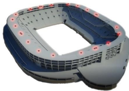
Şekil 3. 54. Sismik izalatörler (Sözüneri 2009)
