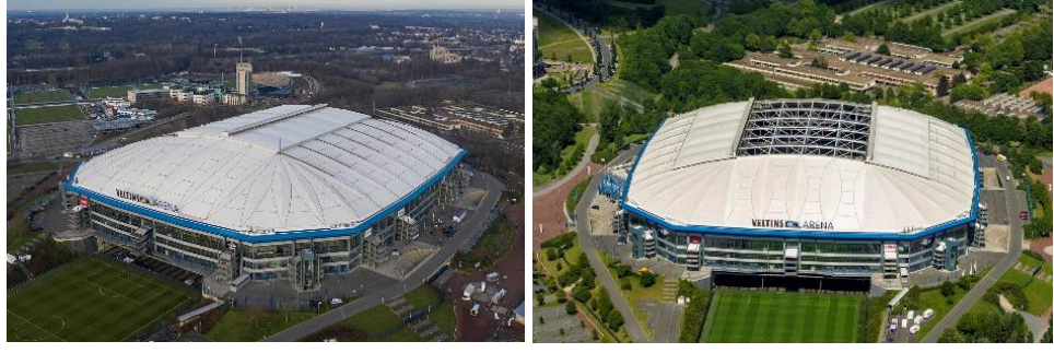
Şekil 2. 64. Açılıp kapanabilen çatı sistemi Veltins Arena Stadyumu, Almanya (Anonim 2019g, Anonim 2019h)
