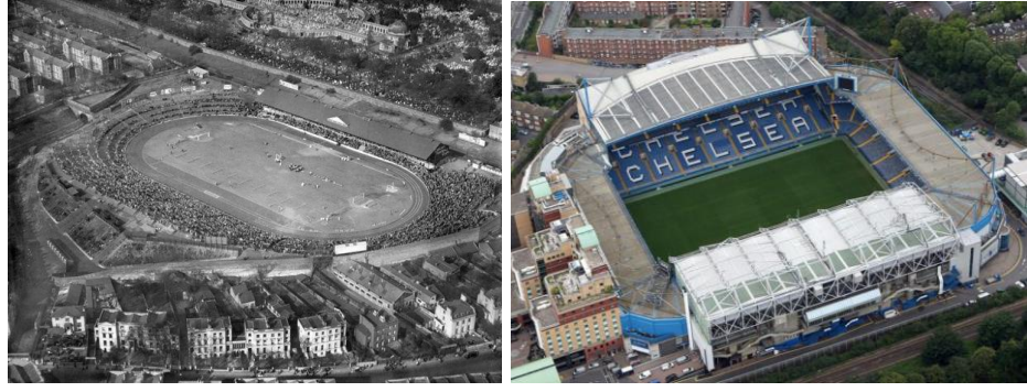
Şekil 2. 79. Stamford Bridge Stadyumu 1929 ve günümüz (Anonim 1929, Anonim 2018)
