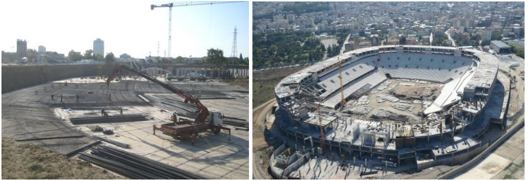
Şekil 3. 16. İnşaat sürecinden görüntüler (Anonim 2017m)
