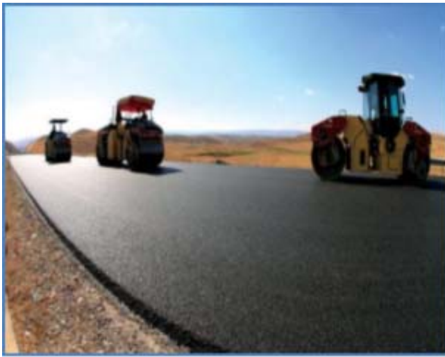
Şekil 2.11. Bitüm ile stabilizasyon (Yorulmaz 2018)
