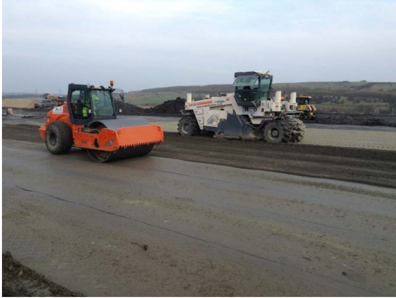
Şekil 2.12. Çimento ile zemin stabilizasyonu
