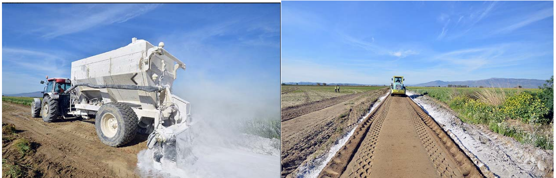
Şekil 2.8. Kirec stabilizasyonun yol yapımında uygulanması
