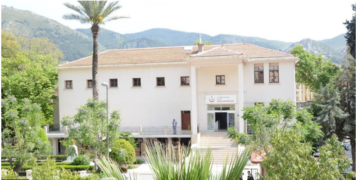
Şekil 2.26. 2019 İl sağlık müdürlüğüne dönüştürülen eski Hatay Halkevi binası (Anonim 2020c)
