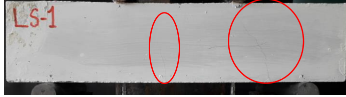
Şekil 4.2. LS-1 kirişinde oluşan ilk çatlaklar
