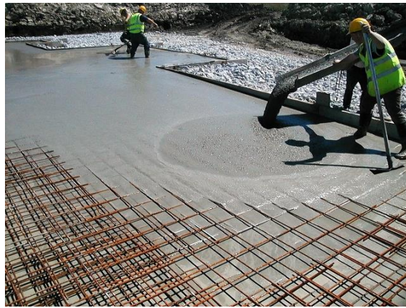
Şekil 2.1. Kendiliğinden yerleşen beton uygulaması
