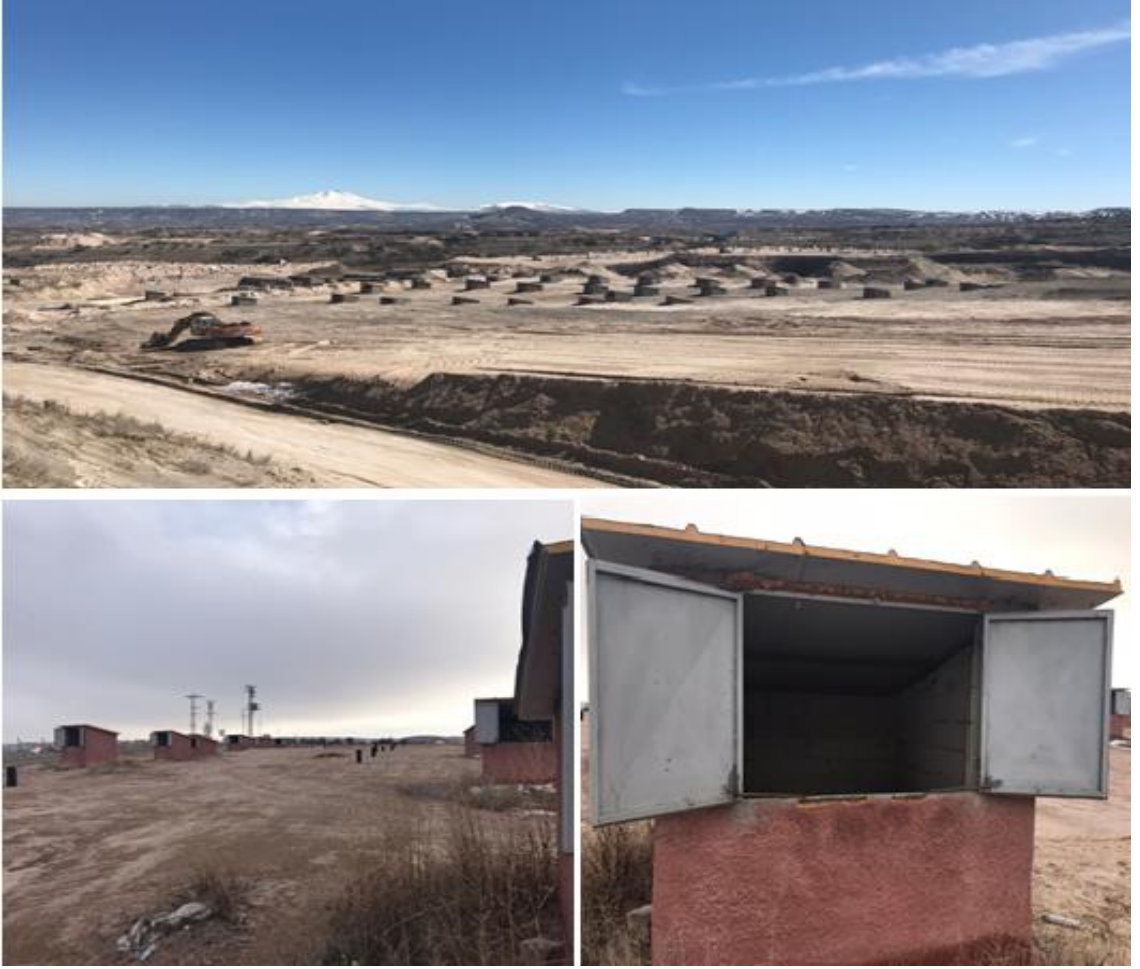
Şekil 1.7. Doğal soğutmalı yer altı depo bacalarından bir görünüm (Zeynep Tarımcı'nın arşivinden alınmıştır).
