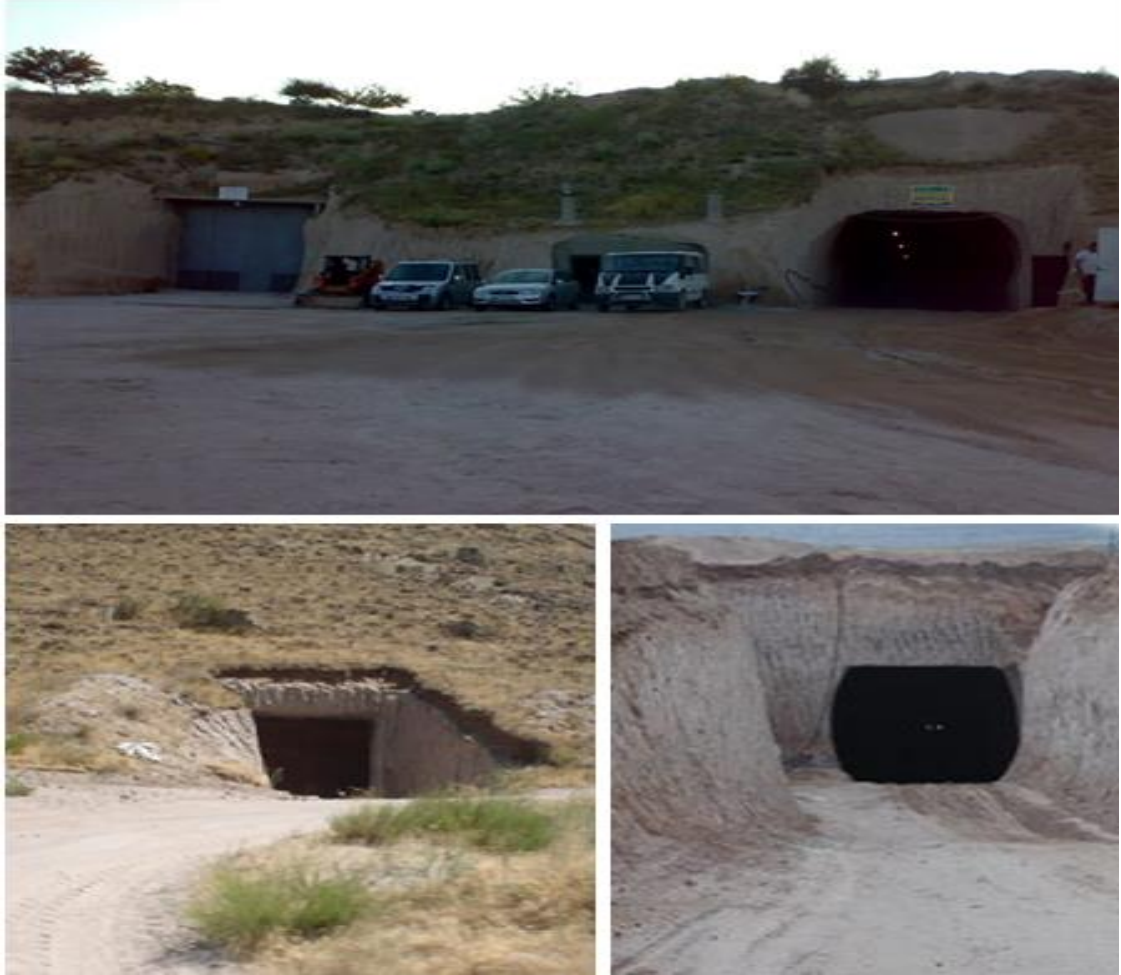
Şekil 1.5. Dış hava ile soğutulan basit (adi) depolar depo sistemlerinden bir görünüm (Cihat Türkben'in arşivinden alınmıştır).
