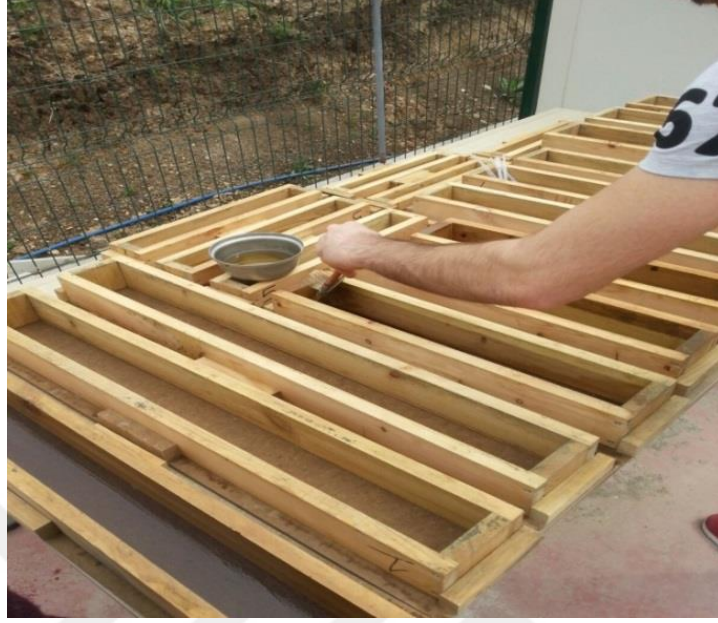
EK Şekil 3.1. kiriş numuneler için kalıpların hazırlanması.
