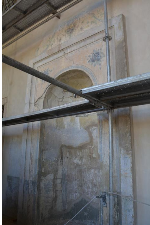
Fotoğraf 48: Sultan Murad Camii son cemaat yeri doęu kanadı mihrabiyesi (Restorasyon süreci devam ederken. Ekim 2018)
