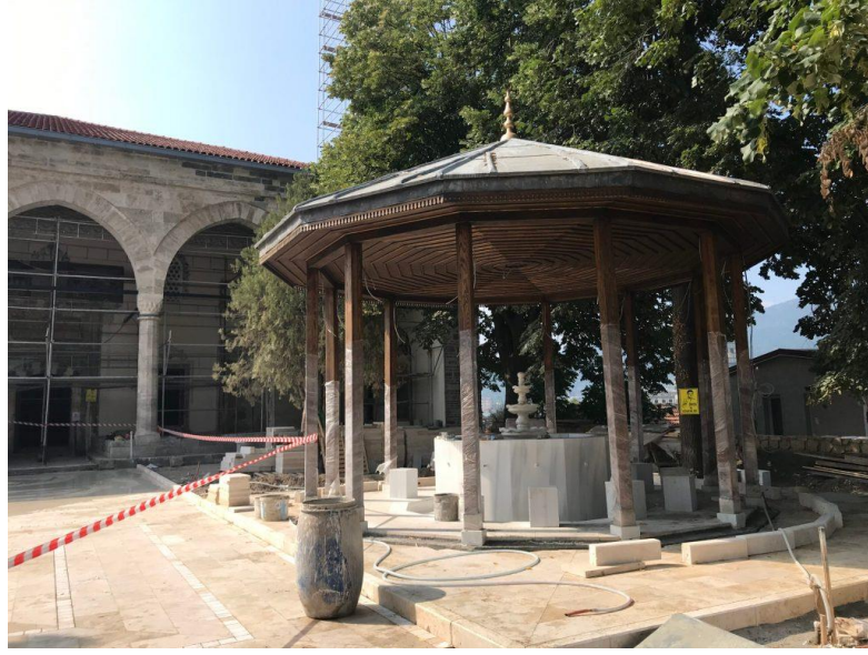
Fotoğraf 109: Sultan Murad Camii şadırvanı (restorasyon sonrası 2019)
