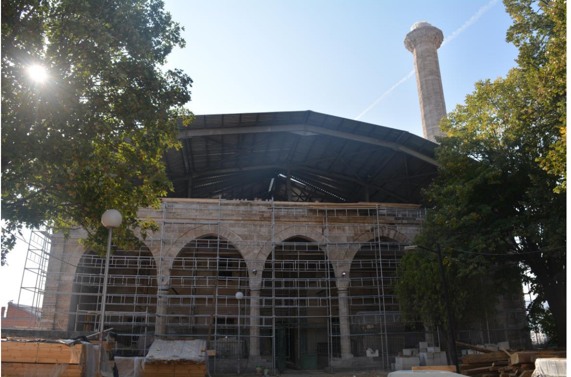
Fotoğraf 4: Sultan Murad Camii kuzey cephesi (Restorasyon süreci devam ederken. Ekim 2018)
