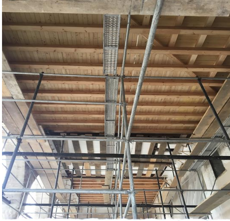
Fotoğraf 61: Sultan Murad Camii son cemaat yeri ahşap kırma çatısı yenilenirken (Restorasyon süreci Ekim 2018)
