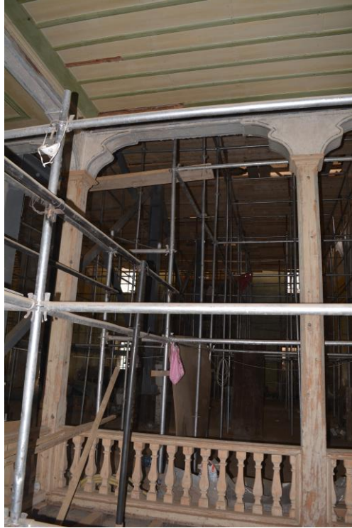
Fotoğraf 84: Sultan Murad Camii kadınlar mahfilini taşıyan ahşap ayaklar
