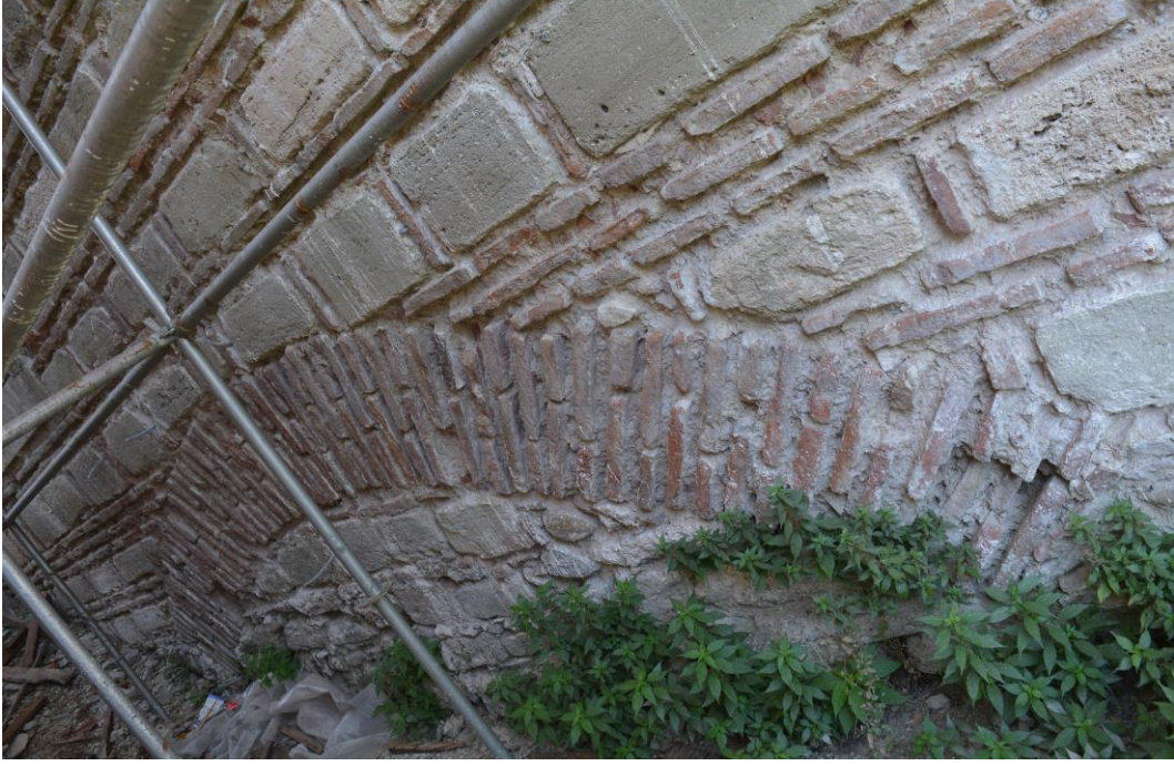
Fotoğraf 11: Sultan Murad Camii güney cephesi kemer
