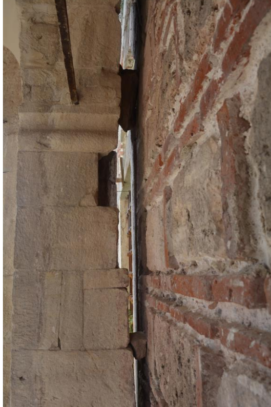
Fotoğraf 146: Türbe ile cami duvarı arasındaki mesafe
