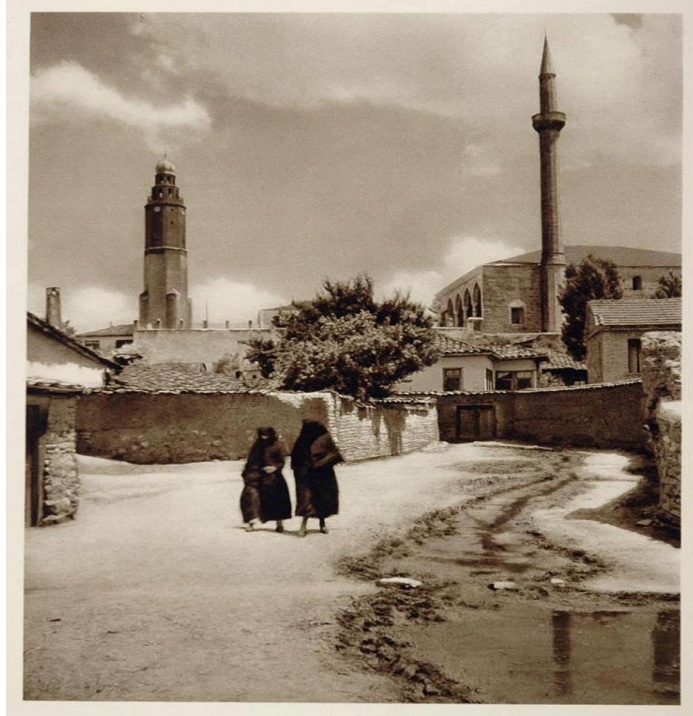
Fotoğraf 56: Sultan Murad Camii'nin 1912 - 1913 yıllarındaki görünümü. (Üsküp Hatırası s. 131)
