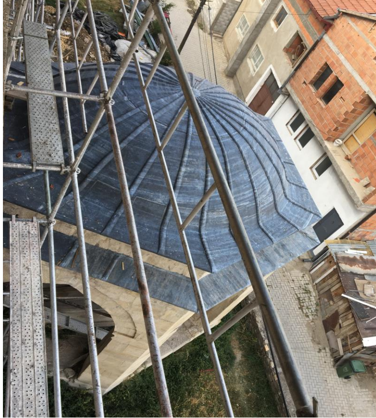
Fotoğraf 152: Dağıstanlı Ali Paşa Türbesi örtü sistemi
