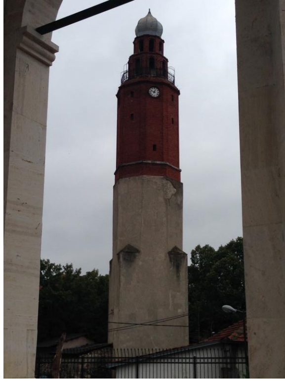
Fotoğraf 176: Saat Kulesi'nin restorasyondan önceki görünümü
