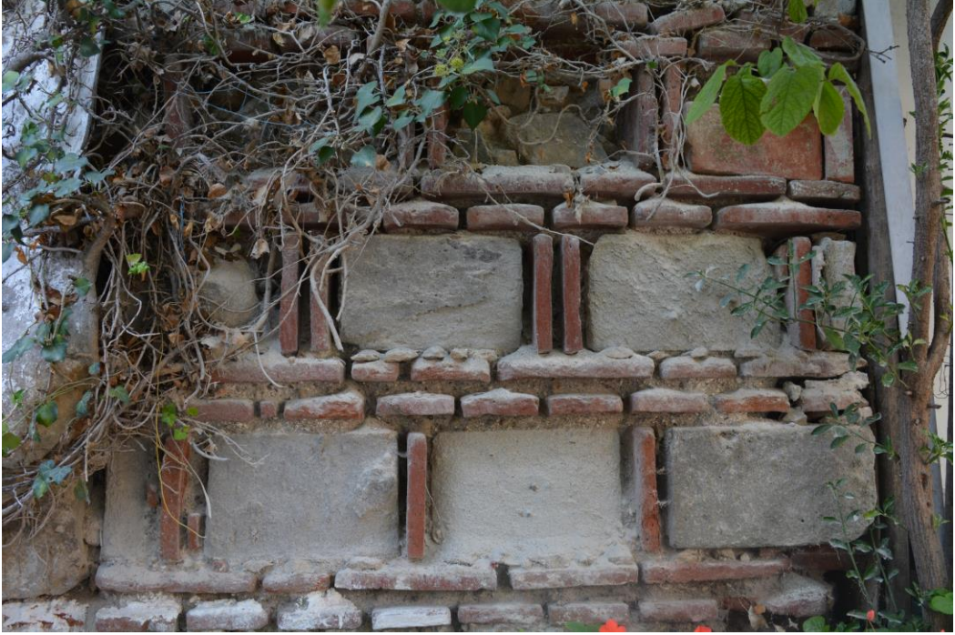
Fotoğraf 190: Sultan Murad Camii Medresesi duvar detay
