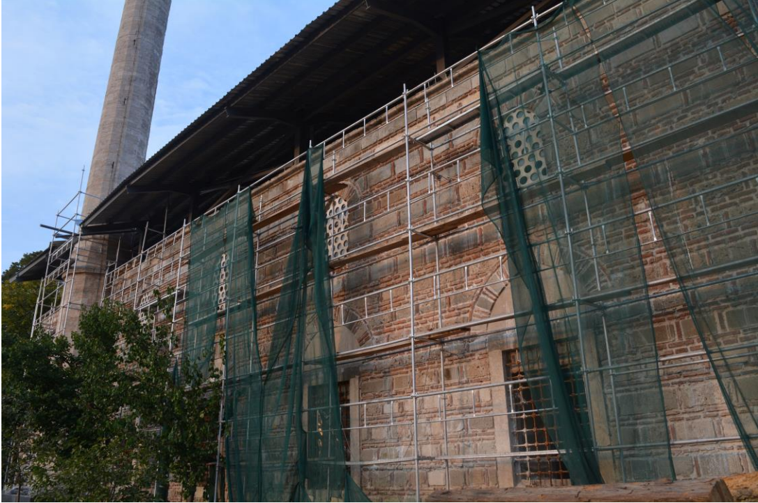
Fotoğraf 12: Sultan Murad Camii batı cephesi (Restorasyon süreci devam ederken. Ekim 2018)
