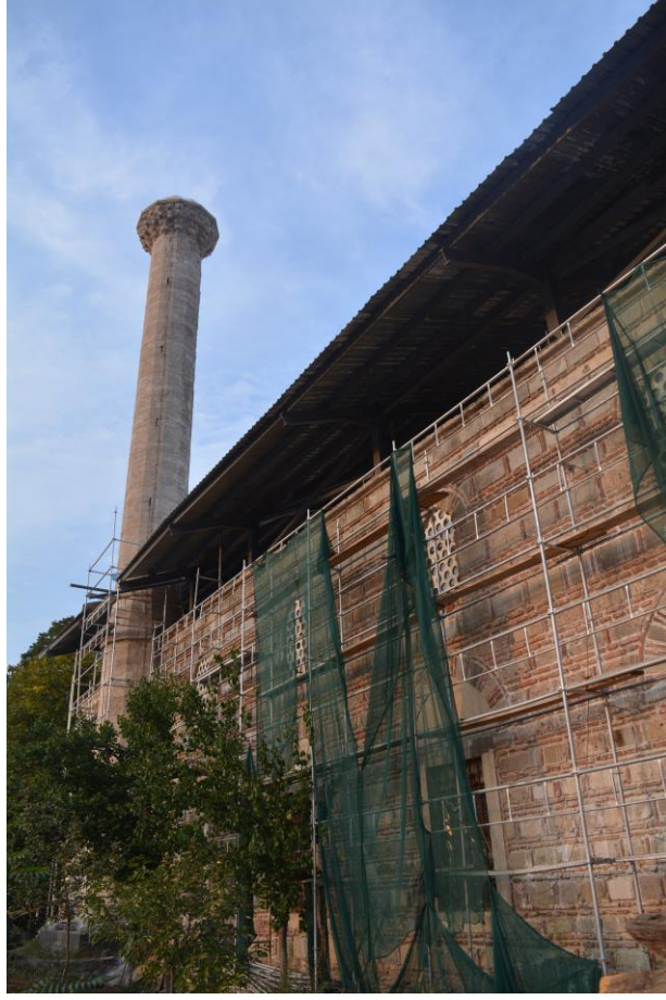
Fotoğraf 13: Sultan Murad Camii batı cephesi (Restorasyon süreci devam ederken. Ekim 2018)
