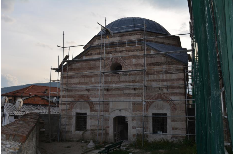
Fotoğraf 111: Beyhan Sultan Türbesi umumi görünüşü
