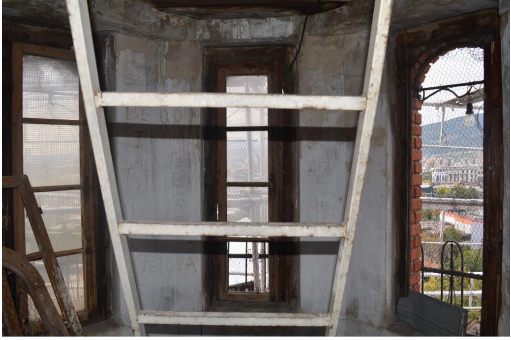
Fotoğraf 184: Saat Kulesi balkon bölümü
