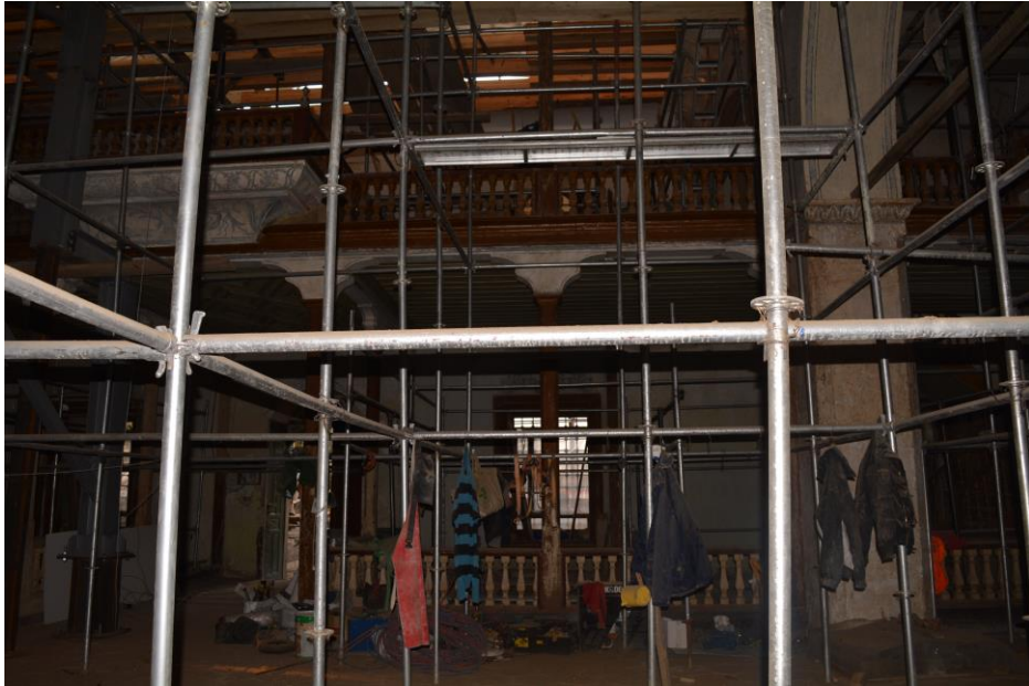
Fotoğraf 80: Sultan Murad Camii kadınlar mahfili (Restorasyon süreci 2018)
