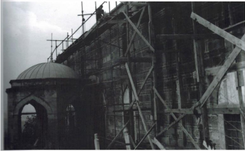
Fotoğraf 200: Sultan Murad Camii dođu cephесinin 1963 yılındaki deprem sonrası onarımı (Üsküp Milli Konservasyon Arşivi)
