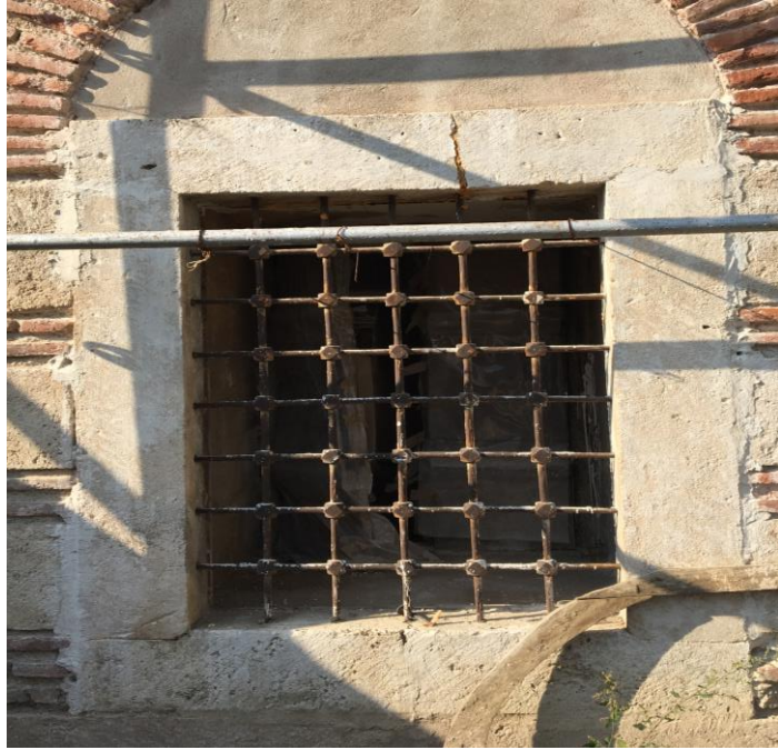
Fotoğraf 120: Beyhan Sultan Türbesi pencerelerindeki lokmalı demir parmaklıklar
