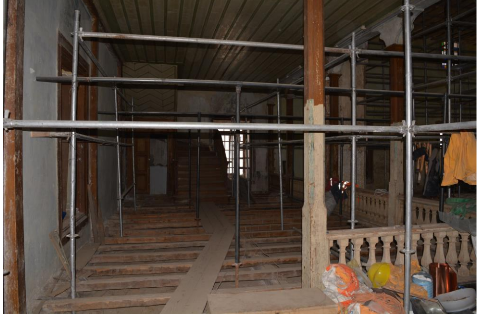
Fotoğraf 83: Sultan Murad Camii kadınlar mahfilini ahşap kontrüksiyonu
