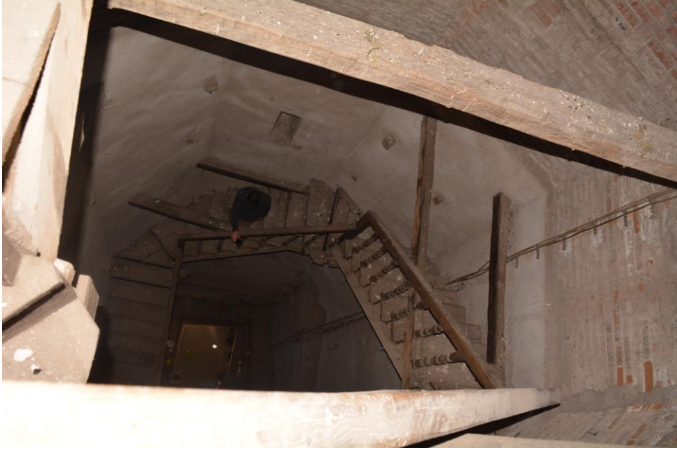
Fotoğraf 182: Saat Kulesi ahşap kontrüksiyonlu iç yapısı
