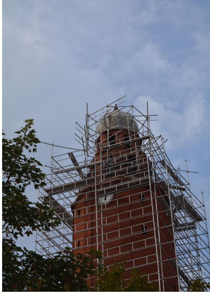
Fotoğraf 180: Saat Kulesi balkon ve külâhı (Restorasyon süreci 2018)
