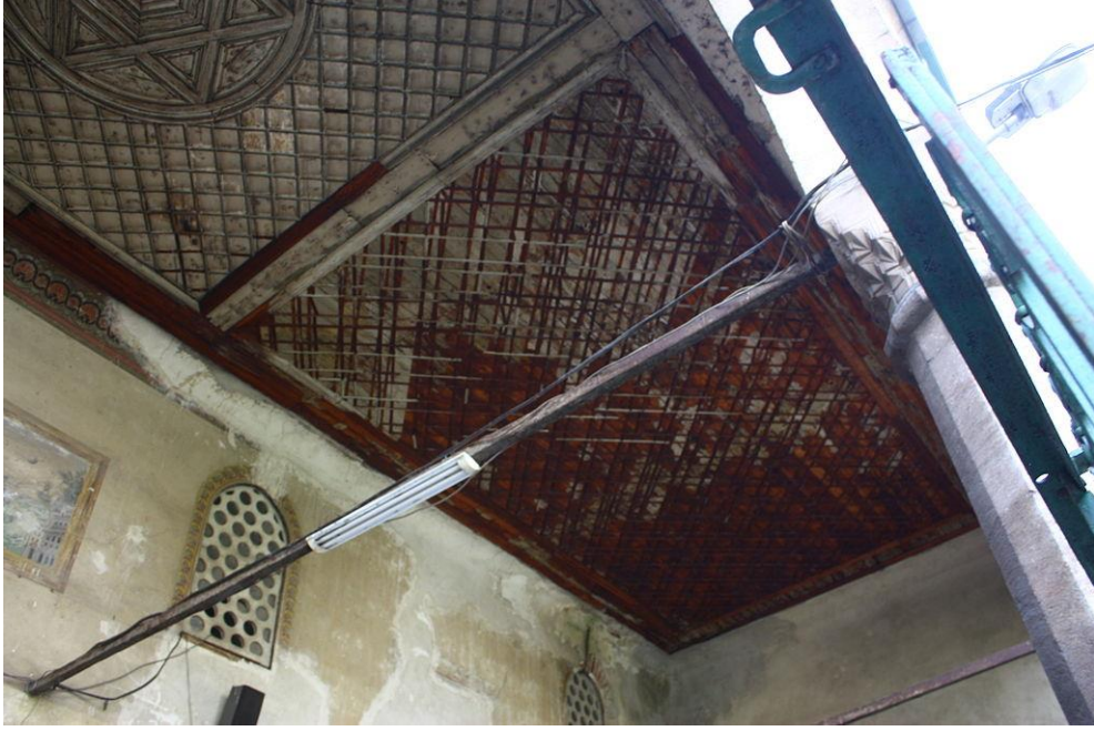
Fotoğraf 59: Sultan Murad Camii son cemaat yeri ahşap kırma çatısı
