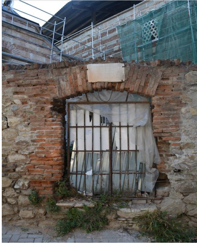
Fotoğraf 28: Sultan Murad Camii Beyhan Sultan T rbesi'ne a ılan avlu kapısı
