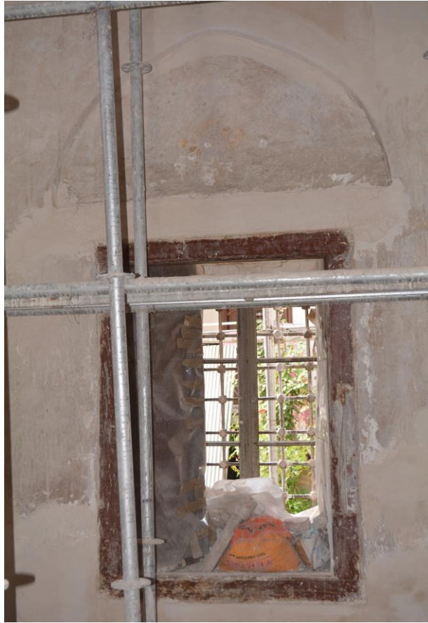
Fotoğraf 124: Beyhan Sultan Türbesi iç mekân alt sıra penceresi ve sivri kemer alınlığı
