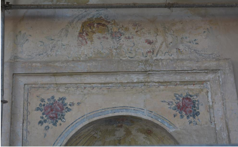
Fotoğraf 50: Sultan Murad Camii son cemaat yeri batı kanadı mihrabiyesi kalemiři süslemeleri (Restorasyon süreci devam ederken. Ekim 2018)
