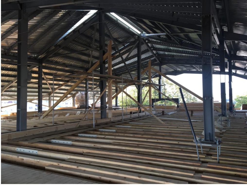
Fotoğraf 17: Sultan Murad Camii örtü sisteminde kullanılan ahşap malzeme (Restorasyon süreci devam ederken. Ekim 2018)
