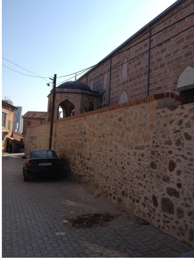
Fotoğraf 31: Sultan Murad Camii dođu avlu duvarı (Restorasyon sonası. 2020)
