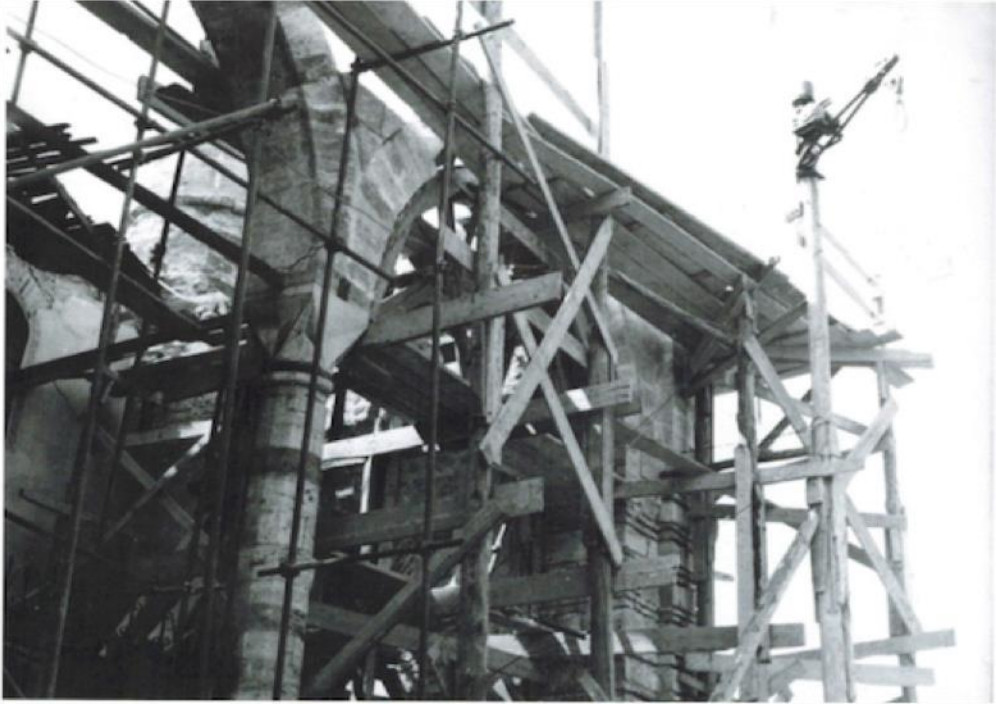
Fotoğraf 201: Sultan Murad Camii son cemaat yeri 1966 onarımı sırasında (Üsküp Milli Konservasyon Arşivi-SZZSK Arşivi'nden)
