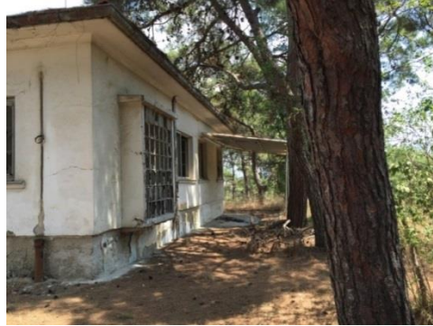
Şekil 4.16 Müdür Evi güney cephe görünüşü
