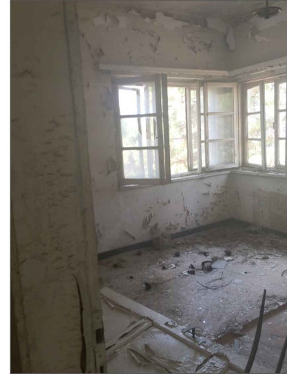
6-LOJMAN EVİ BATI CEPHESİ Z05 NOLU ODADAN BATI DUVARA BAKIŞ
