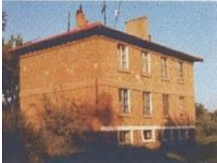
Şekil 5.18 Kayseri Beş Fabrikası Dış Vazife Evi görünüşü (Asıliskender 2002)
