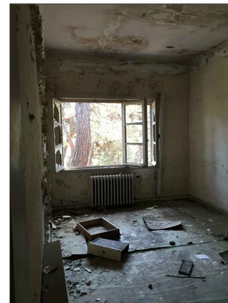
11-Z05 NOLU ODADAN GÜNEY DUVARA BAKIŞ
