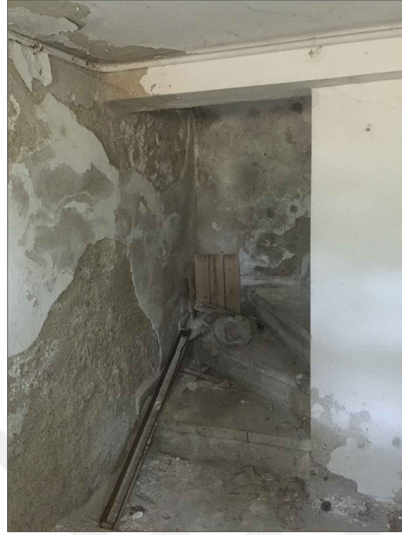
1-LOJMAN EVİ BATI CEPHESİ B01 NOLU ODADAN GÜNEY DUVARA BAKIŞ
