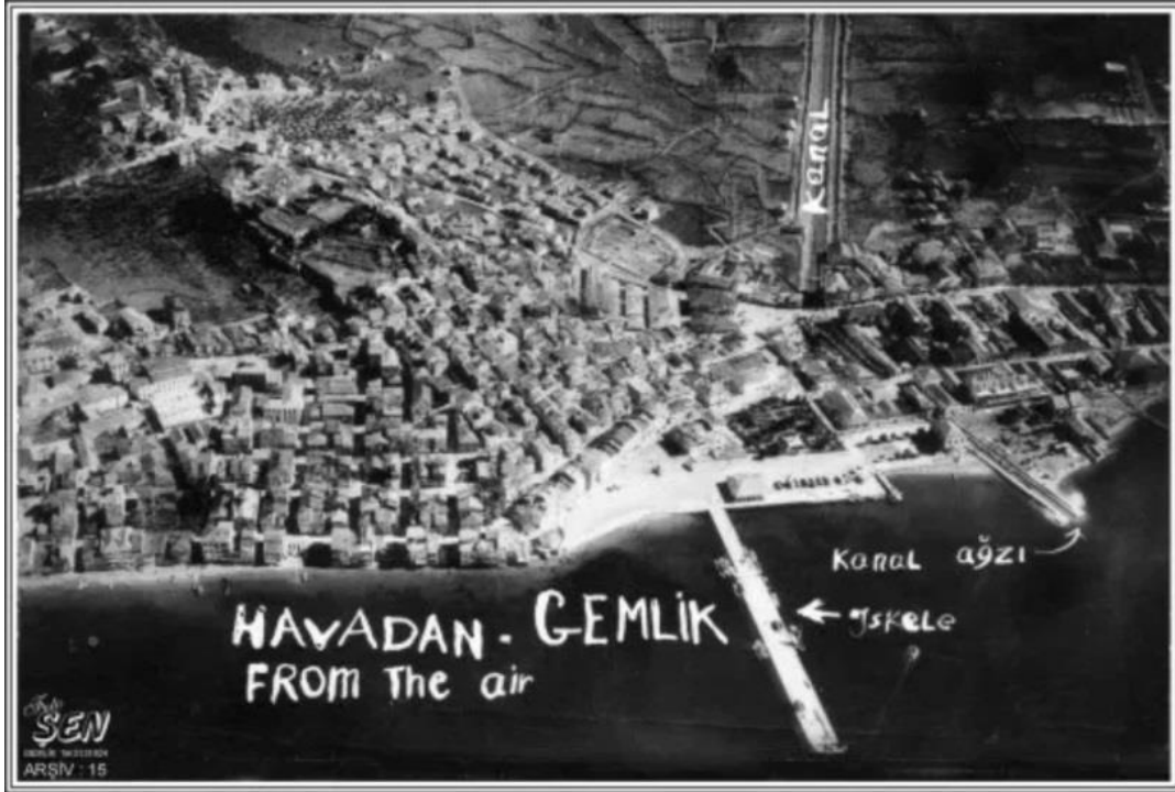
Şekil 2.5 Gemlik ilçesi hava fotoğrafı (Anonim 2018b)
