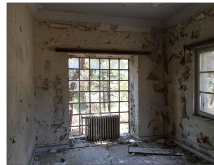
12-Z04 NOLU ODADAN GÜNEY DUVARA BAKIŞ
