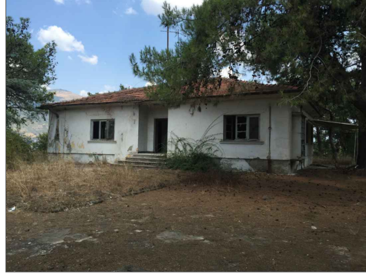
1 - BATI ( GİRİŞ ) CEPHESİ
