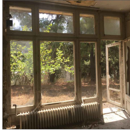
2-LOJMAN EVİ BATI CEPHESİ Z01 NOLU ANTREDEN GÜNEY DUVARA BAKIŞ
