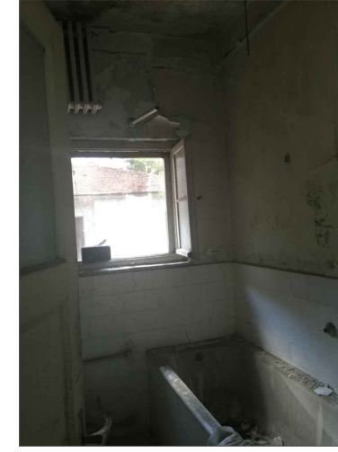
5-LOJMAN EVİ DOĞU CEPHESİ Z04 NOLU BANYODAN DOĞU DUVARA BAKIŞ
