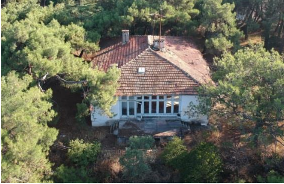
Şekil 4.6 Müdür Evi yapısının hava fotoğrafı, (Tiryaki 2017)
