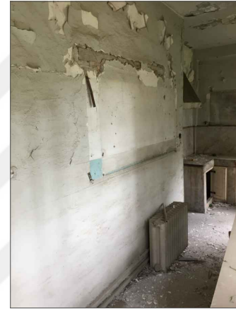
14-Z10 NOLU MUTFAKTAN BATI DUVARA BAKIŞ
