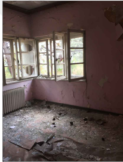
6-LOJMAN EVİ DOĞU CEPHESİ Z05 NOLU ODADAN DOĞUYA BAKIŞ
