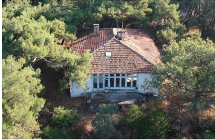
Şekil 4.14 Müdür Evi kuzey cephe görünüşü
