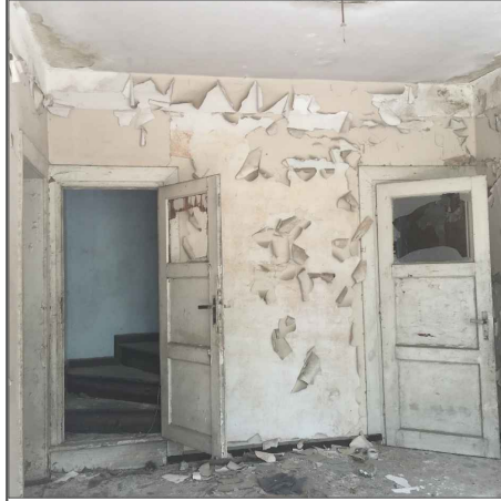
1-LOJMAN EVİ BATI CEPHESİ Z01 NOLU ANTREDEN KUZEY DUVARA BAKIŞ
