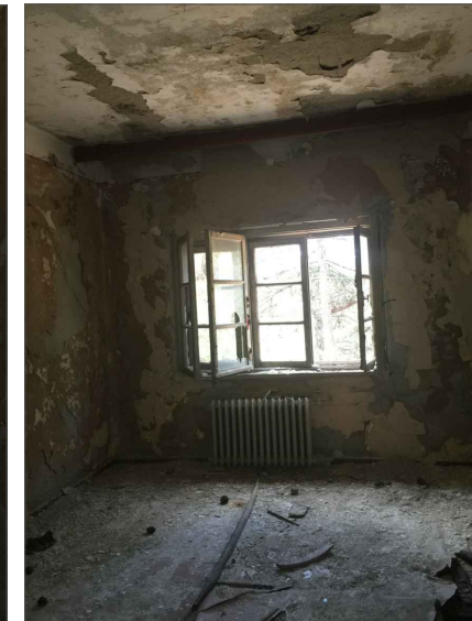
12-LOJMAN EVİ DOĞU CEPHESİ Z02 NOLU SALONDAN KUZEY DUVARA BAKIŞ
