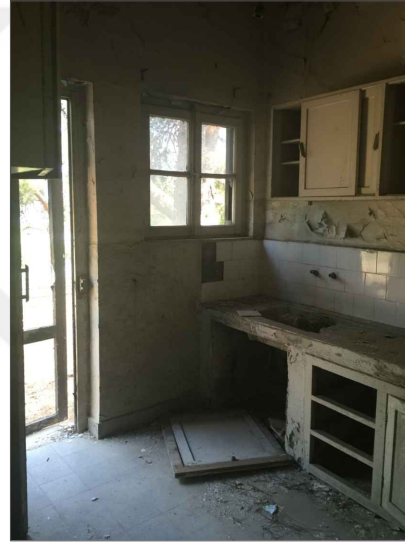
8-LOJMAN EVİ DOĞU CEPHESİ Z06 NOLU MUTFAKTAN KUZEYE BAKIŞ
