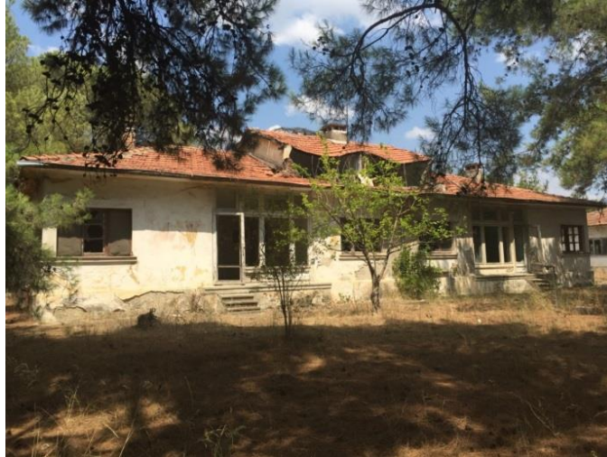
Şekil 4.28 Vazife Evi güney cephe görünüşü
