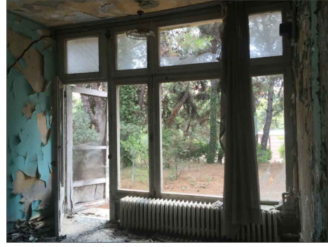
2-LOJMAN EVİ DOĞU CEPHESİ Z01 NOLU ANTREDEN GÜNEY DUVARA BAKIŞ
