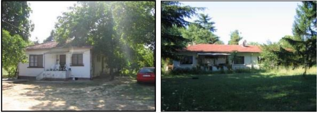
Şekil 5.8 Seka fabrikası lojmanları 1946-1950 yılları (Güzel 2010)
