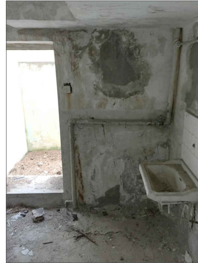
5- B01 NOLU ANTREDEN DOĞU DUVARA BAKIŞ
