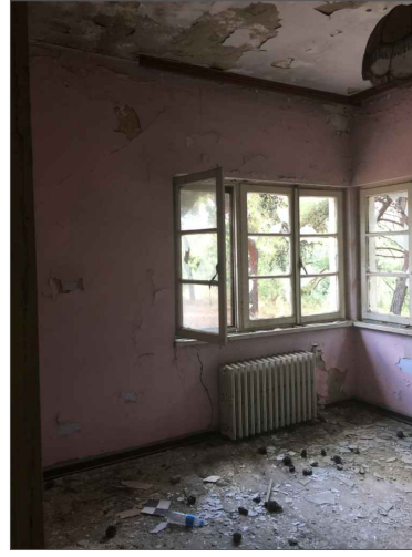
3-LOJMAN EVİ DOĞU CEPHESİ Z03 NOLU ODADAN GÜNEYDOĞUYA BAKIŞ
