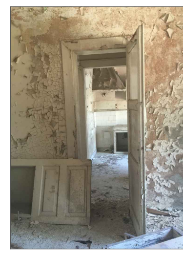
10-LOJMAN EVİ BATI CEPHESİ Z02 NOLU SALONDAN GÜNEYBATI DUVARINA BAKIŞ
