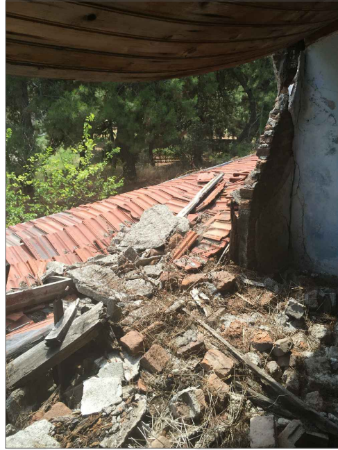
2-LOJMAN EVİ BATI CEPHESİ N02 NOLU ODADAN GÜNEY DUVARA BAKIŞ
