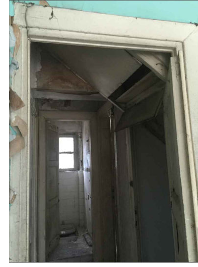
9-LOJMAN EVİ DOĞU CEPHESİ Z07 NOLU WC' DEN KUZEY DUVARA BAKIŞ
