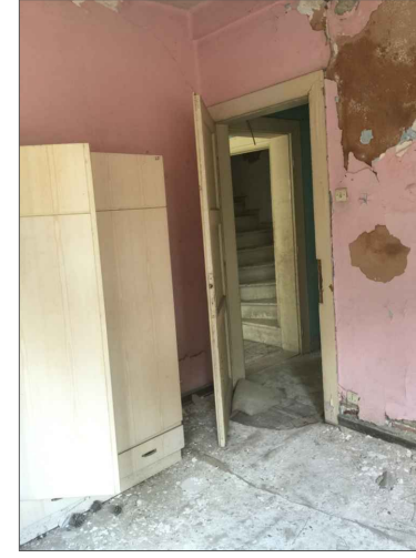
4-LOJMAN EVİ DOĞU CEPHESİ Z03 NOLU ODADAN GİRİŞ KAPISINA BAKIŞ
