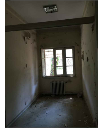
10-Z06 NOLU ODADAN GÜNEY DUVARA BAKIŞ
