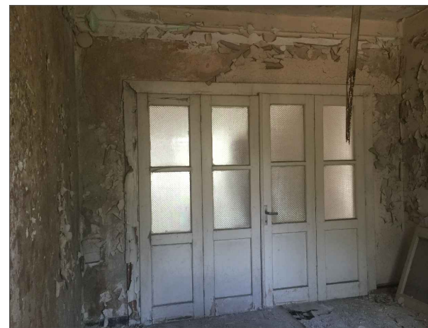
11-LOJMAN EVİ BATI CEPHESİ Z02 NOLU SALONDAN GÜNEY DUVARA BAKIŞ
