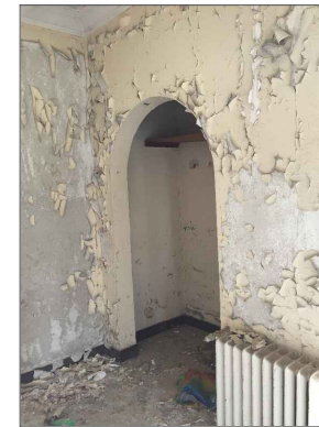
13-Z01 NOLU GİRİŞTEN BATI DUVARA BAKIŞ
