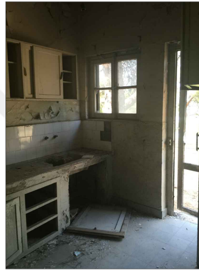
8-LOJMAN EVİ BATI CEPHESİ Z06 NOLU MUTFAKTAN KUZEYE BAKIŞ
