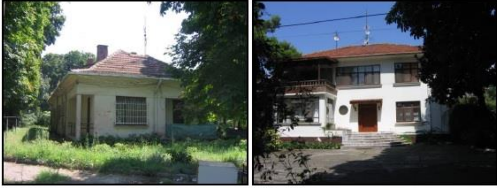
Şekil 5.7 Seka fabrikası lojmanları 1934-1940 yılları (Güzel 2010)
