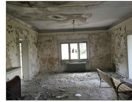
4-Z02 NOLU SALONDAN BATI DUVARA BAKIŞ
