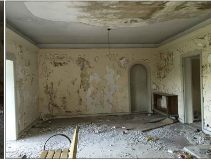
3-Z02 NOLU SALONDAN DOĞU DUVARA BAKIŞ
