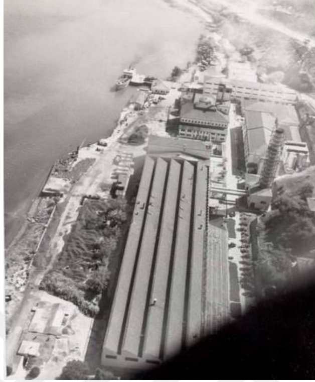
Şekil 3.7 1950'lı yıllarda Gemlik Sunğıpek Fabrikası hava fotoğrafı (U.Ü arşivi 2017)
