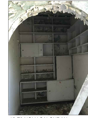
15-Z0 NOLU SALONDAN BATI DUVARA BAKIŞ
