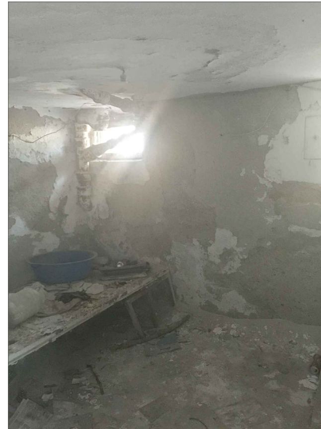
4-LOJMAN EVİ DOĞU CEPHESİ B01 NOLU ODADAN KUZEY DUVARA BAKIŞ
