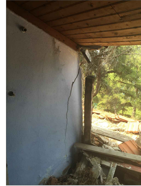
4-LOJMAN EVİ BATI CEPHESİ N01 NOLU ODADAN KUZEY DUVARA BAKIŞ
