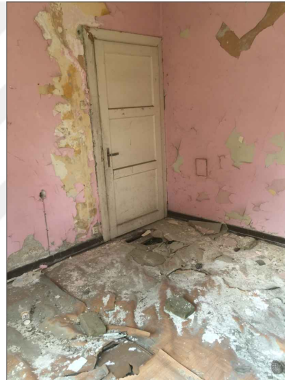
7-LOJMAN EVİ DOĞU CEPHESİ Z05 NOLU ODADAN GİRİŞ KAPISINA BAKIŞ
