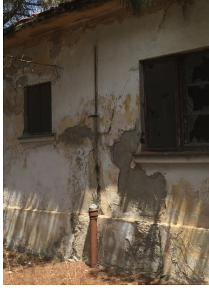
Şekil 4.32 Cephede suyun çıkış yerinde paslanma
