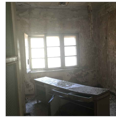
12-LOJMAN EVİ BATI CEPHESİ Z02 NOLU SALONDAN KUZEY DUVARA BAKIŞ
