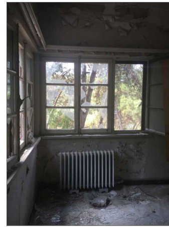
3-LOJMAN EVİ BATI CEPHESİ Z03 NOLU ODADAN GÜNEYBATIYA BAKIŞ
