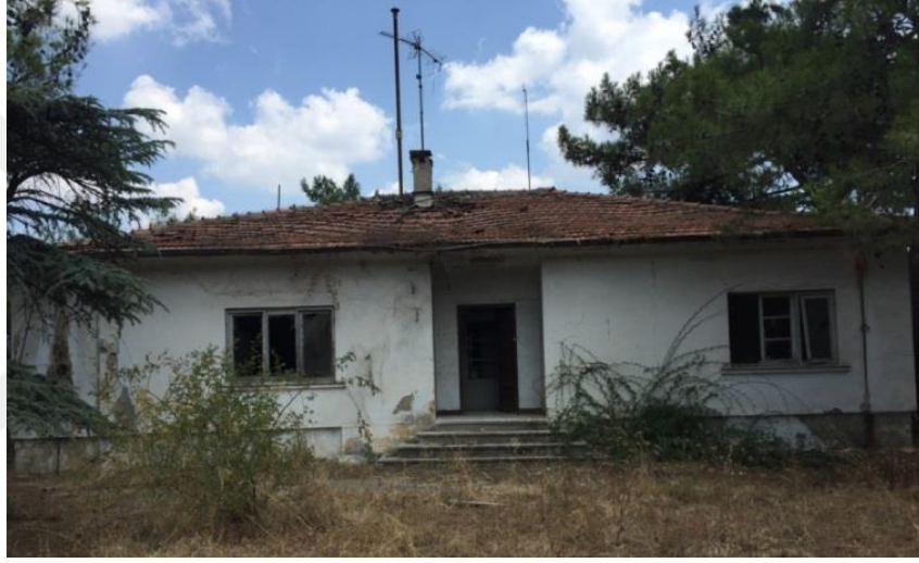
Şekil 4.10 Müdür Evi batı cephe görünüşü
