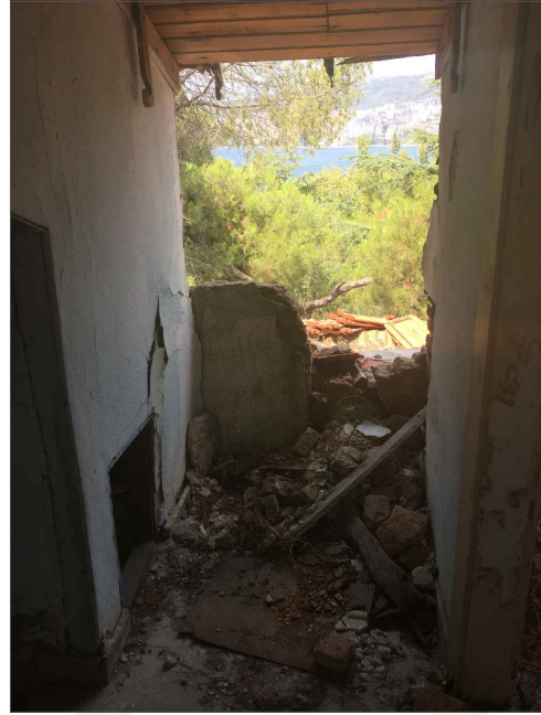
1-LOJMAN EVİ BATI CEPHESİ N03 NOLU ANTREDEN KUZEY DUVARA BAKIŞ
