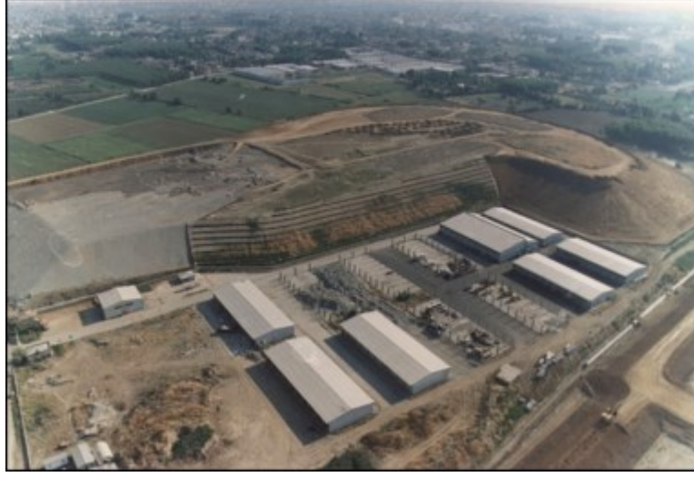
Şekil 4. 22. Demirtaş Rehabilitate Edilmiş Vahşi Depolama Alanı
