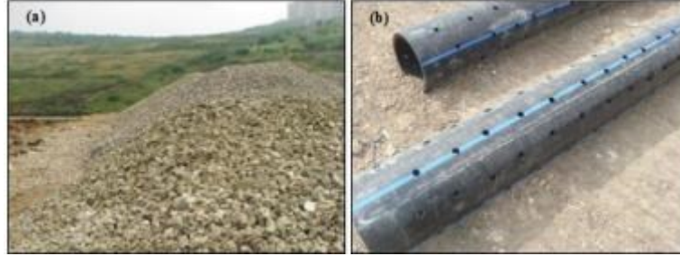
Şekil 4. 12. Hamitler Enerji Üretim Tesisi gaz toplama sisteminde kullanılan yatak malzemeleri (a) yıkanmış dere çakılı (b) HDPE boru
