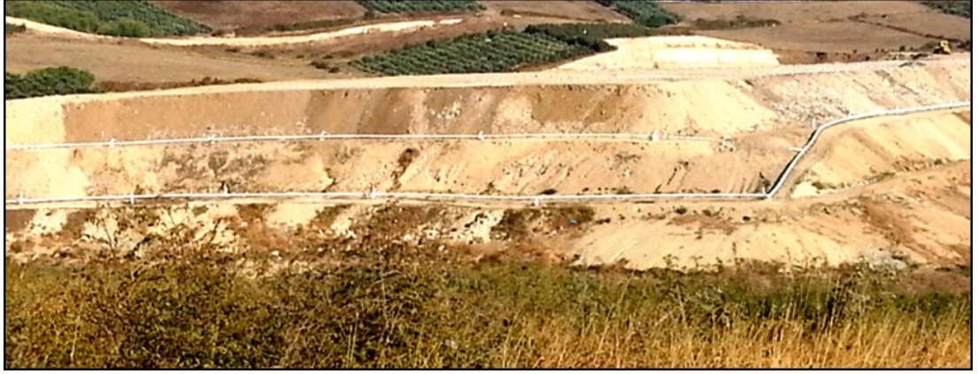
Şekil 4. 10. Hamitler Kent Katı Atık Düzenli Depolama Alanında ana vadide inşa edilen gaz toplama hatları
