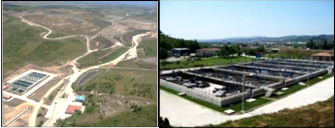
Şekil 4. 7. Bursa Hamitler Sızıntı Suyu Arıtma Tesisi
