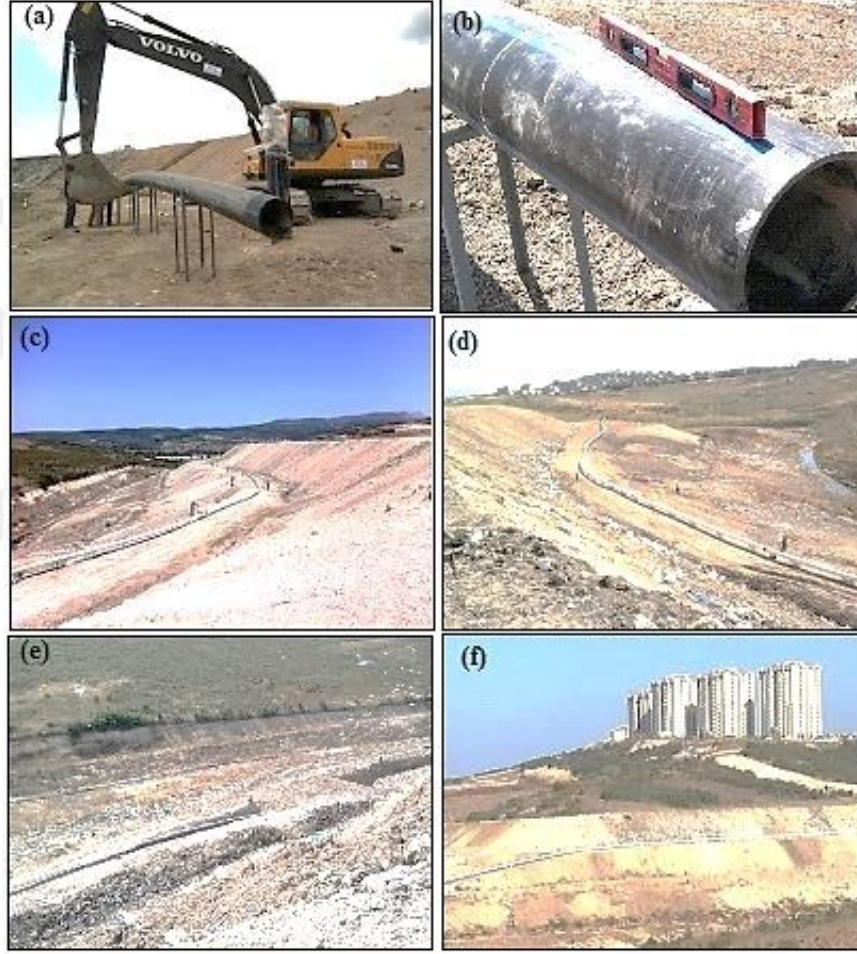
Şekil 4. 14. Hamitler Enerji Üretim Tesisi gaz toplama sistemi için (a) ve (b) ana toplama hattı yapımı (c) ve (d) zemin üstü ana toplama hattı (e) zemin altı ana toplama hattı (f) katmanlar arası ana toplama hattı
