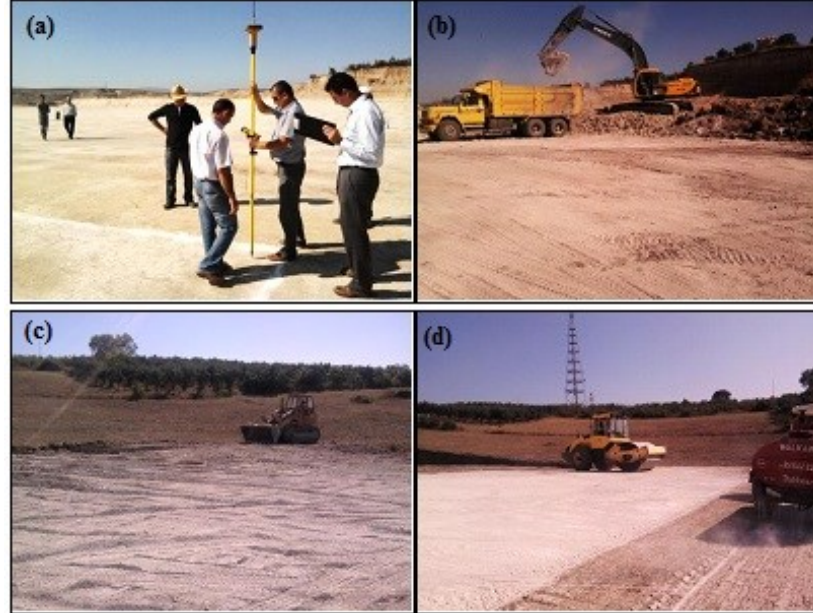
Şekil 4. 16. Hamitler Enerji Üretim Tesisi yerleşimi için (a) yerinde aplikasyon (b) ve (c) ve (d) arazi tesviyesi
