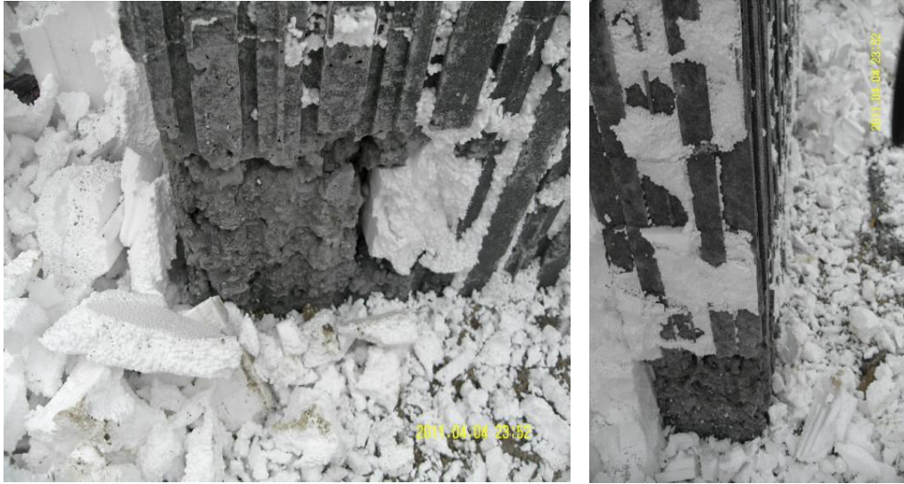
Şekil 12: EPS Kalıp Söküldükten Sonra Geleneksel Betonda Gözlenen Ayrışma (Özşahin, 2011)
