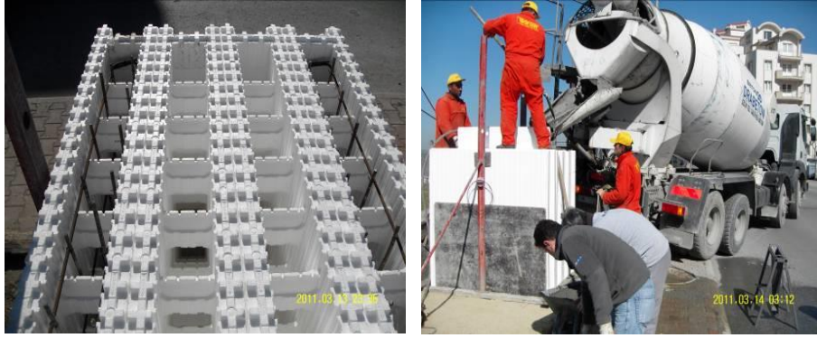
Şekil 7: Deneysel Çalışmada Kullanılan Donatılı ve Donatısız Duvar Numunelerinin Beton Dökümü (Özşahin, 2011)
