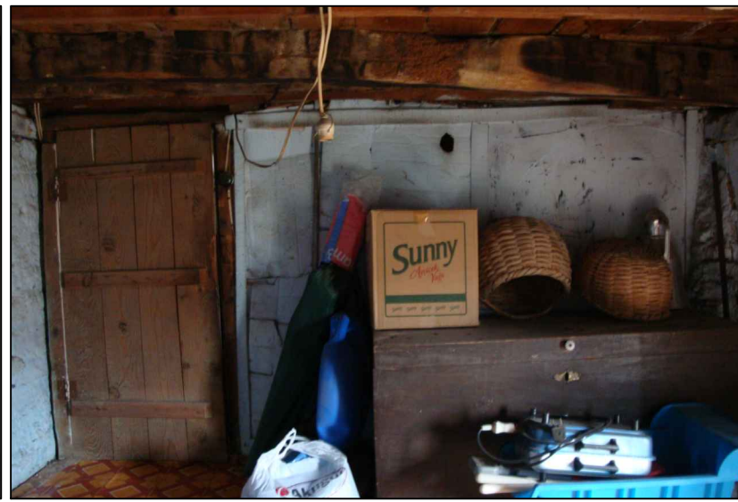
53. A03 ODA-Kuzey duvarı
