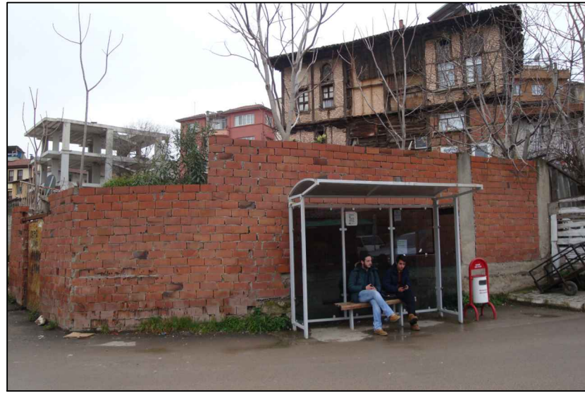
141. DOĞU BAHÇE DUVARI
