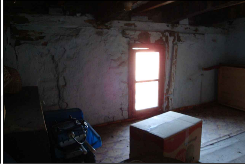
54. A03 ODA-Doğu duvarı
