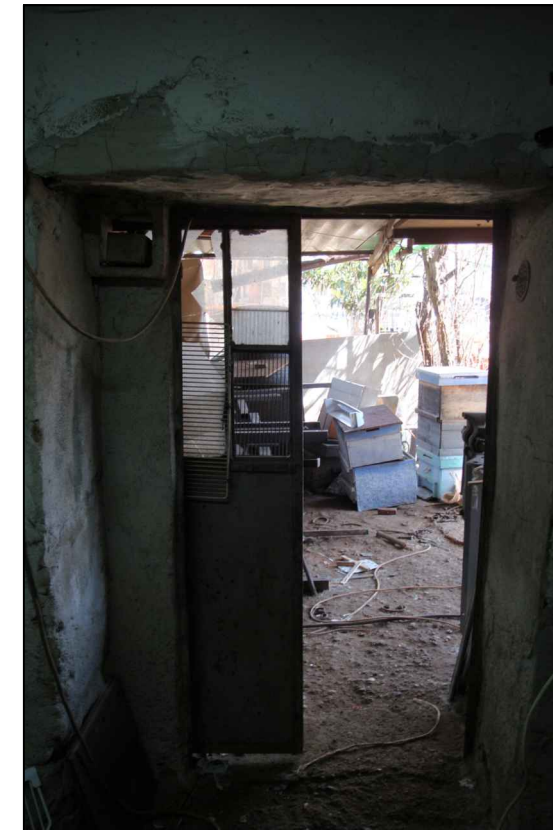
12. B02 DEPO-Demir kapı
