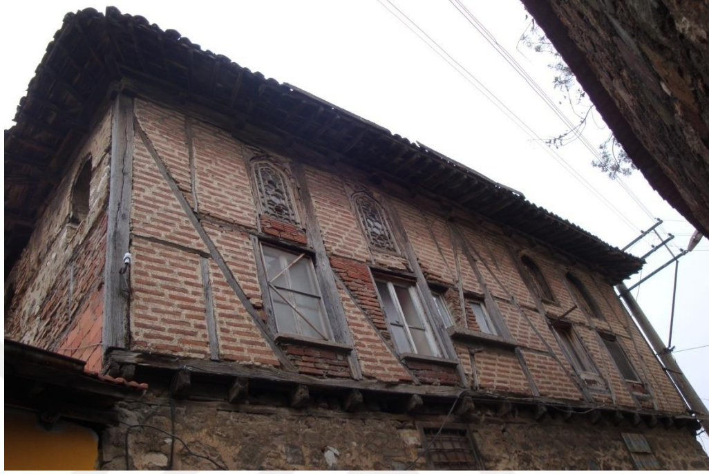
Şekil 3.39. Birinci kat, batı cephe tuğla dolgulu ahşap karkas duvar
