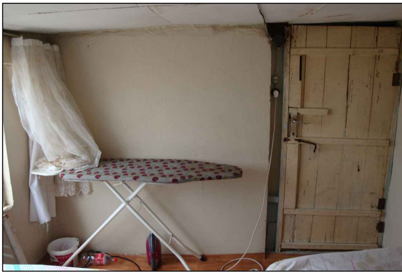
51. A02 ODA-Güney duvarı
