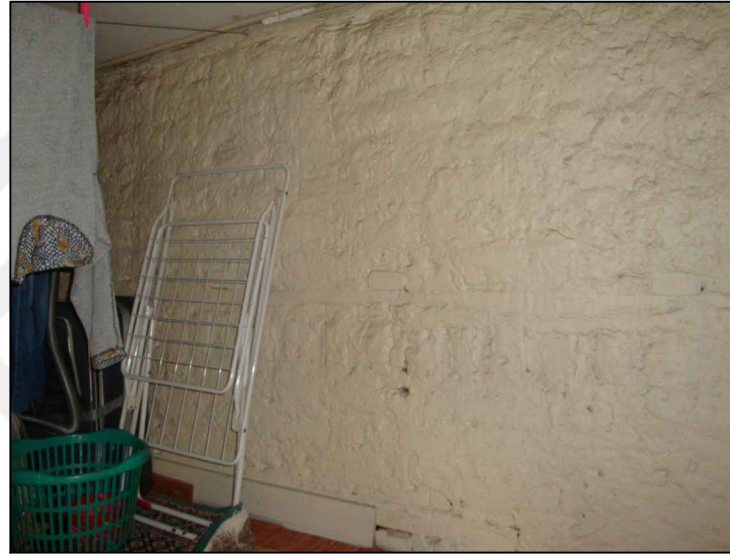
47. A01 HOL-Batı duvarı
