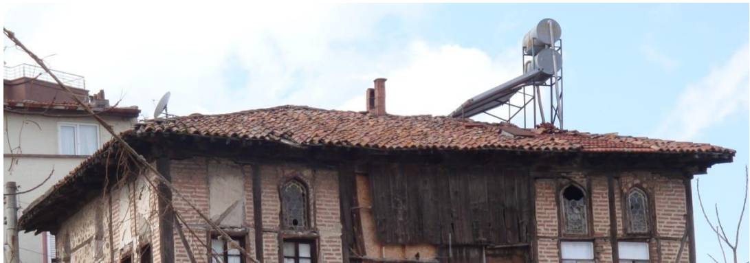
Şekil 3.47. Çatı genel görünümü
