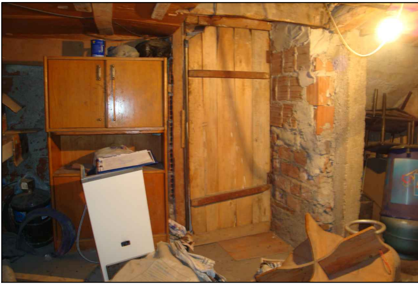
57. A04 ODA-Kuzey duvarı
