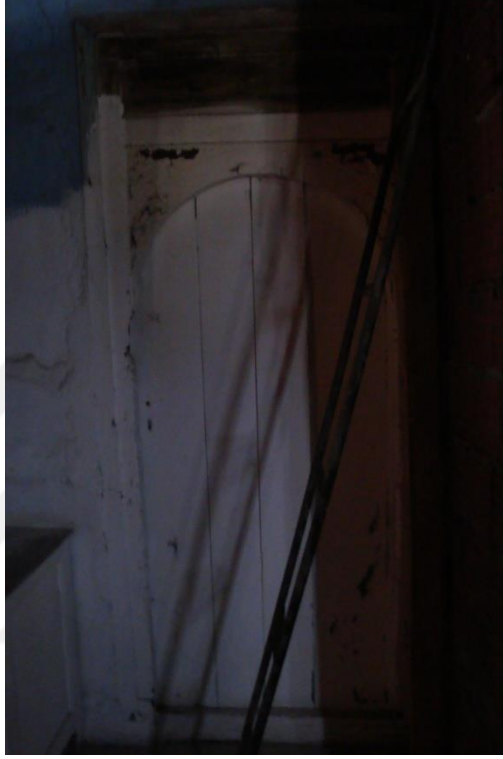
Şekil 3.49. 108 No’lu Başoda giriş kapısı
