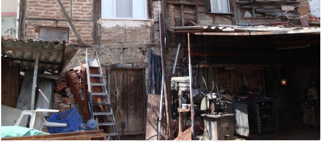
Şekil 3.35. Bodrum kat, doğu cephe moloz taş duvar
