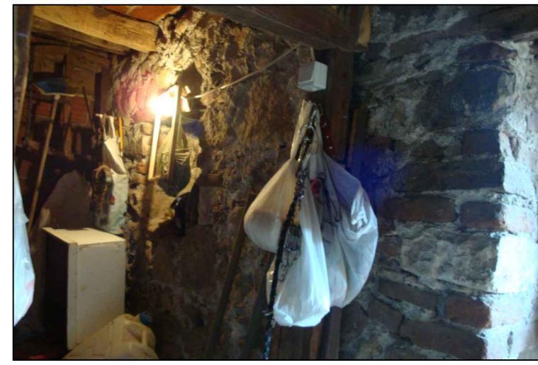
4. B01 DEPO-Doğu duvarı
