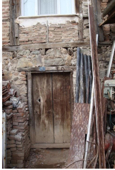
Şekil 3.5. Doğu cephe ahşap giriş kapısı
