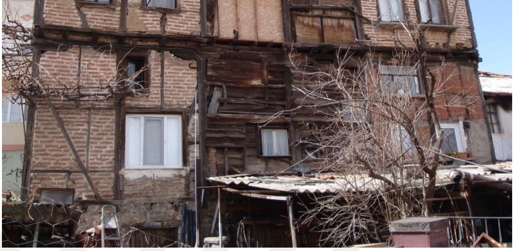
Şekil 3.37. Zemin kat, doğu cephe tuğla dolgulu ahşap karkas duvar
