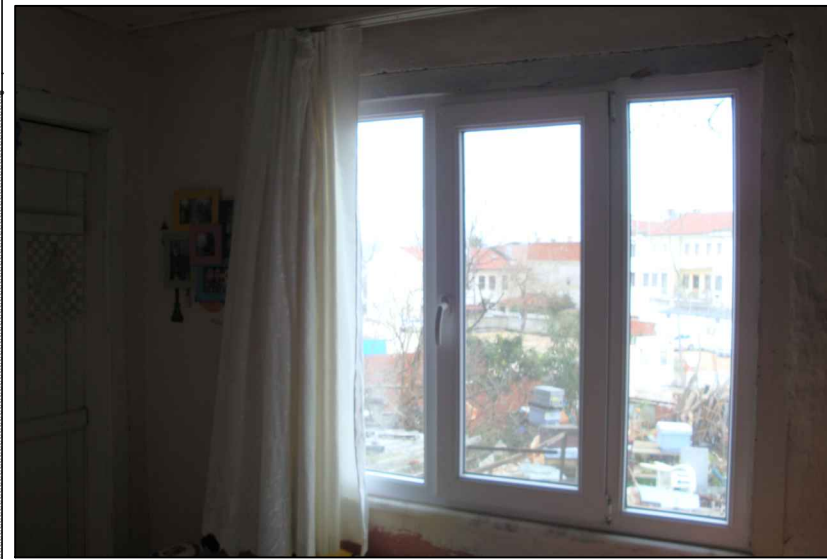
42. Z08 ODA-Doğu duvarı
