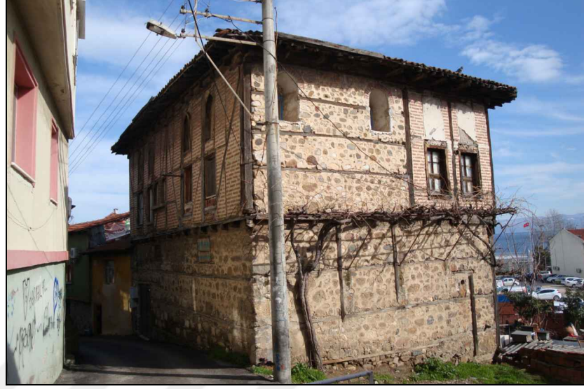
126. GÜNEY (SOL YAN) CEPHE
