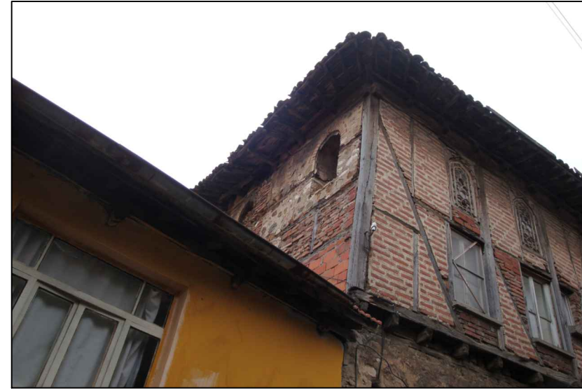
132. KUZEY (SAĞ YAN) CEPHE
