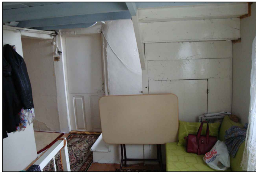
31. Z06 HOL-Kuzey duvarı
