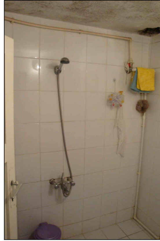
27. Z04 BANYO -Güney duvarı
