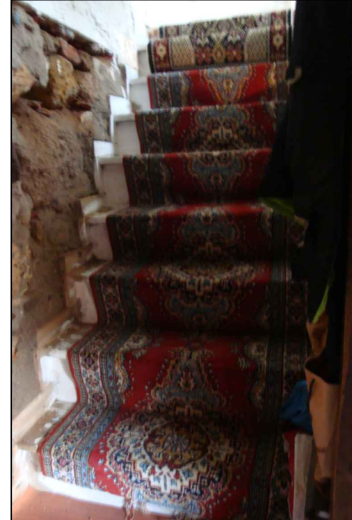
7. B01 DEPO-Ahşap Merdiven
