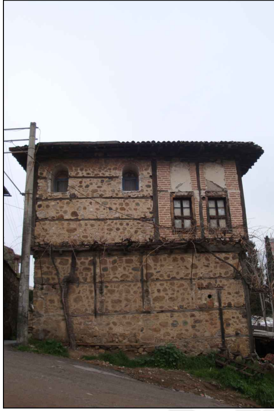
125. GÜNEY (SOL YAN) CEPHE
