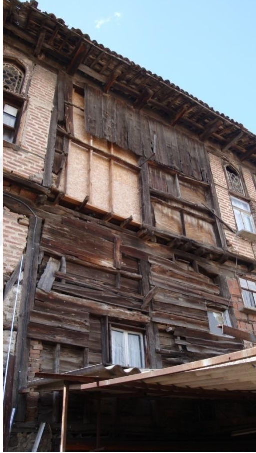
Şekil 3.42. Zemin ve birinci kat, dođu cephe orta bölüm
