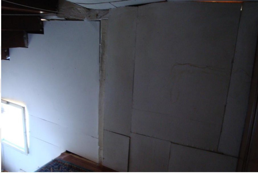
Şekil 3.15. A01 Hol'deki ahşap dikme ve sunta kaplamalar
