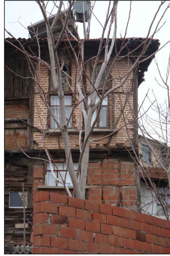
106. DOĞU (ÖN) CEPHE
