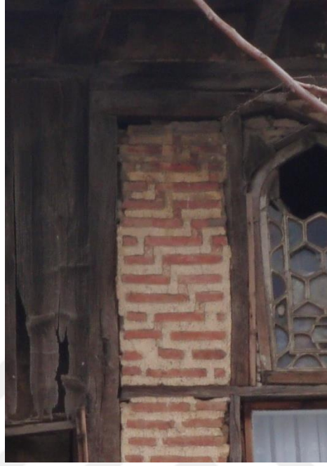
Şekil 3.45. Birinci kat batı cephe tuğla merdiven şekli
