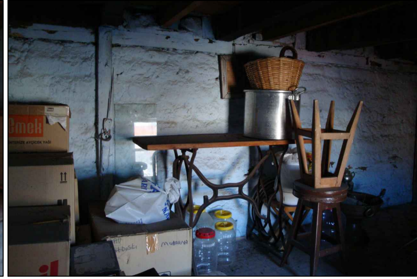
56. A03 ODA-Güney duvarı
