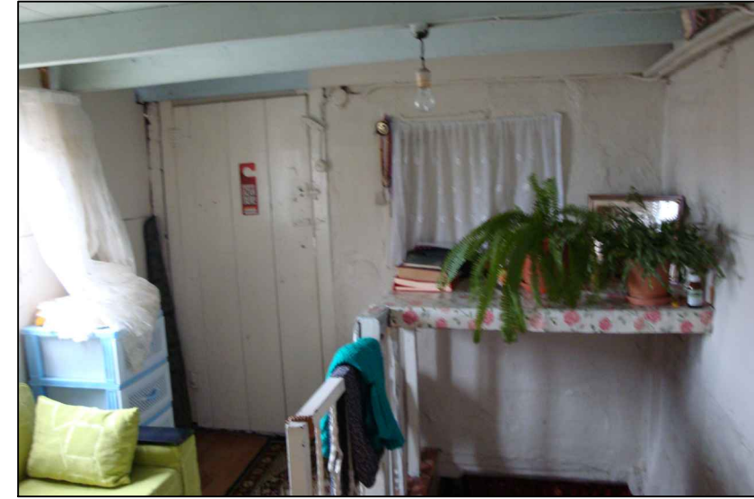
34. Z06 HOL-Güney duvarı
