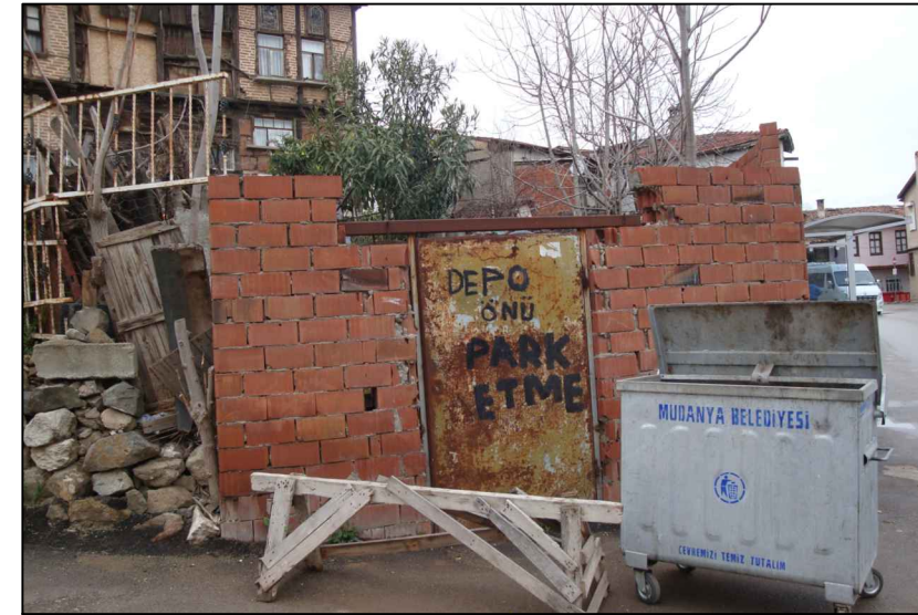
139. GÜNEY BAHÇE DUVARI
