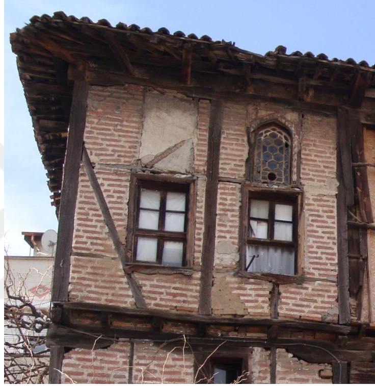
Şekil 3.43. Birinci kat, doğu cephe ahşap dikme ve kirişler
