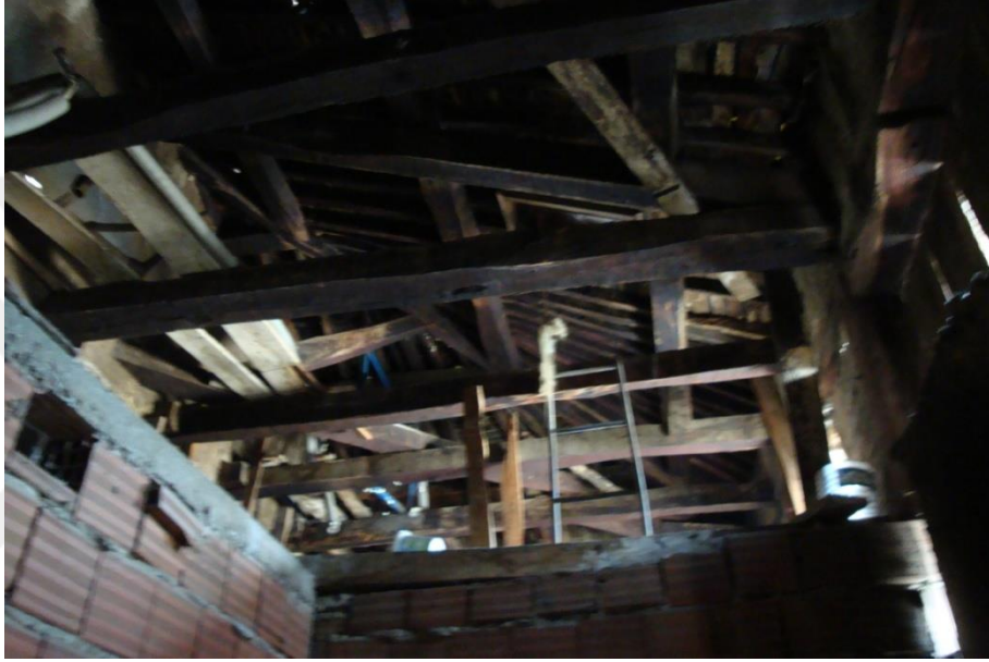
Şekil 3.48. Çatı iç görünümü
