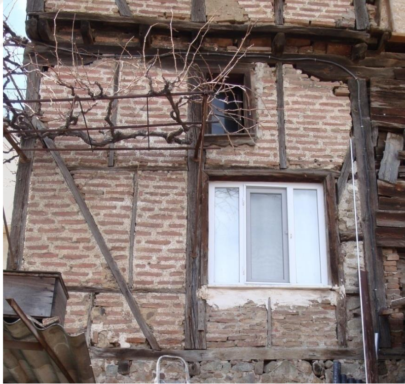
Şekil 3.41. Zemin kat, doğu cephe ahşap dikme ve kirişler
