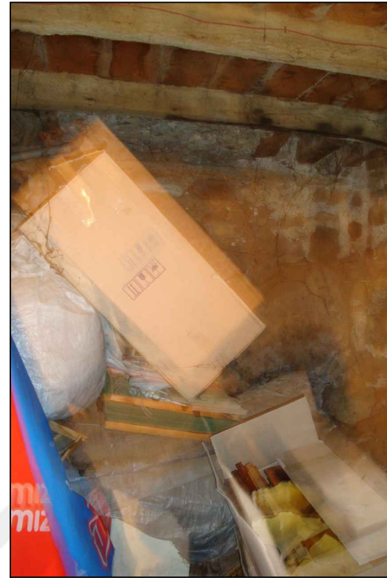
3. B01 DEPO-Güney duvarı
