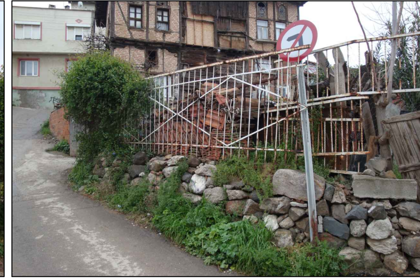
138. GÜNEY BAHÇE DUVARI
