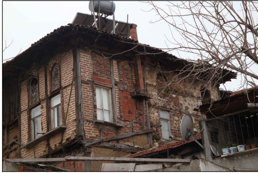
131. KUZEY (SAĞ YAN) CEPHE
