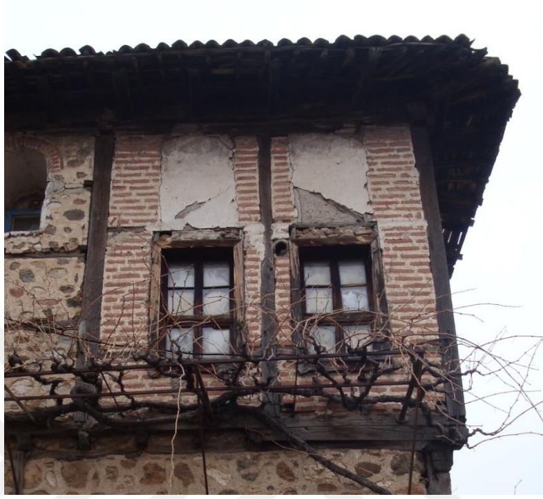
Şekil 3.44. Birinci kat, güney cephe ahşap dikme ve kirişleri
