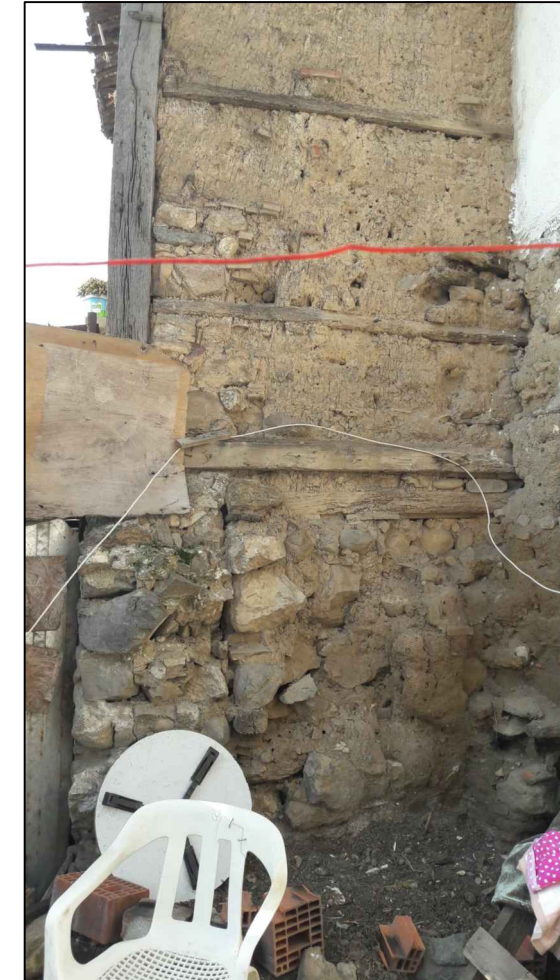
135. KUZEY (SAĞ YAN) CEPHE
