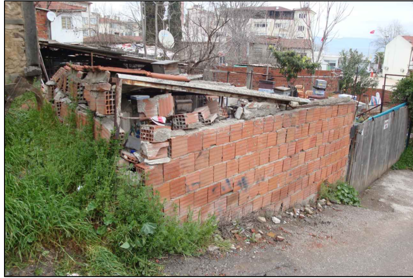
136. GÜNEY BAHÇE DUVARI
