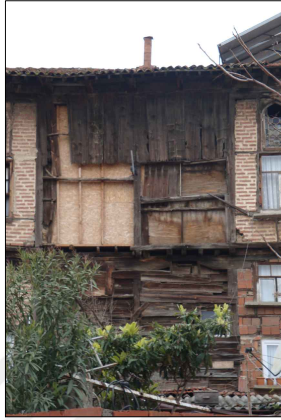
105. DOĞU (ÖN) CEPHE
