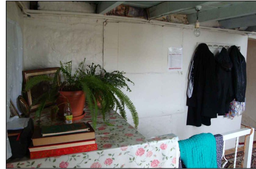
35. Z06 HOL-Batı duvarı
