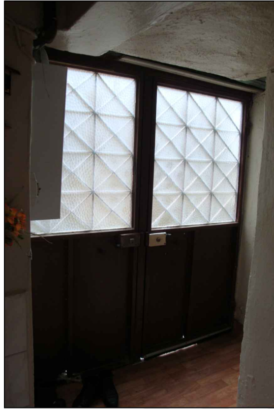
13. Z01 GİRİŞ HOLÜ- Batı duvarı
