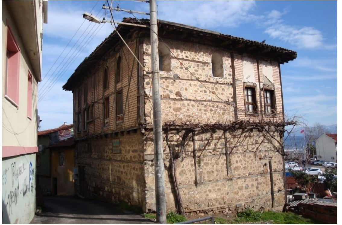
Şekil 3.36. Zemin kat, batı ve güney cephe moloz taş duvar
