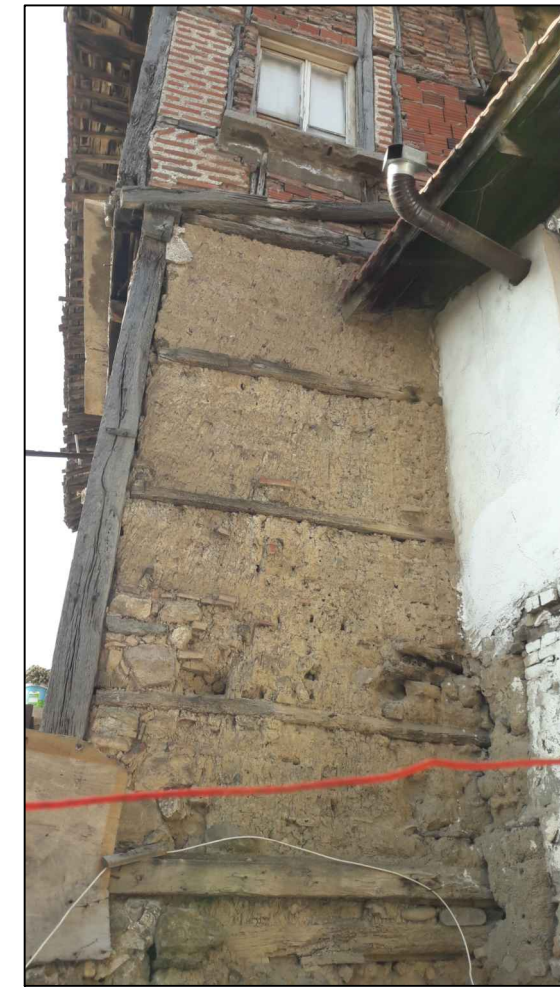
134. KUZEY (SAĞ YAN) CEPHE
