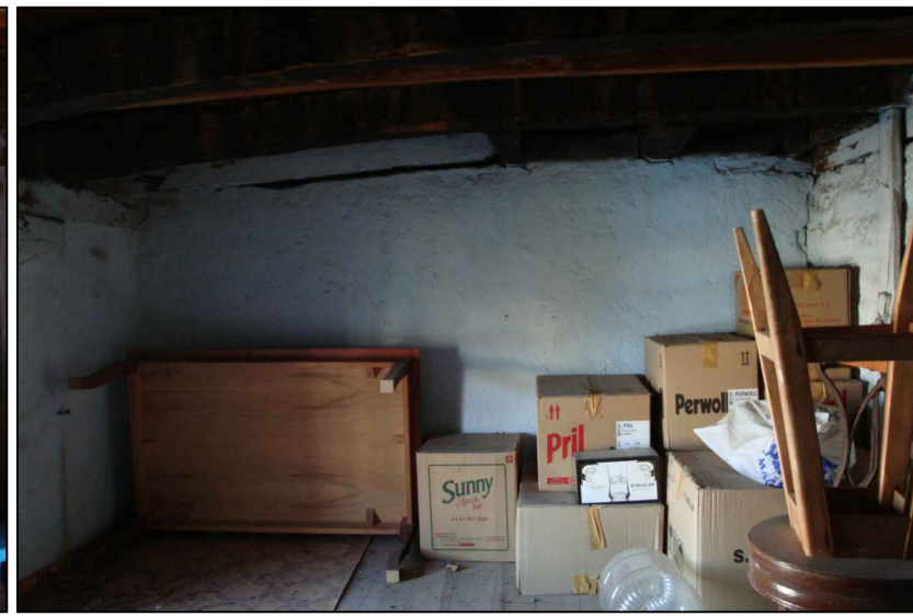
55. A03 ODA-Güney duvarı
