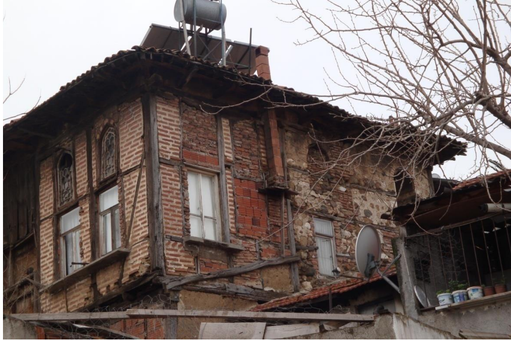
Şekil 3.40. Birinci kat, kuzey cephe moloz taş duvar
