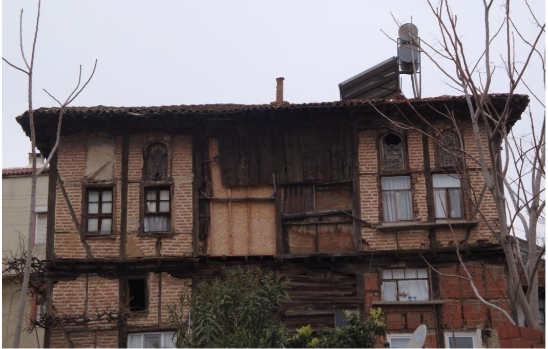
Şekil 3.38. Birinci kat, doğu cephe tuğla dolgulu ahşap karkas duvar
