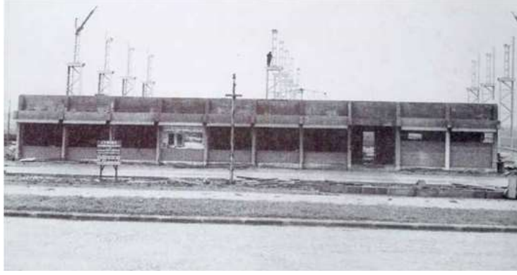
Şekil 3.17. 1971 ÇEMTAŞ İdari Bina ve Çelikhane İnşaatı (Kuter 2017'den alınan ÇEMTAŞ Arşivi)
