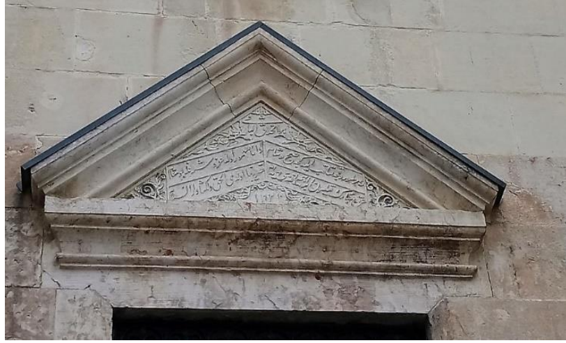
Şekil 119. Bina giriş kapısı üzerindeki taş yazıt (Acam arşivi 2019)
