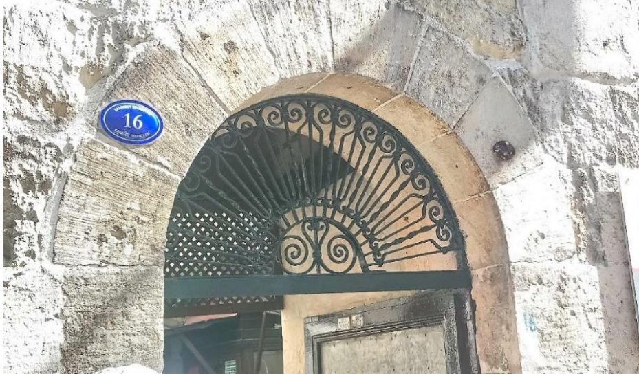
Şekil 118. Bahçe kapısı üzerinde yer alan süslü demir korkuluk (Acam arşivi 2019)
