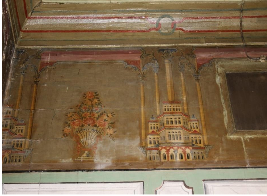
Şekil 73. Eyvan duvarları üst bölümünün resimlerinden detay (Acam arşivi 2019)
