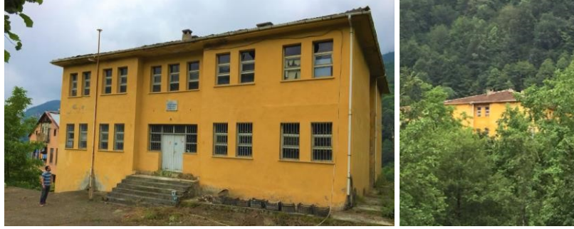
Şekil 2. 20. Atıl durumdaki Çaykara Kabataş köyü okul binası (Aktürk arşivi 2019)
