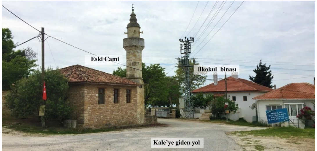
Şekil 4. 60. Seddülbahir köyü Eski Cami ve köy ilkokulunun sağ yan cephesi (Aktürk arşivi 2019)
