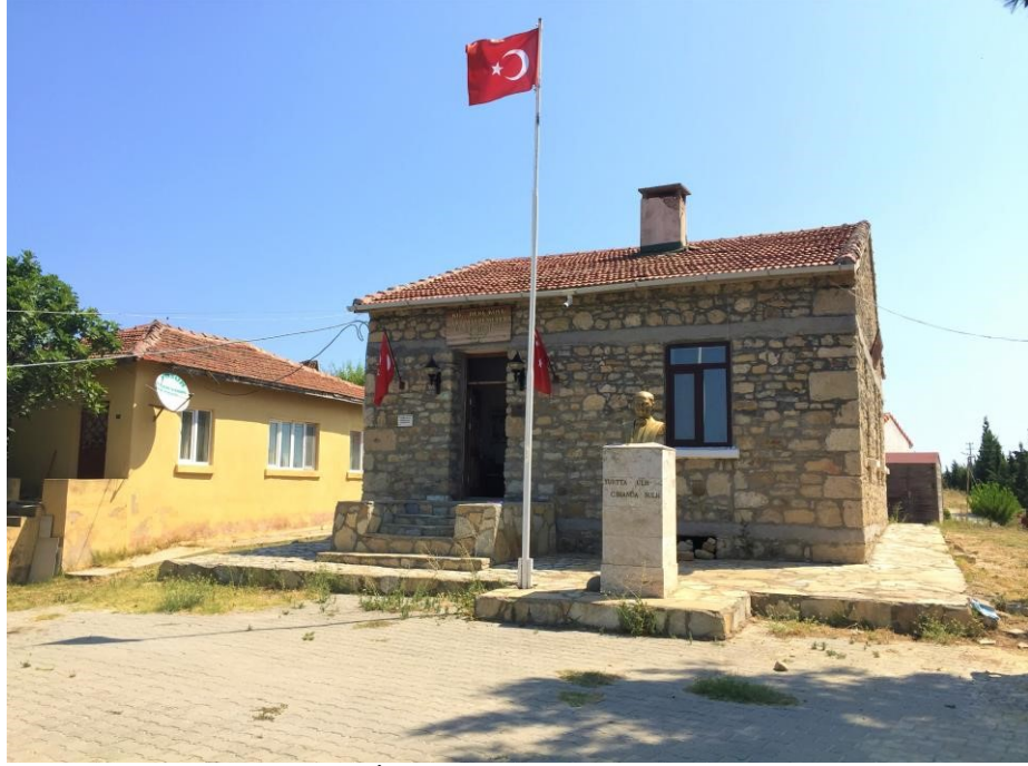
Şekil 4. 98. Kocadere İlkokulu giriş cephesi (Aktürk arşivi 2019)
