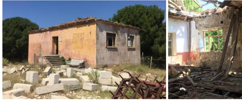
Şekil 2. 21. Atıl durumdaki Büyükanafartalar köyü okul binası (Aktürk arşivi 2019)
