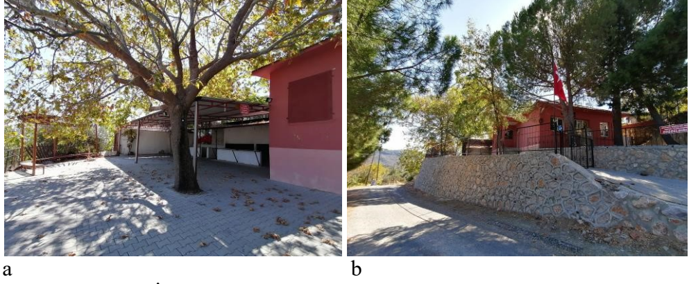
Şekil 4. 50. a Boztepe İlkokulu'nda bahçeye eklenen üst örtü, b. yol ile bahçe arasına eklenen istinat duvarı (Aktürk arşivi 2019)
