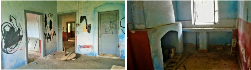
Şekil 4. 28. Akköy İlkokulu eski binanın iç mekânı (Aktürk arşivi 2019)
