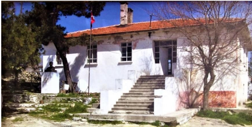
Şekil 4. 78. Behramlı İlkokulu'nun restorasyondan önceki hali
