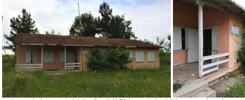
Şekil 2. 19. Atıl durumdaki Bafra Elifli köyü okul binası (Aktürk arşivi 2019)
