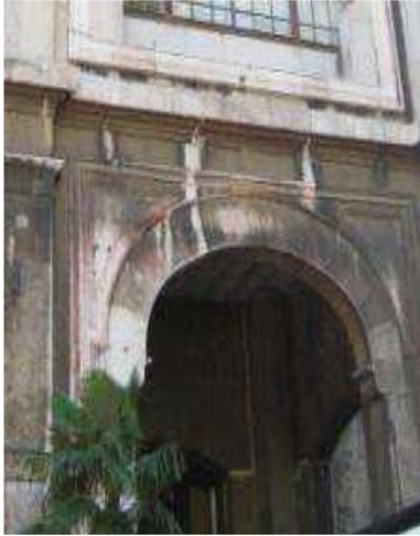
Şekil 5.3. İç ve dış cepheden müdahale gerektiren bozulmalar. A. Dökülen duvar kalem işleri. B. Dökülen tavan kalem işleri. C. Eskiye ahşap çatı. D. Dış cephe kirlilik ve çatlak. E. Dış cephe korozyon ve kirlilik. F. Dış cephe korozyon ve akıntı
