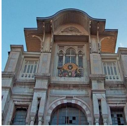
Őekil 2.28. Mektebi Tıbbiye doęu cephe(2019)
