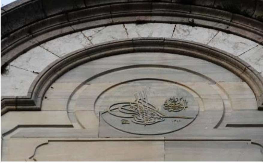
Şekil 4.22. Batı cephe tuğra (2017)
