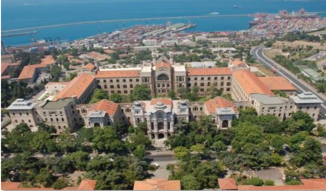
Şekil 4.11. Mektebi Tıbbiye doğu cephe üstten görünüş (2015)
