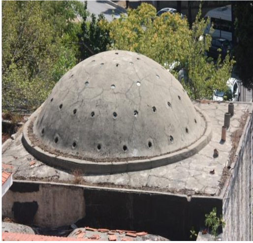
Şekil 4.29. Sıcaklık bölümü üst örtüsü
