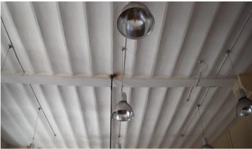
Şekil 4.23. Volta tekniği tavan (2017)
