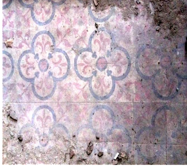
Şekil 4.31. Soyunmalık bölümü zemin kat özgün mozaik döşeme kaplaması (2016)
