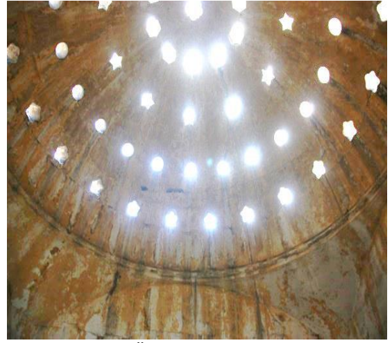
Şekil 4.30. Üst örtü ışıklıklar
