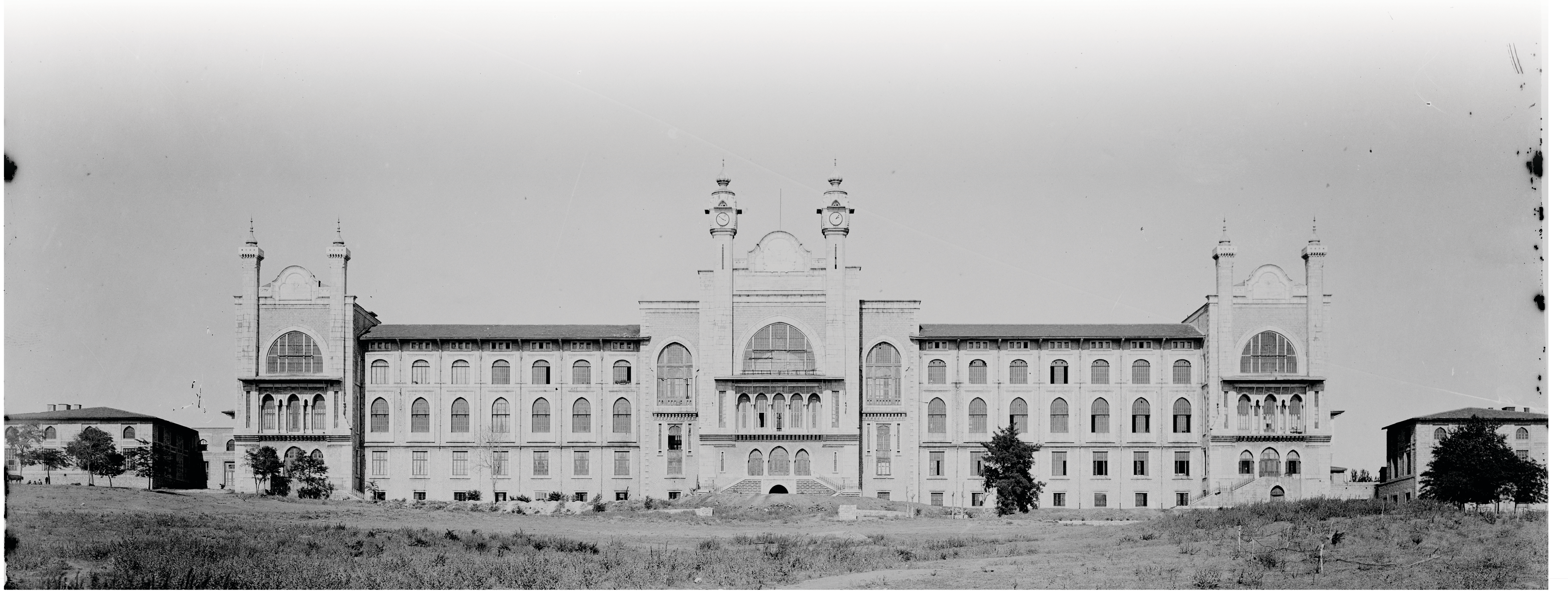
Mekteb-i Tıbbiye-i Şahane Binası, Batı Cephesi Fotoğrafı, 1930 Kaynak: Alman Arkeoloji Enstitüsü Arşivi
