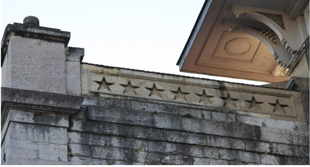
B. Doğu cephe detay, yıldızlar ve saçak konsolları
