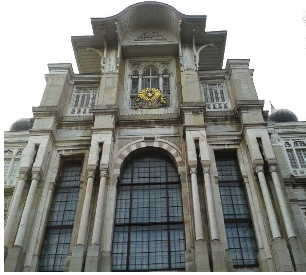
Şekil 4.15. Doğu cephe rektörlük katı
