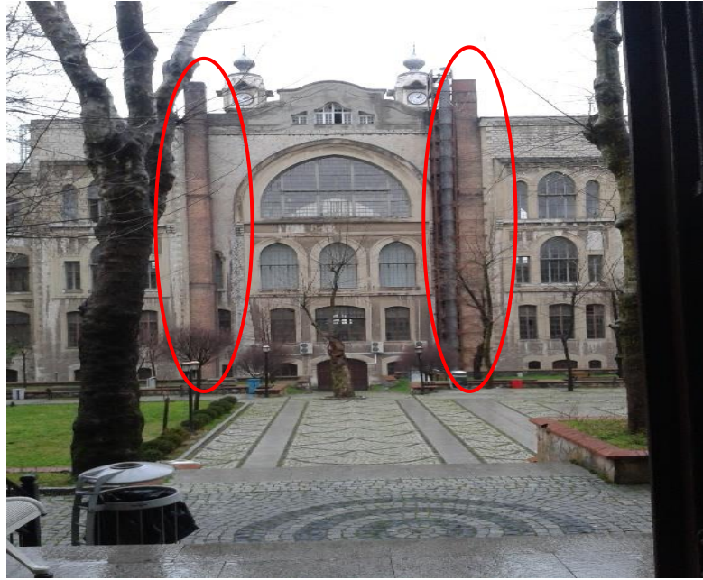
Şekil 4.52. İç avlu batı ana girişi sonradan eklenen bacalar
