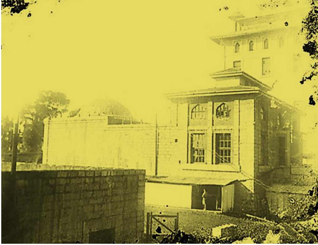
Şekil 4.27. Hamamın güneydoğu yönünden görünüş http://earsiv.sehir.edu.tr.8080/xmlui/handle/11498/48856 (Anonim c. 2020)
