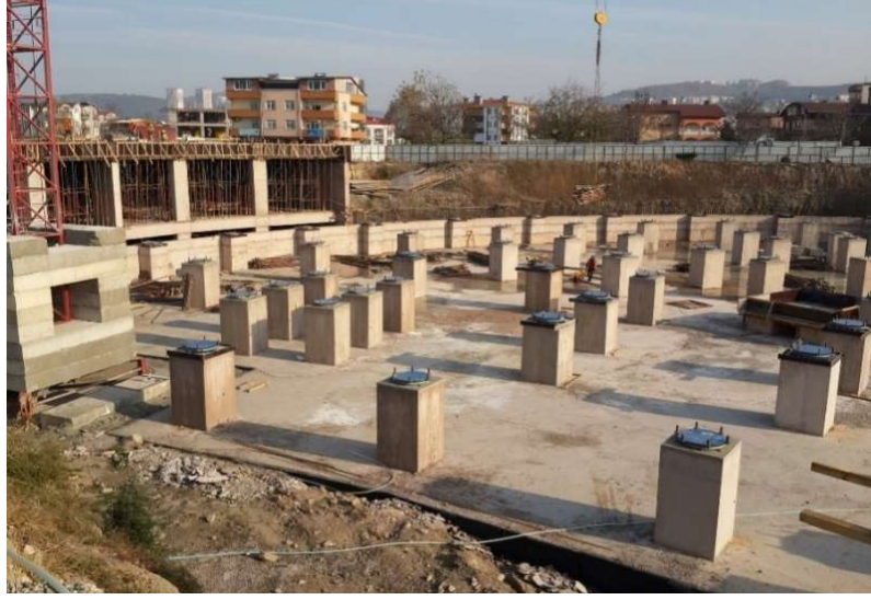
Şekil 2.18. Bursa Kestel Rafet Kahraman Devlet Hastanesi Sürtünmeli Sarkaç tipi izolatörlerin dağılımı.
