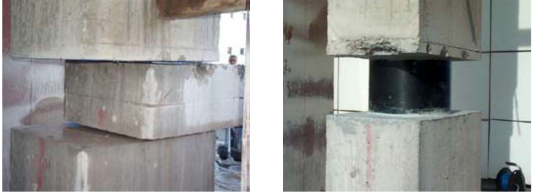
Şekil 2.14. Kolonların kesilmesi ve izolatörün yerleştirilmesi
