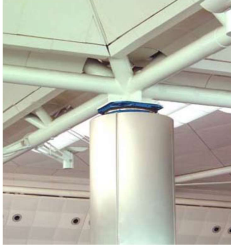
Şekil 2.16. Atatürk havalimanı sürtünmeli sarkaç izolatör örneği
