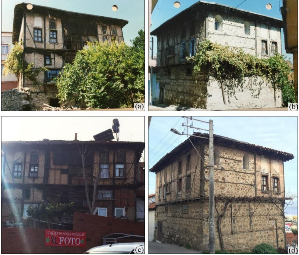
Şekil 3. 67. 1990 yılına ait Kenan Doğruöz Evi (a) doğu cephesi, (b) güneybatı cephesi (B.K.V.K.B.K. Arşivi), 2016 yılına ait Kenan Doğruöz Evi (c) doğu cephesi, (d) güneybatı cephesi
