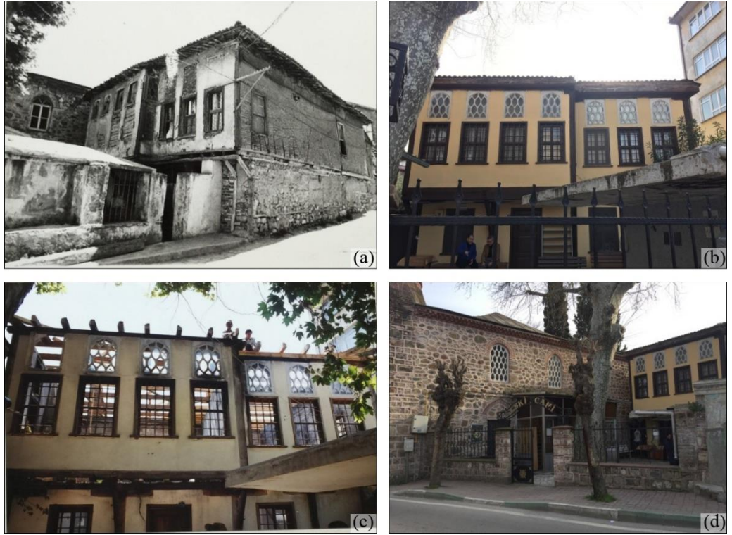
Şekil 3. 48. (a) Eski Cami meşrutası 1976 yılı (BKVKBK arşivi 2016), (b) Caddeden görünüm-kuzey cephesi (2016), (c) Yangın sonrası restorasyon aşaması (B.K.V.K.B.K. arşivi 2016), (d) Eski Cami kuzey cephesi ve Eski Cami meşrutası.
