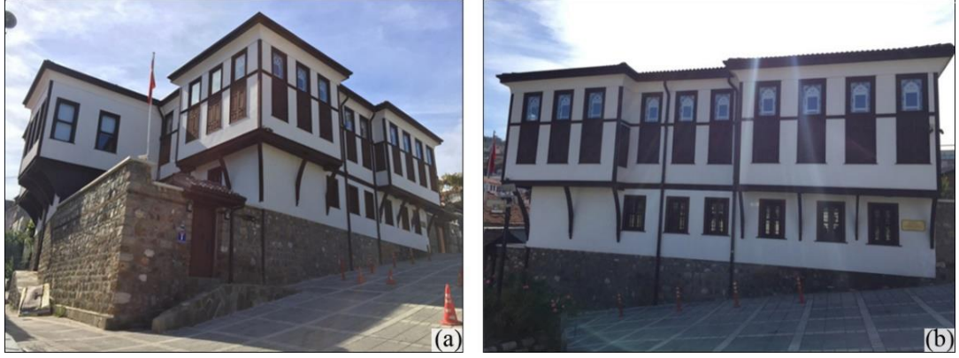
Şekil 3. 80. Tahir Paşa Konağı (a) kuzey batı, (b) batı cephesi
