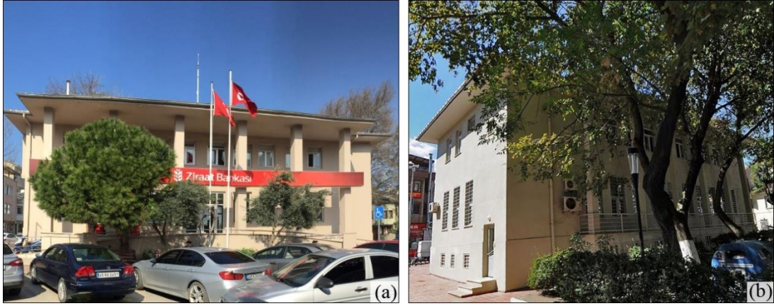
Şekil 3. 103. Ziraat Bankası (a)güneybatı (giriş) cephesi, (b) kuzeydoğu cephesi
