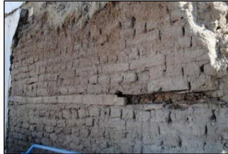
Şekil 3.20. Ahşap hatılın çürümesi (Göktaş 2019 arşivi)
