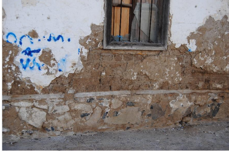
Şekil 3.10. Temel duvarının zemin kata kadar uzatılması (Göktaş 2019 arşivi)
