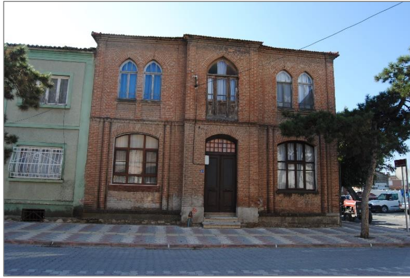
Şekil 3.27. Tuğla duvar yığma sistemli geleneksel konut (Göktaş 2019 arşivi)
