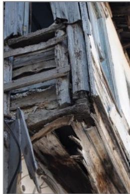
Őekil 3.50. DŐeme kiriŐleri ve dikmelerin baĐlantısı (GktaŐ 2019 arŐivi)
