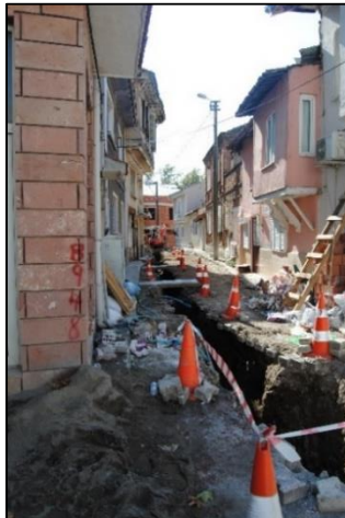
Şekil 2.24. 13.10.2019 Sokak sağlıklaştırma projesi çalışmaları (Göktaş 2019 arşivi)
