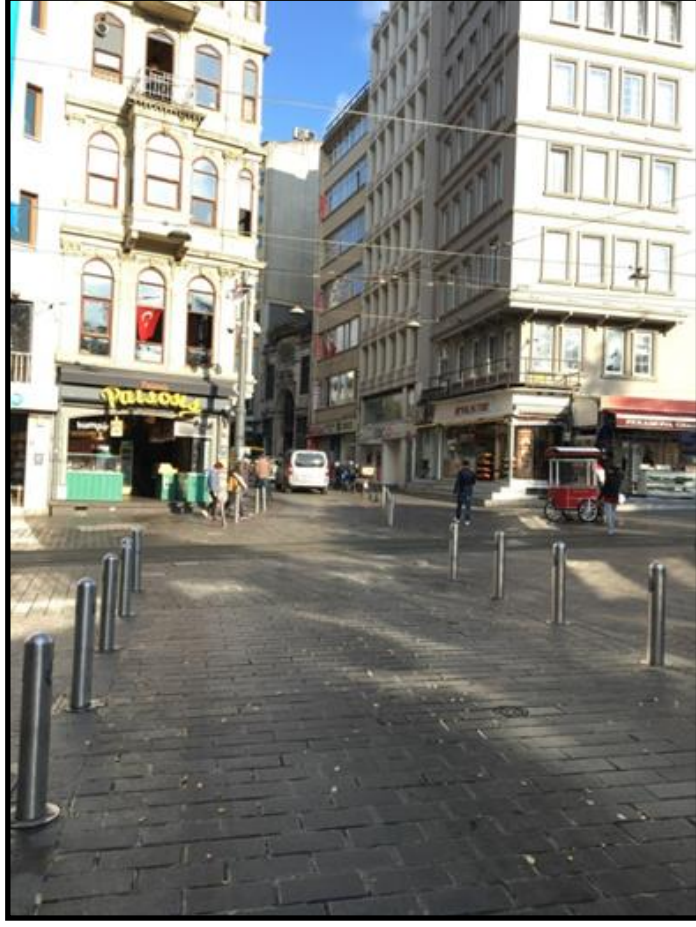
Şekil 4.6. İstiklal Caddesi'ni Yeni Çarşı Caddesi'nden ayıran sınırlama elemanının (duba) görünümü (Pınar ÖZKAN, 2019-Orijinal)
