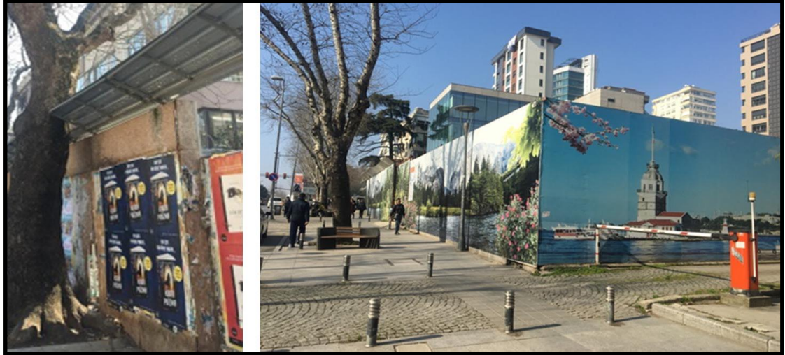
Şekil 4.51. Bağdat Caddesi'de bulunan inşaat alanları ile yaya yolunu birbirinden ayıran sınırlama paneli örneği (Pınar ÖZKAN, 2019- Orijinal)
