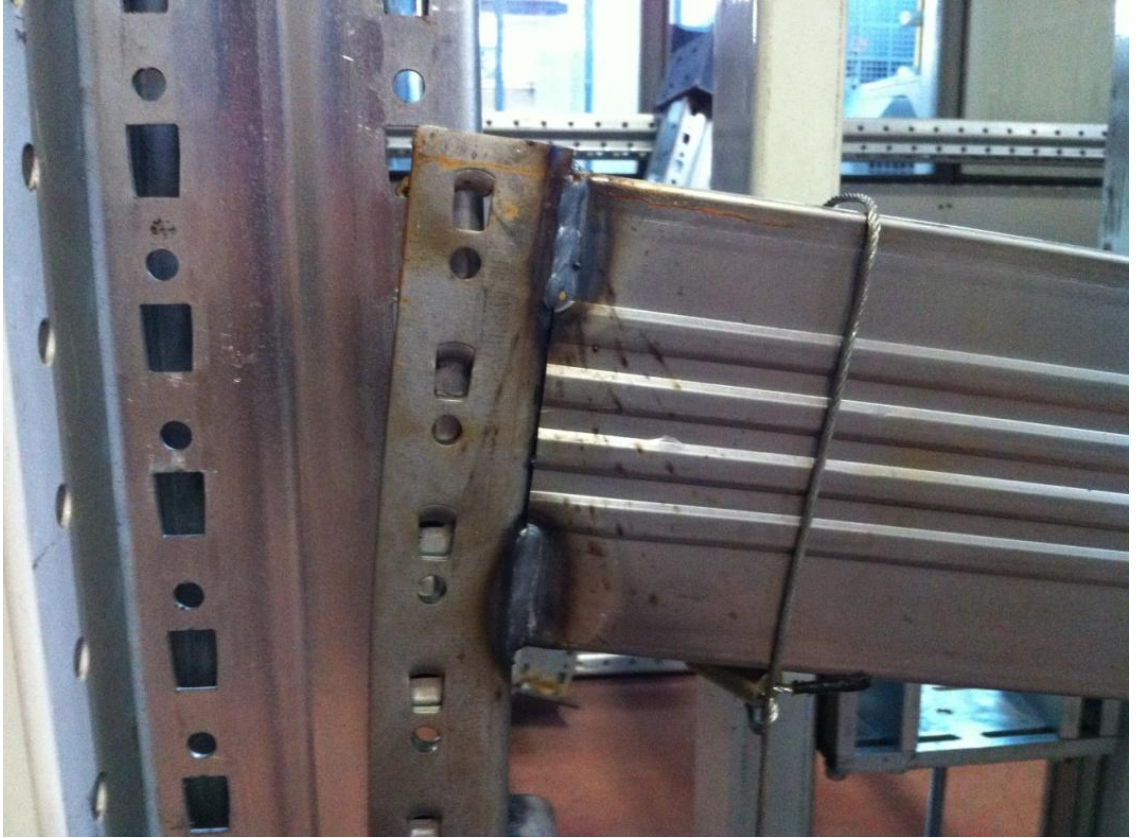
Şekil 4.2. U tipi kaynak yapılan yatay taşıyıcının ön görünüşü
