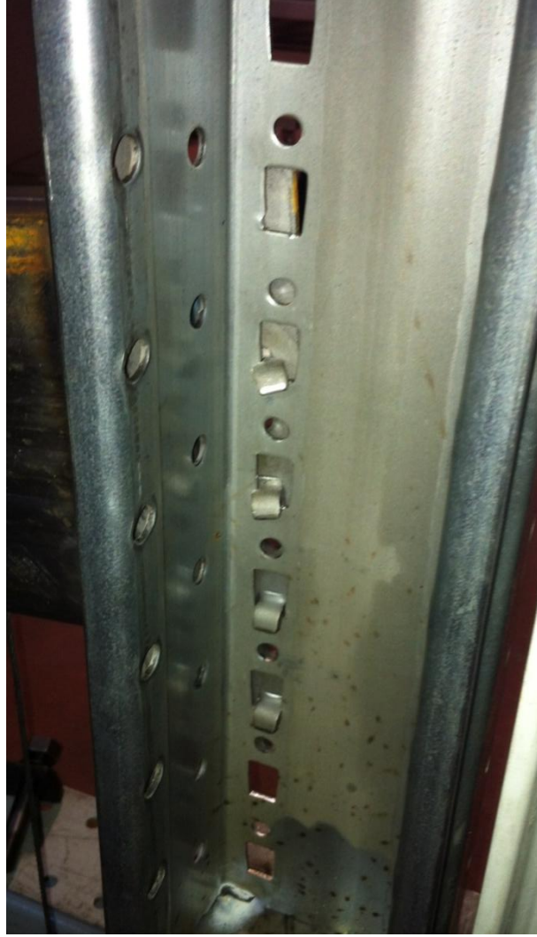
Şekil 4.3. Tırnakların dikey taşıyıcı içinden görünüşü
