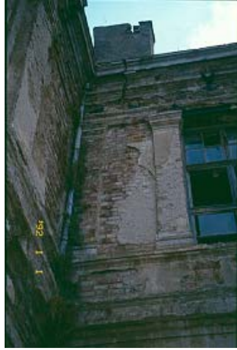
Resim 5: Yapı Çatısındaki Bozulmalar
