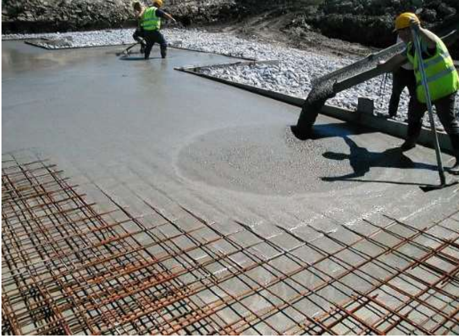
Şekil 2.1. Kendiliğinde Yerleşen Beton Uygulaması
