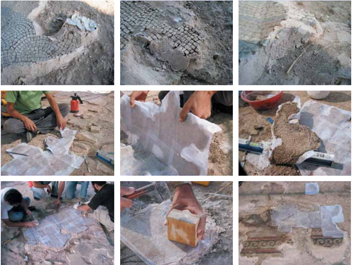
Resim 8 Yatak harcının yenilenmesi, Şanlıurfa-Haleplibahçe mozaikleri (2008)
