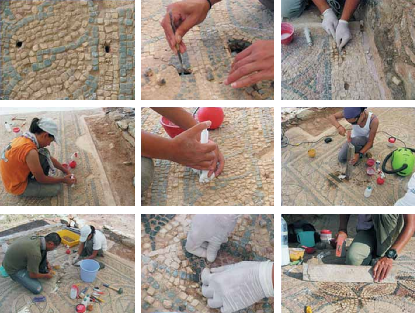
Resim 7 Harç enjeksiyonu ile sağlama işlemi, Bodrum-Torba Mozaikleri (2006)
