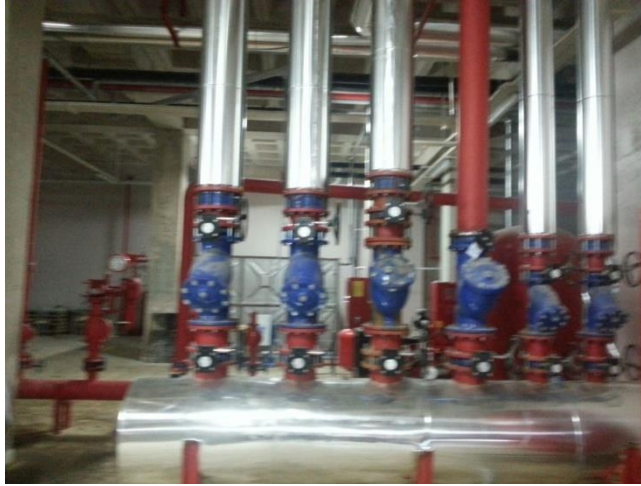
Şekil 4.5. Ortak gidiş kollektörü.
